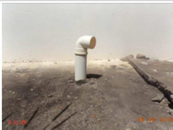
**Foto 84** – RSE-04 (Capivara): tubulação de ventilação inadequada e sem tela de proteção.
