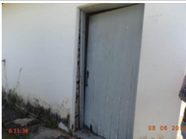
**Foto 96** – EEAT-03 (Capivara): porta danificada e sem fechadura.
