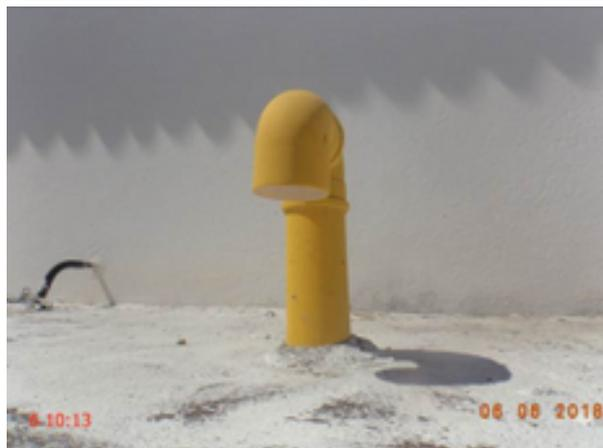
**Foto 82** – RSE-02 (Ideal): tubulação de ventilação sem tela de proteção.
