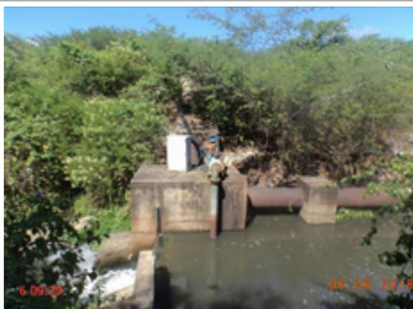
**Foto 117** – EECS-02 (Ideal): ausência de placa indicando que a área é destinada ao abastecimento público/dificuldade de acesso à bomba e ao quadro de comando.
