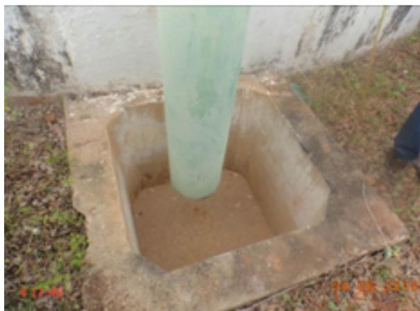
**Foto 39** – RAP-03 (Sede): caixa de inspeção sem tampa ou grade de proteção.
