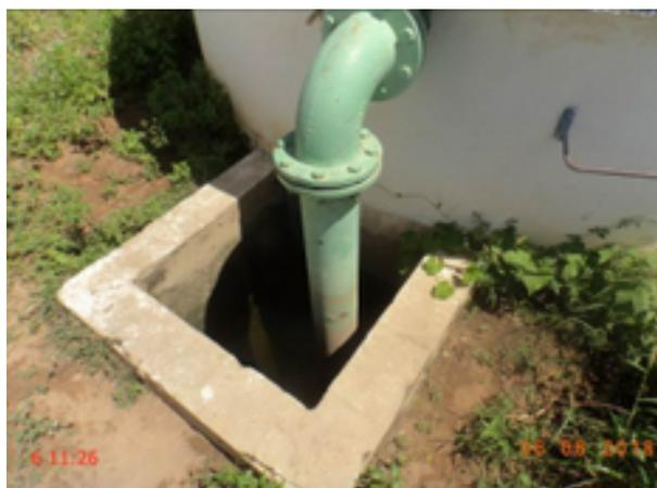
**Foto 85** – RSE-01: caixa de inspeção sem tampa ou grade de proteção.
