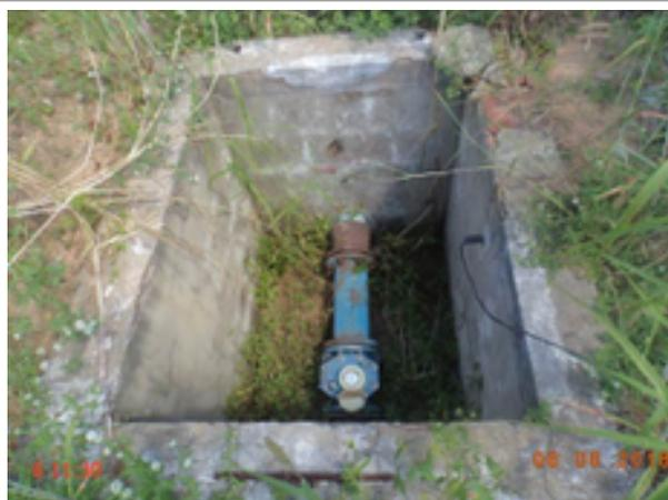
**Foto 90** – REL-02 (Capivara): caixas de inspeção sem tampa ou grade de proteção.
