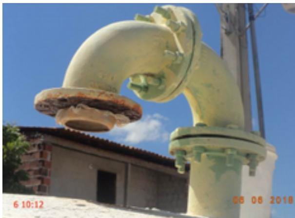
**Foto 81** – RSE-01 (Ideal): tubulação de ventilação sem tela de proteção.
