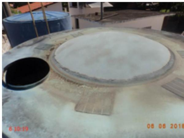
**Foto 80** – ETA/F-01: abertura de inspeção sem tampa.
