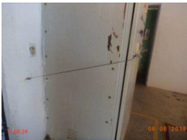
**Foto 97** – EEAT-01 (Ideal): fechadura da porta do quadro de comando danificada.
