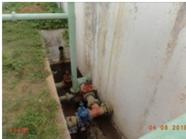
**Foto 40** – RSE-02 (Sede): caixa de inspeção sem tampa ou grade de proteção.
