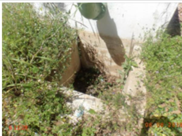
**Foto 88** – RSE-04 (Capivara): caixa de inspeção sem tampa ou grade de proteção.
