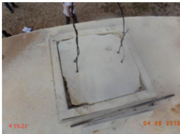
**Foto 26** – RAP-01: tampa de inspeção sem vedação.
