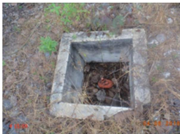
**Foto 41** – REL-02 (Sede): caixa de inspeção sem tampa ou grade de proteção.
