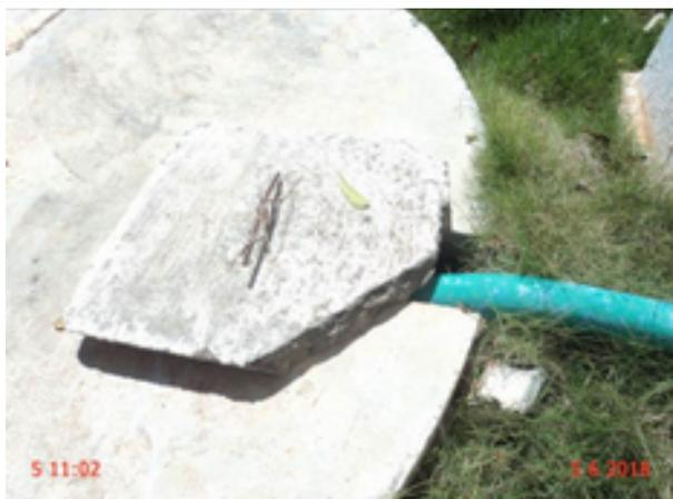
**Foto 25** – RSE-04: tampa de inspeção sem vedação.
