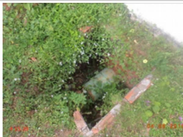
**Foto 20** – ETA (Sede): caixa da estação pitométrica danificada e sem tampa/grade de proteção.
