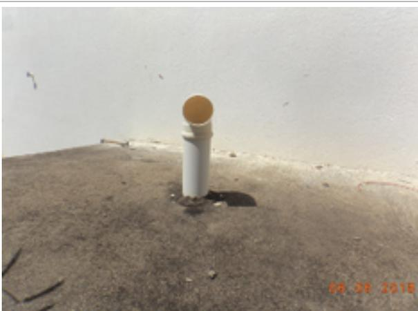
**Foto 108** – RSE-04 (Capivara): tubulação de ventilação inadequada.
