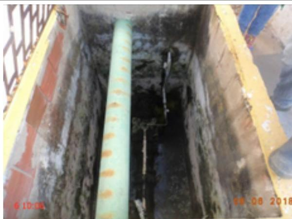
**Foto 78** – ETA (Ideal): acúmulo de água na caixa do macromedidor.
