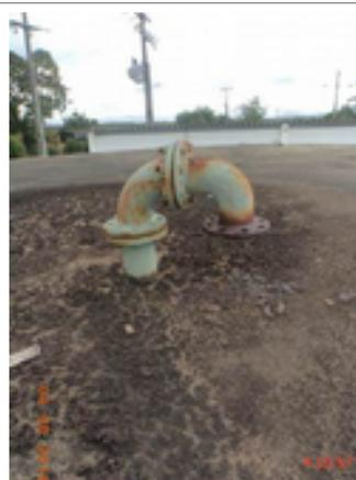
**Foto 32** – RAP-02 (Sede): tubulação de ventilação sem tela de proteção.
