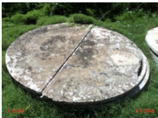
**Foto 30** – RSE-03 (Sede): laje de cobertura danificada/identificação pouco visível.
