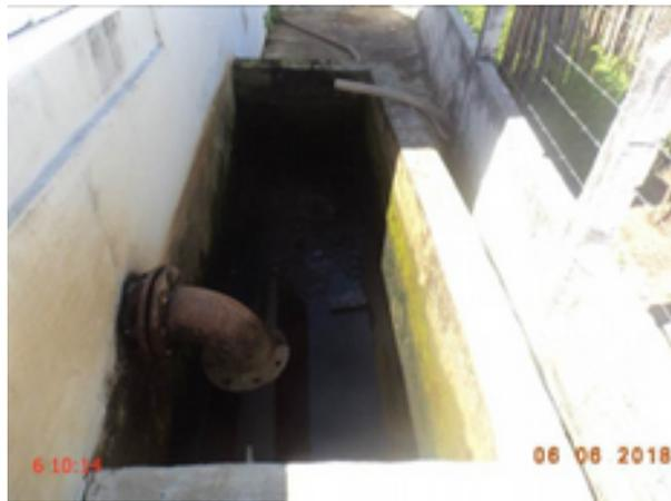
**Foto 86** – RSE-02 (Ideal): caixa de inspeção sem tampa ou grade de proteção.
