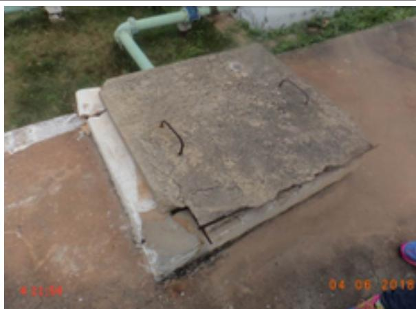
**Foto 29** – RSE-02 (Sede): tampa de inspeção danificada
