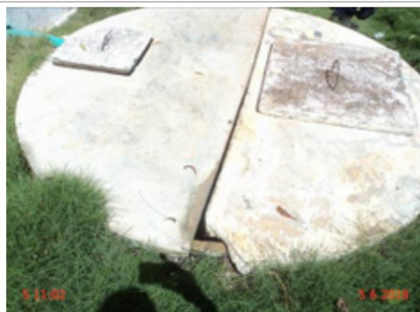
**Foto 31** – RSE-04 (Sede): laje de cobertura danificada/identificação pouco visível.
