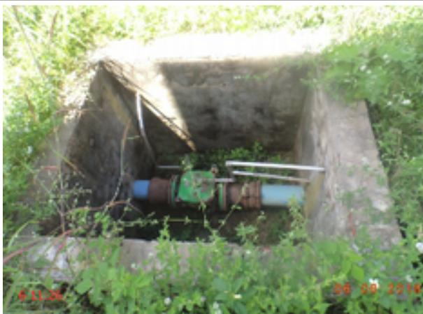
**Foto 87** – RSE-03 (Capivara): caixa de inspeção sem tampa ou grade de proteção.
