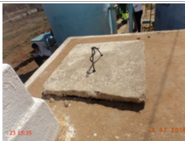
Foto 17 – Reservatórios (Sede): A tampa de inspeção do reservatório RSE-01 não garante vedação.
