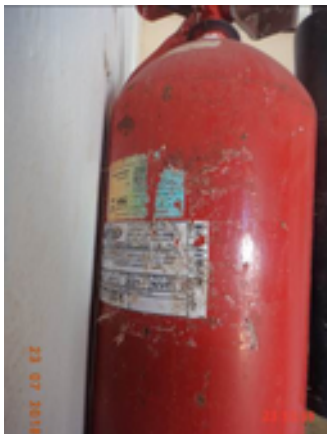
Foto 26 – Elevatórias (Sede): O extintor de incêndio das EEAT-01 e EELF-01 está com a recarga vencida.
