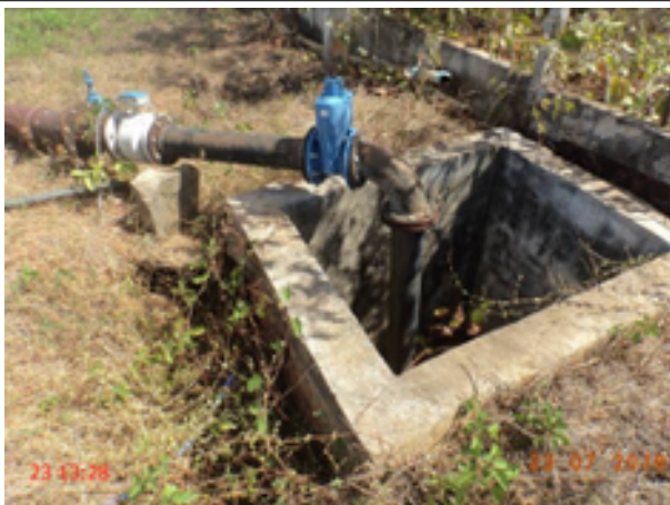
Foto 22 – ETA (Sede): A caixa do macromedidor da adutora de água bruta está sem tampa ou grade de proteção.
