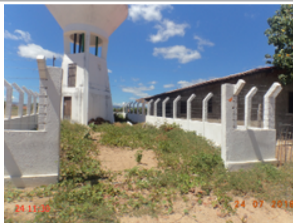
Foto 29 – Reservatório (Campos Belos): O reservatório REL está com a vegetação excessiva e sem portão.
