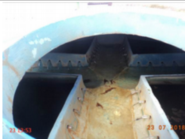
Foto 9 – Filtração (Sede): Os filtros F-1 e F-2 não são dotados de tampa de inspeção.
