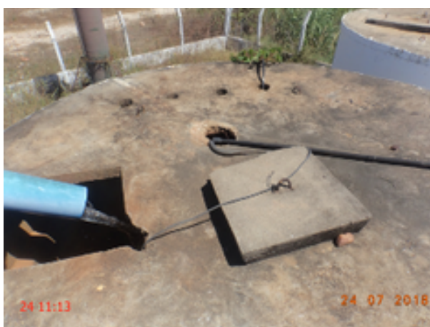
Foto 10 - O reservatório RAP-01 (Campos Belo): não é dotado de tubulação de ventilação e a abertura de inspeção está aberta.
