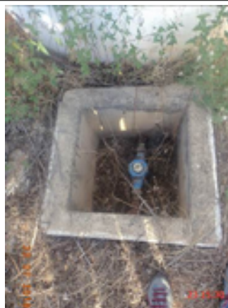
Foto 23 – Reservatório (Sede): A caixa do macromedidor do reservatório REL-01 está aberta.
