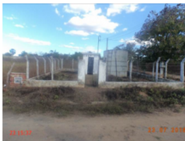
Foto 39 – Reservatório (Sede): O reservatório RAP-02 está com identificação pouca visível.
