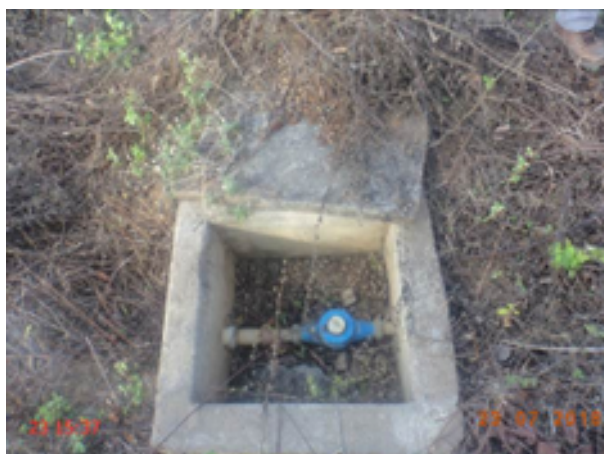
Foto 24 – Reservatório (Sede): A caixa do macromedidor do reservatório RAP-02 está aberta.
