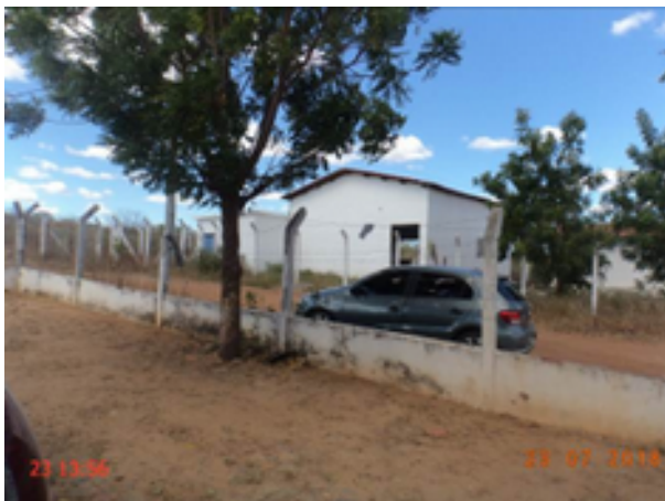
Foto 32 – ETA (Sede): A cerca de delimitação está danificada.
