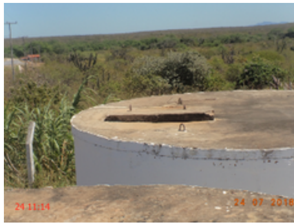
Foto 11 – O reservatório RAP-02 (Campos Belo): não é dotado de tubulação de ventilação e a tampa de inspeção não garante vedação.
