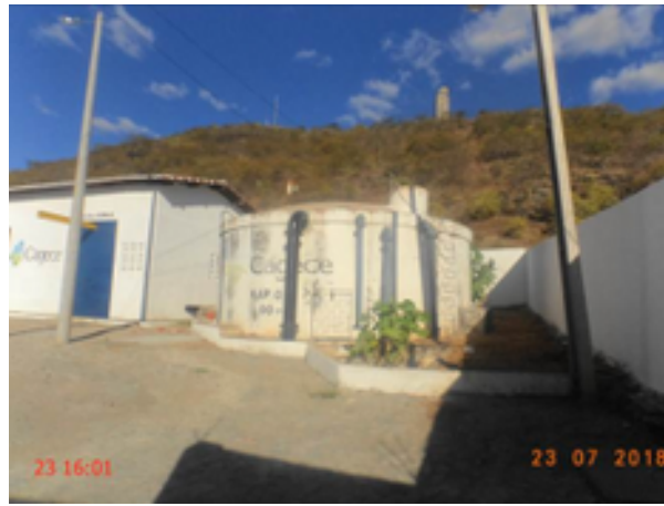
Foto 19 – Reservatório (Sede): RAP-01 pintura deteriorada
