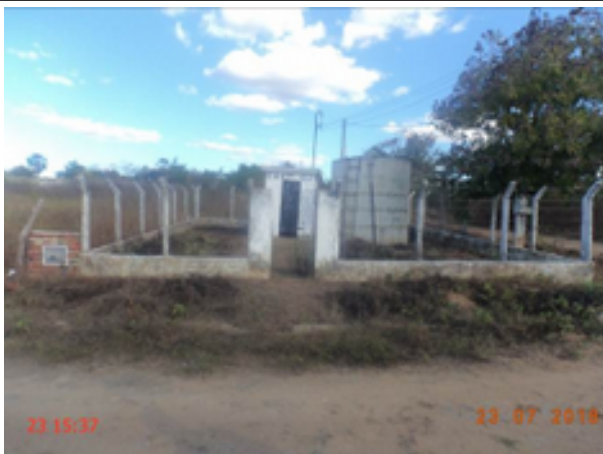
Foto 20 – Reservatório (Sede): O reservatório RAP-02 está com pintura deteriorada, identificação com pouca visibilidade e a área está com vegetação excessiva.
