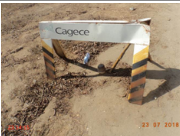
Foto 34 – A ventosa existente na adutora AAT (Sede) não tem caixa de proteção e não consta croqui.
