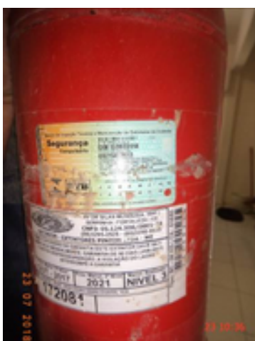
Foto 30 – Almoxarifado (sede): Extintor com a validade vencida.
