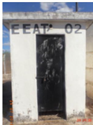
Foto 27 - Elevatória(Sede): A elevatória EEAT – 02 não é dotada de iluminação.
