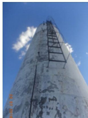
Foto 21 – Reservatório (Sede): A pintura do reservatório REL-01 está deteriorada e não há escada de apoio, para acesso à escada principal.
