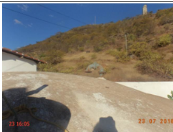
Foto 13 – Reservatório (sede): A tubulação de ventilação do reservatório RAP-01 está sem tela de proteção.
