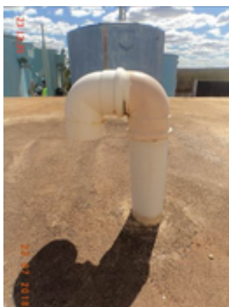
Foto 12 – Reservatório (Sede): A tubulação de ventilação do reservatório RSE-01 está sem tela de proteção.
