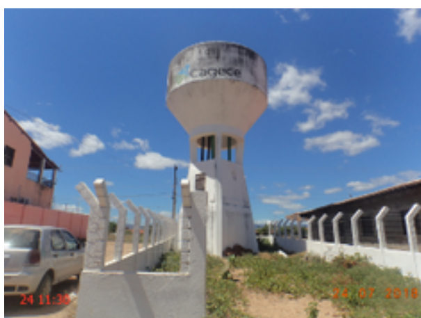
Foto 18 – Reservatório (Campos Belos): O reservatório REL está com a pintura deteriorada.
