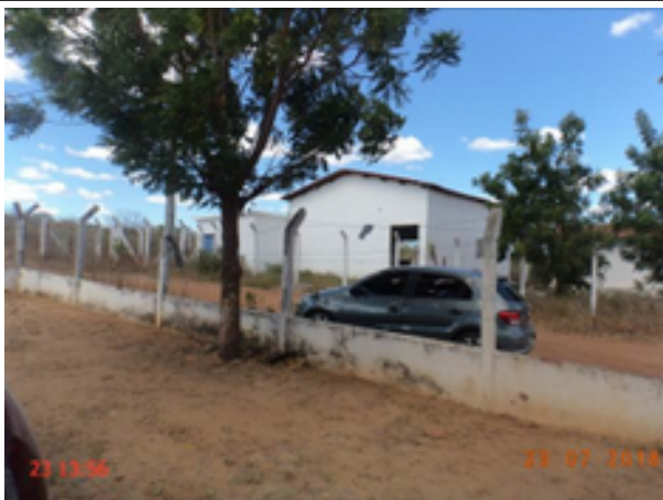
Foto 8 – ETA (Sede): A cerca de delimitação está danificada.
