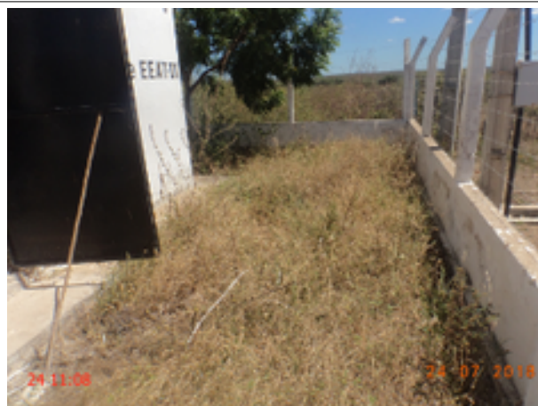
Foto 28 - Reservatório (Campos Belos): A área do reservatórios RAP-01, RAP-02 e elevatória EEAT-01 está com vegetação excessiva.
