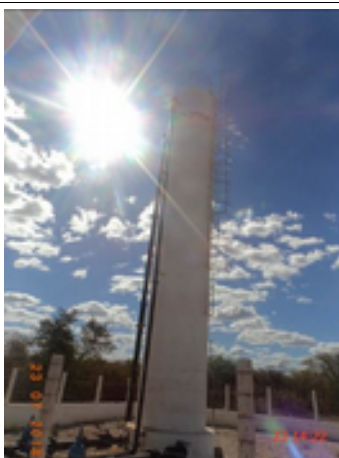
Foto 36 - O TAU: existente na adutora AAT (Sede) não consta no croqui.
