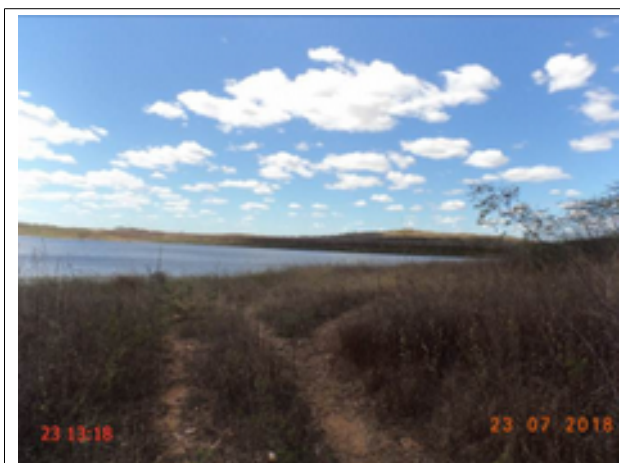
Foto 37 – Captação (Sede): Sem identificação de área destinada ao abastecimento público.
