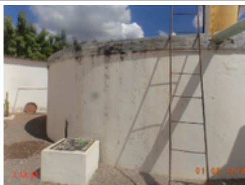
Foto 10 – Reservatório: O reservatório RAP-01 está com a pintura deteriorada e apresenta rachaduras em sua estrutura.
