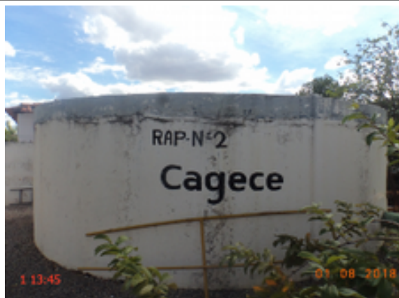
Foto 11 –Reservatório: O reservatório RAP-02 está com a pintura deteriorada e apresenta rachaduras em sua estrutura.
