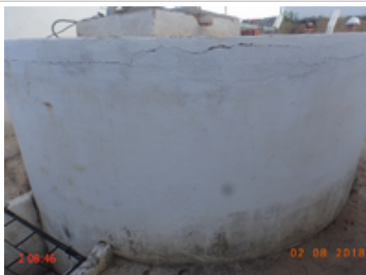
Foto 9 – Reservatório: O reservatório RAP-03 está sem identificação, com a pintura deteriorada e apresenta rachaduras em sua estrutura.
