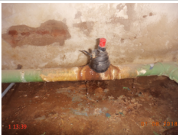
Foto 7 – Elevatória: A elevatória EEAT-02 está com vazamento na tubulação.
