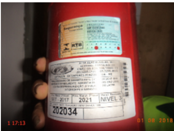
Foto 27 – Comercial: O extintor do escritório/loja de atendimento da CAGECE está com a validade vencida.
