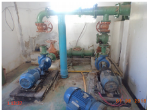
Foto 3 – Elevatória: A elevatória EEAT-01 não está com a bomba reserva instalada.
