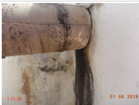
Foto 15 – ETE: Existe vazamento no encontro da tubulação com o poço de visita.
