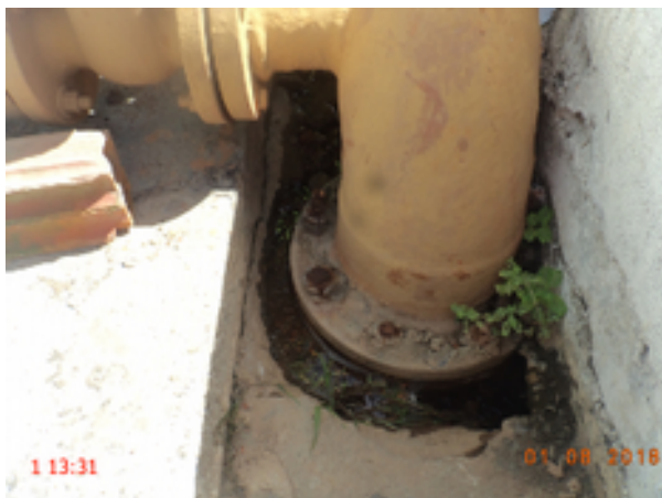
Foto 25 – ETA: O registro do filtro F-02 apresenta vazamento.
