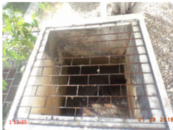
Foto 20 – ETA: A grade da caixa de passagem da ETA está em processo de corrosão.
