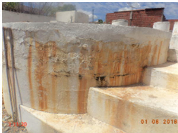
Foto 17 – ETE: Os filtros estão com a pintura deteriorada, apresentam rachaduras e estão sem identificação.
