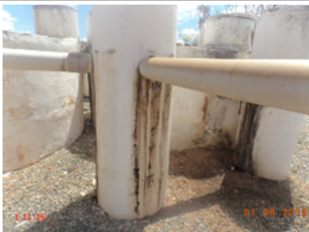
Foto 13 – ETE: Os poços de visita da ETE estão sem identificação, com a pintura deteriorada e apresentam sinais de vazamento.
