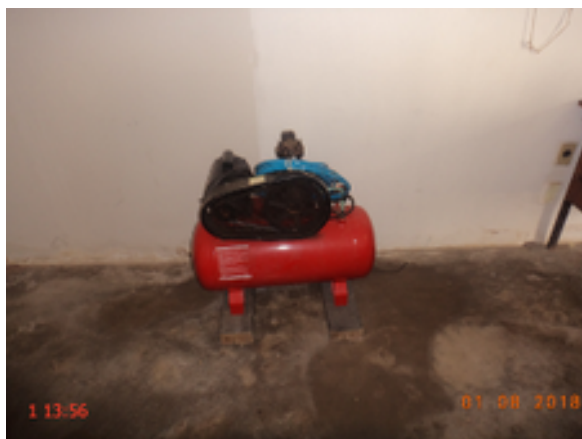
Foto 19 – ETE: O compressor de ar não está instalado na ETE.
