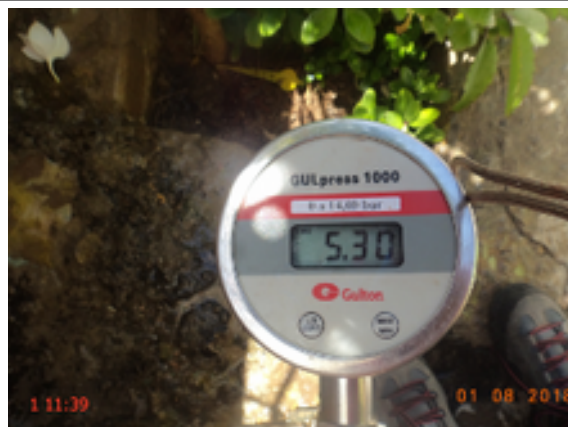
Foto 2 – RDA: medição instantânea de pressão no endereço Rua Terezinha Santos, 262.
