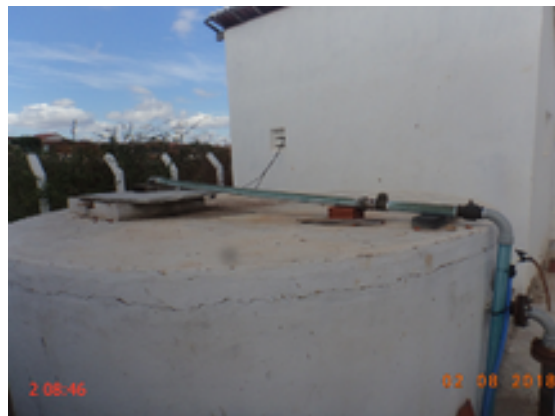
Foto 4 – Reservatório: O reservatório RAP 03 está sem a tubulação de ventilação e a laje está côncava, podendo acumular água em período de chuvas.
