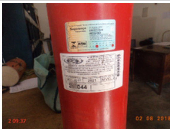
Foto 8 – Almoarifado: O extintor do almoarifado da CAGECE está com a validade da recarga vencida.
