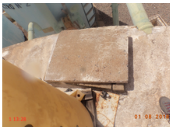
Foto 21 – Reservatório: A tampa de inspeção do RAP-01 não garante vedação.
