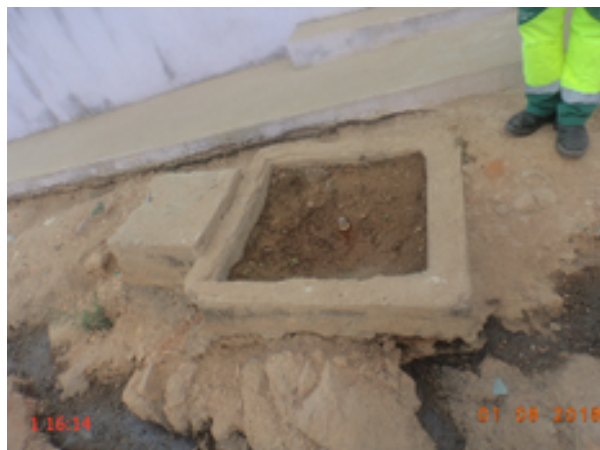
Foto 24 – RDA: O registro de descarga da Rua Francisco Adauto dos Santos está sem tampa.
