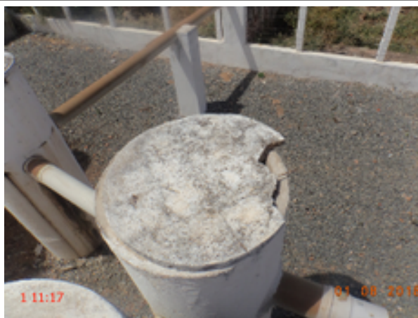
Foto 14 – ETE: O poço de visita da ETE está com a tampa deteriorada.
