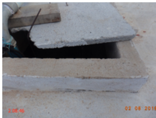
Foto 22 – Reservatórios: A tampa de inspeção do RAP-03 não garante vedação.
