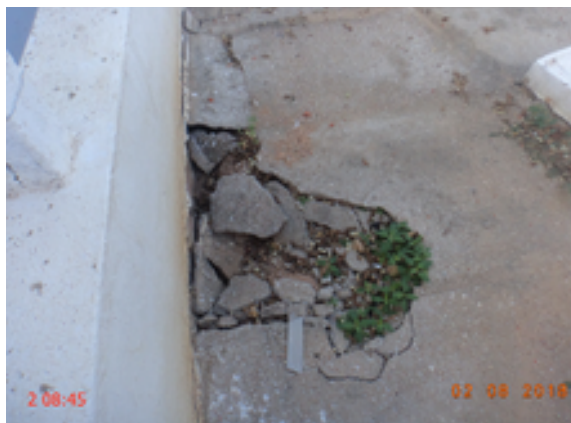
Foto 5 – Reservatório: A área do reservatório RAP-03 apresenta pavimento danificado.
