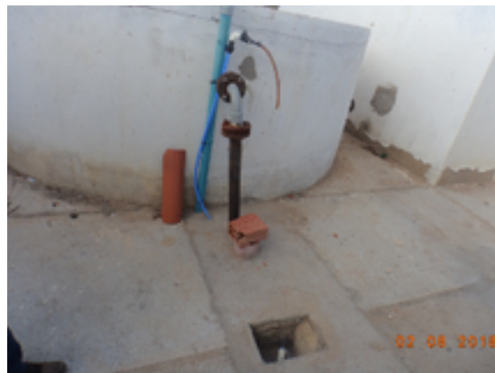
Foto 6 – Reservatório: caixa de passagem com a tampa inadequada.
