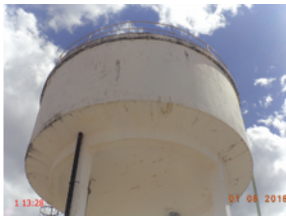
Foto 12 – Reservatório: O reservatório REL está com a pintura deteriorada e apresenta rachaduras em sua estrutura.
