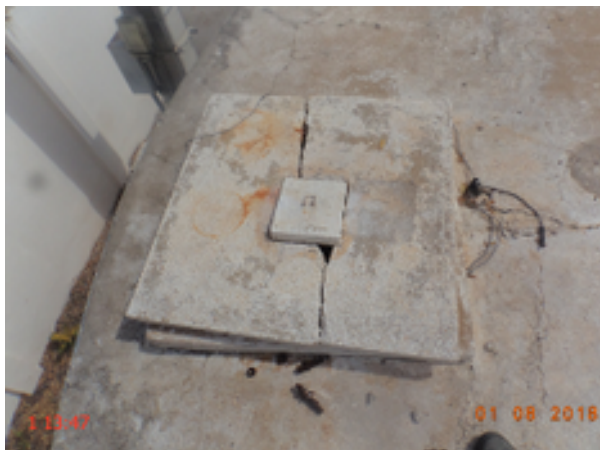
Foto 23 – Reservatório: A tampa de inspeção do RAP-02 está deteriorada.
