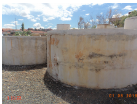
Foto 16 – ETE: Os decanto digestores estão com a pintura deteriorada, apresentam rachaduras e estão sem identificação.
