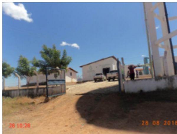
Foto 30 – ETA: Ausência de placa indicativa de que aquela área pertence a CAGECE.
