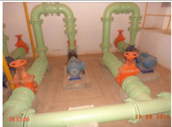
Foto 11 - Elevatórias: EEAT-05 sem identificação.
