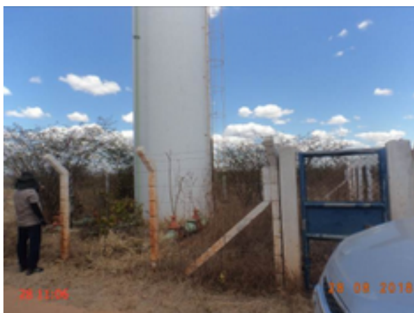
Foto 31 – AAT: TAU sem identificação e presença de vegetação excessiva.
