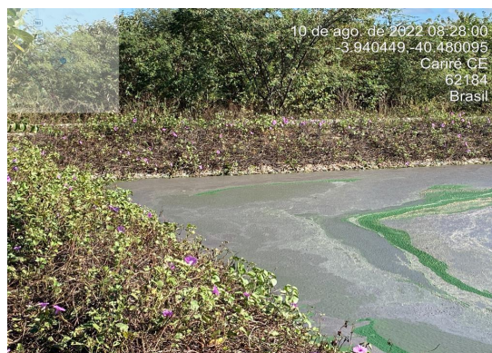
Foto 13 - ETE: obstrução da saída esquerda da lagoa facultativa, ocasionando acúmulo de sobrenadantes.
