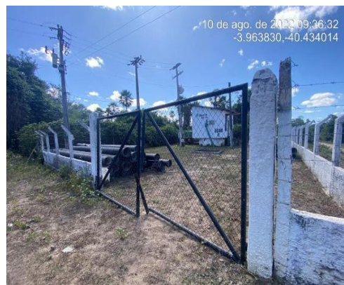
Foto 3 - Captação: objeto de vandalismo.
