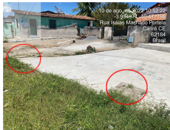
Foto 15 - Rede/esgoto: ligações na rede de esgoto sem a mesma está interligada a CAGECE.
