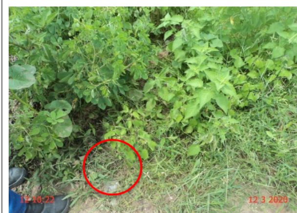
Foto 14 – RDA: registro de descarga soterrado, localizado no endereço Rua São Francisco.
