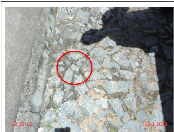
Foto 12 – RDA: registro de descarga soterrado, localizado no endereço Rua Celso Patrício.
