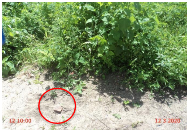
Foto 9 – RDA: registro de descarga soterrado, localizado no endereço Rua Professora Naninha.
