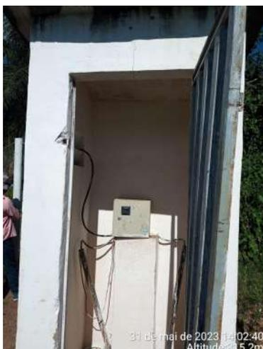
**Foto 19 -PT-02 (Sede):** instalações do quadro de comando e da fiação elétrica precárias e abrigo sem iluminação interna.
