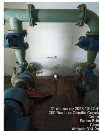
**Foto 14** - EEAT-01 (Sede): bombas da estação estão com vazamentos e/ou falha na drenagem, cujas águas extravasam sobre o piso da estação elevatória.
