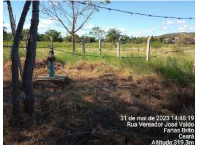
**Foto 24** - PT-09 (Sede): área tomada por vegetação e cerca de isolamento da área do poço está danificada.
