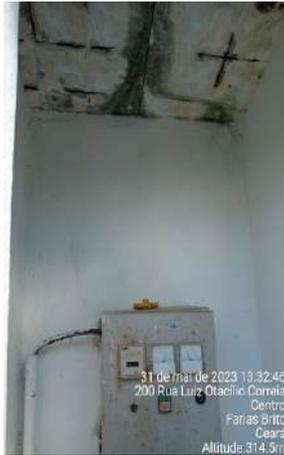
**Foto 5 - PT-05 (Sede):** Laje da casa do quadro de comando com ferragem corroída e exposta.
