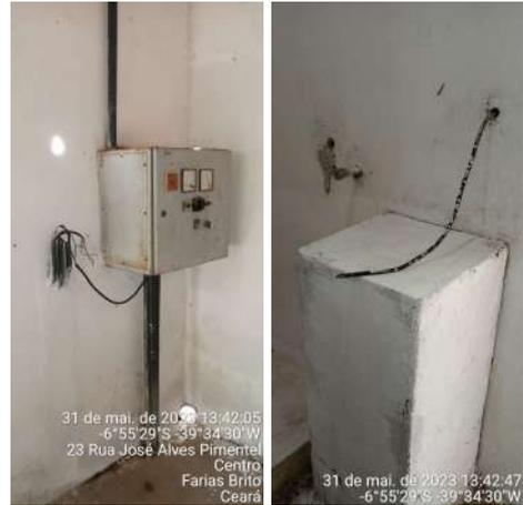
**Foto 12** - EELF-01 (Sede): instalações elétricas inadequadas e sem o devido isolamento.
