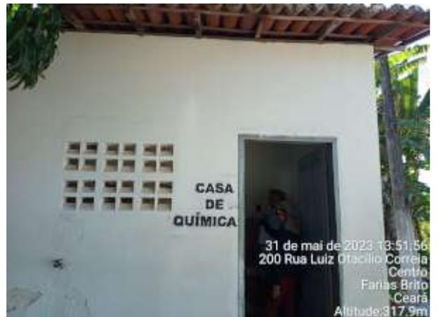
**Foto 8 - ETA (Sede):** infraestrutura da casa de química está degradada e com o reboco deteriorado.
