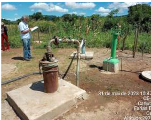
**Foto 33 - PT-02 e PT-03 (Cariutaba):** instalação elétrica inadequada sobre o solo.
