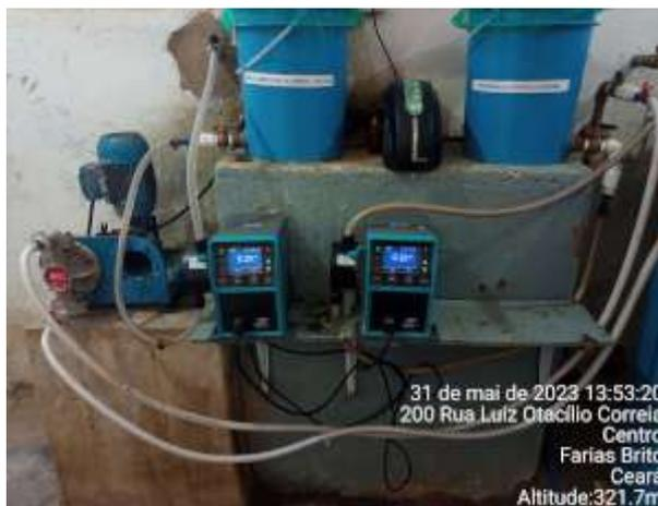
**Foto 9 - ETA (Sede):** infraestrutura da casa de química está degradada e com o reboco deteriorado.
