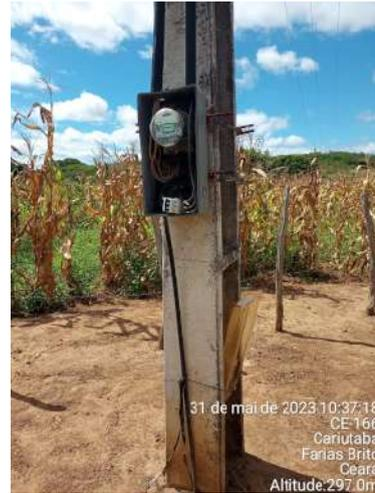
**Foto 30 - PT-01 (Cariutaba):** quadro de alimentação do poço em estado precário.
