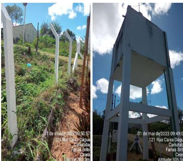
**Foto 27** - REL-01 (Cariutaba): pintura desgastada, sem identificação e cerca de isolamento da área necessitando de recuperação.
