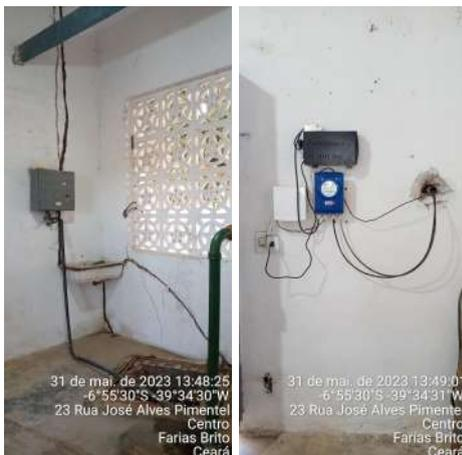
**Foto 15** - PA-01 (Sede): instalações inadequadas sem eletrodutos ou eletroduto instalado sobre o piso.
