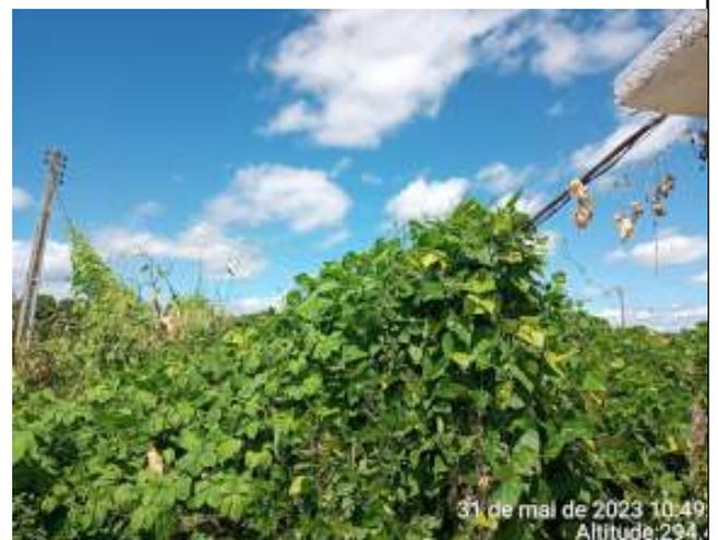
**Foto 34 - PT-02 e PT-03 (Cariutaba):** cabo de alimentação elétrica em altura inadequada (baixa) e sofrendo ação de vegetação.
