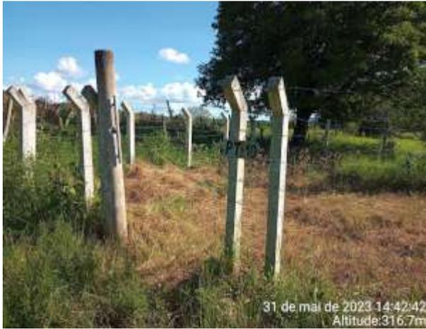
**Foto 23** - PT-10 (Sede): área tomada por vegetação, cerca de isolamento da área do poço está danificada e entrada aberta, permitindo acesso.
