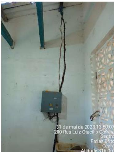
**Foto 17 - PA-01 (Sede):** edificação precisando de manutenção e limpeza (cupins na parede).
