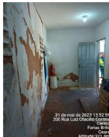
**Foto 10 - ETA (Sede):** infraestrutura da casa de química está degradada e com o reboco deteriorado.
