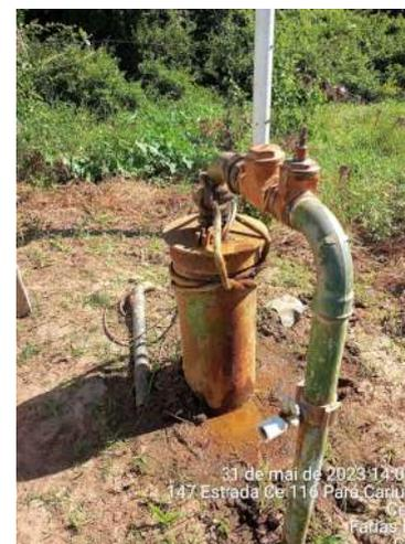
**Foto 20 - PT-02 (Sede):** falta laje de proteção.
