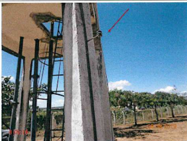
Foto 16 – REL-01: Ausência de proteção mecânica no para-raio.
