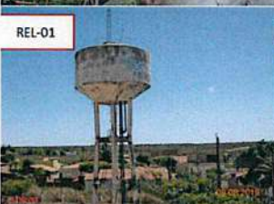
Foto 21 – Reservatórios: Pintura deteriorada dos reservatórios RAP-01, RAP-02, REL-01 e REL-03.
