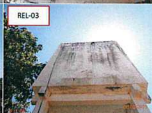
Foto 21 – Reservatórios: Pintura deteriorada dos reservatórios RAP-01, RAP-02, REL-01 e REL-03.
