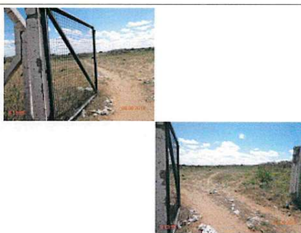
Foto 9 – ETE: Portão danificado e ausência de identificação.
