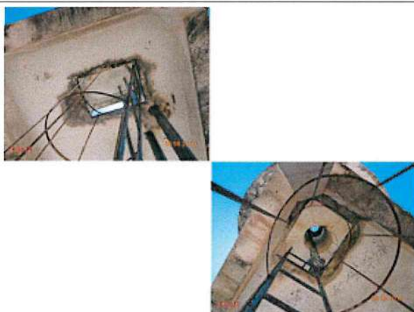
Foto 12 – PA-02: Pintura e estrutura deteriorada, identificação pouco visível.
