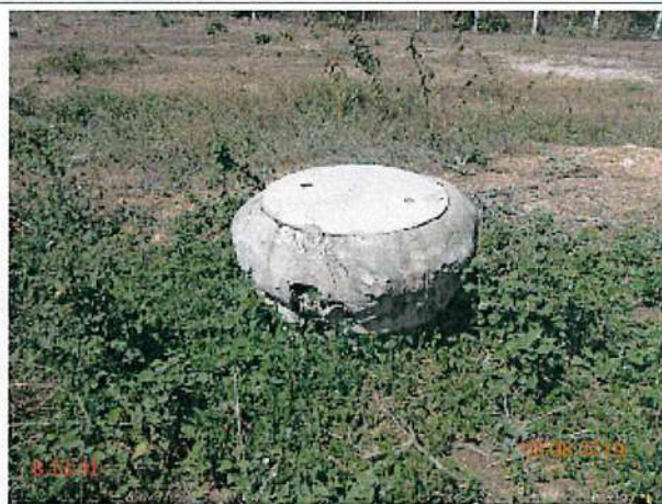
Foto 19 – ETE: Poço de visita apresenta estrutura deteriorada.
