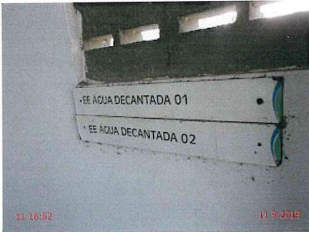
Foto 76 – EEAB-02 (Sede): identificação diferente do croqui.
