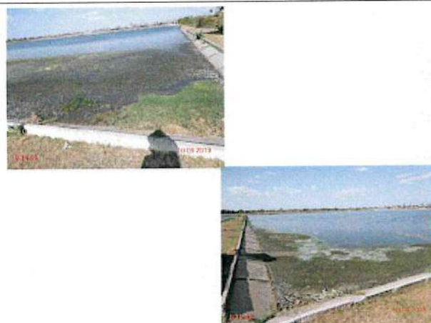
Foto 54 – Lagoa de Maturação (2) (Sede): presença de sobrenadantes.
