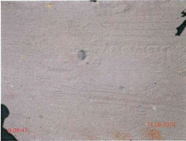
Foto 44 – RDA (Flores): Registro de descarga soterrado na R. Antonio Sabino, 1356.
