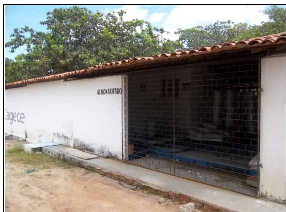
Foto 5 – Almoxarifado de produtos químicos da UNBCL.
