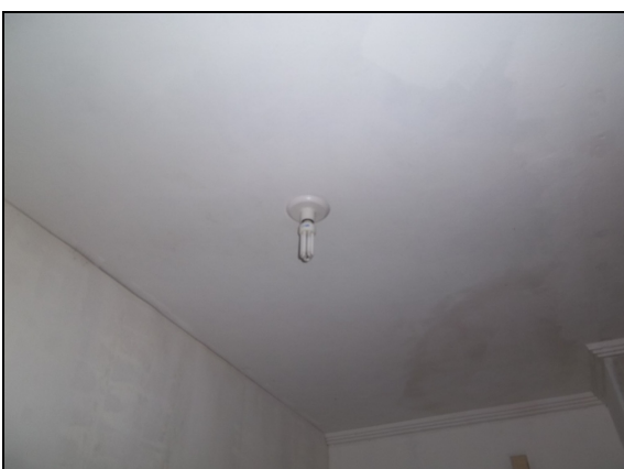
Foto 12 – Lâmpada queimada do escritório operacional do SAA de Itapipoca.
