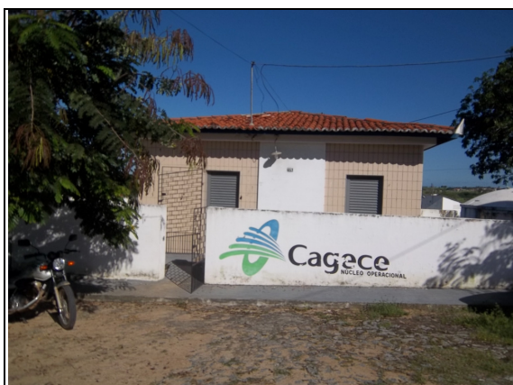
Foto 73 – Fachada principal do escritório operacional/atendimento do SAA de Pentecoste.
