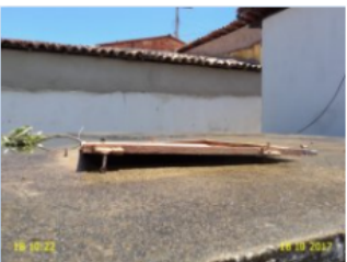
Foto 17 – RAP-01 e RAP-02: tampa de inspeção em processo de corrosão e sem vedação adequada.
