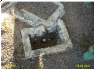
Foto 17 – RAP-01 e RAP-02: tampa de inspeção em processo de corrosão e sem vedação adequada.
