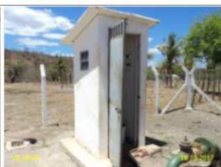
Foto 21 – Casa de química: lâmpada queimada e piso deteriorado.
