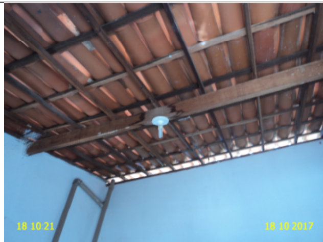
Foto 20 – EEAT-02: lâmpada apagada.
