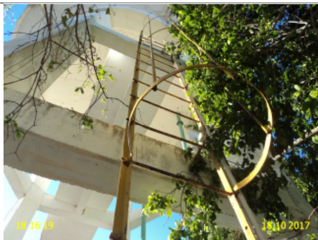
Foto 16 – REL-01: escada em processo de corrosão.
