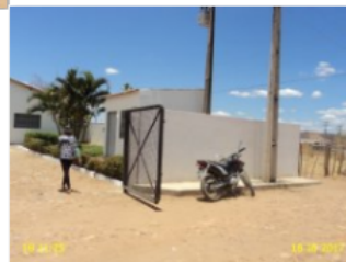
Foto 18 – ETA: ausência de identificação.
