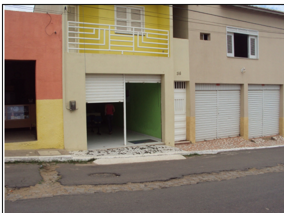
Foto 61 – Escritório/atendimento provisório do SAA de Várzea Alegre.
