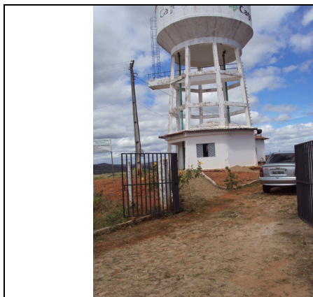
Foto 47 – Ausência de placa indicativa de funcionamento do escritório/atendimento do SAA de Mangabeira.
