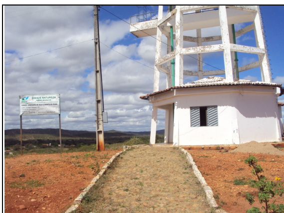
Foto 45 – Escritório operacional/atendimento do SAA de Mangabeira.
