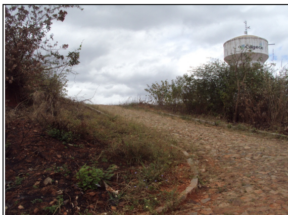
Foto 49 – Localização e acesso inadequado do escritório/atendimento do SAA de Mangabeira.
