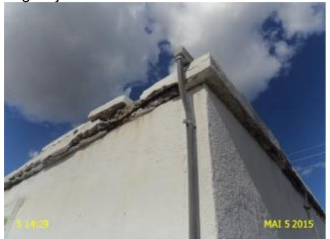
**Foto 9** – RAP-02: estrutura deteriorada.
