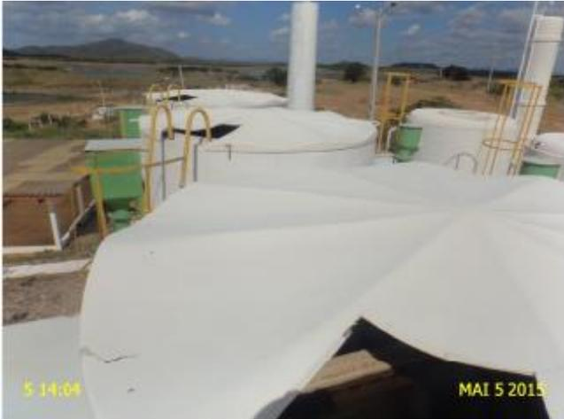
**Foto 6** – Filtração: tampas sem fechamento adequado.
