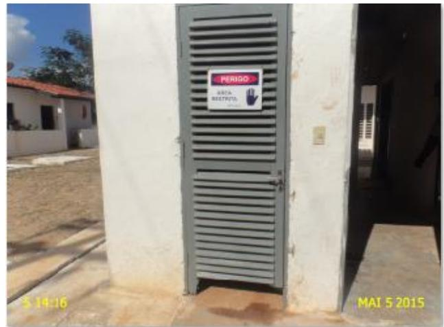
**Foto 3** – ETA: porta da casa de cloro gasoso deteriorada.
