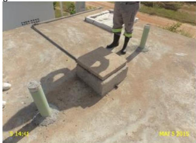
**Foto 5** – RAP-02: tubulações de ventilação fechadas.
