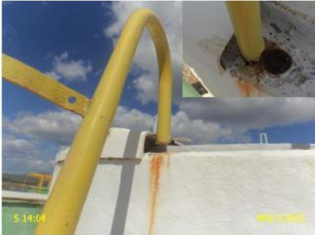
**Foto 10** – Filtro F-03: escada sem fixação adequada.
