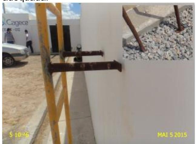
**Foto 15** – RAP-03: escada sem fixação adequada.
