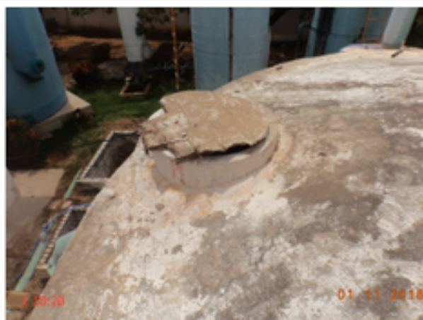
Foto 7 – RAP-01 (Pavuna): tampa deteriorada e não garante vedação.
