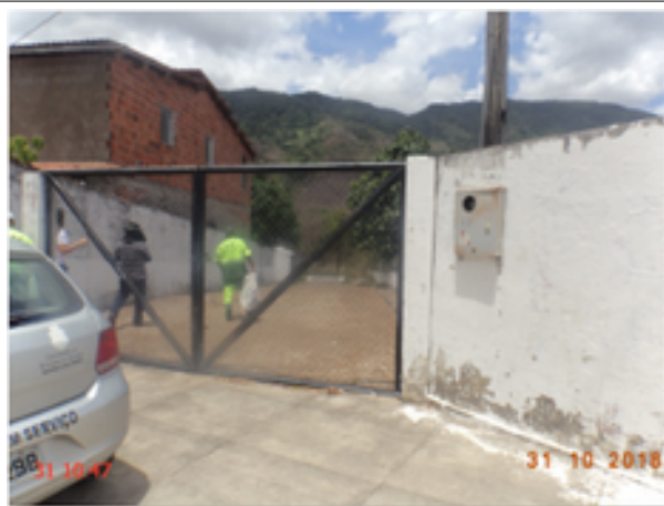
Foto 9 – EEE-01 (Alto São João) (Sede): ausência de identificação.
