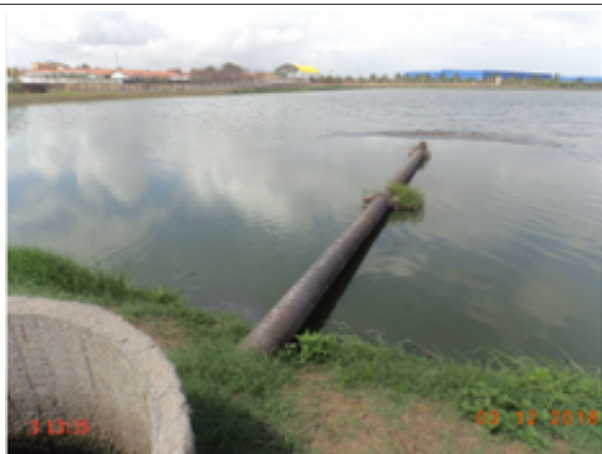
Foto 10 – ETE (Sen. Carlos Jereissati): banco de areia na chegada do esgoto bruto na lagoa.
