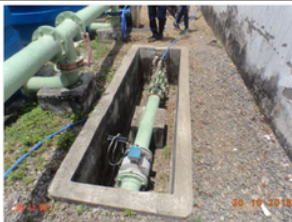
Foto 13 – AAT (Sede): ausência de tampa ou grade de proteção.
