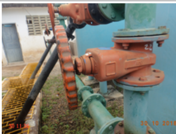
Foto 39 – Filtro FP-02 (Sede): registro com vazamento.
