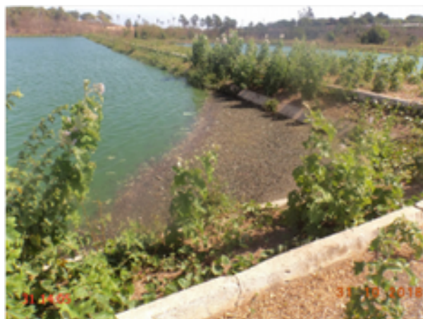
Foto 19 – ETE (Sede): lagoa de maturação com sobre-nadantes.
