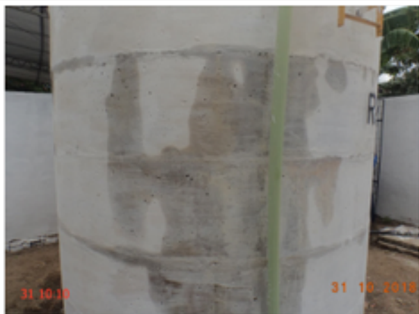
Foto 6 – RAP-01 (Sede): apresenta sinais de vazamento.
