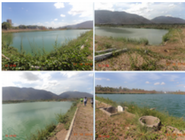
Foto 18 – ETE (Sede): taludes das lagoas facultativa e maturação estão com vegetação excessiva
