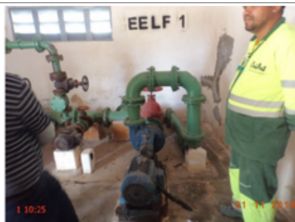
Foto 4 – EELF-01 (Pavuna): ausência de bomba reserva.
