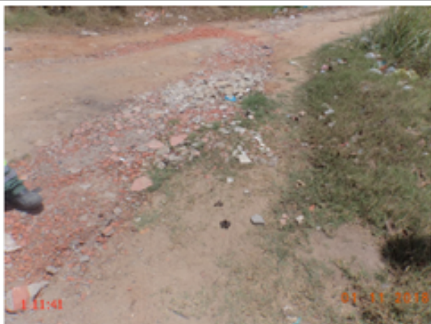
Foto 32 – RDA (Pavuna): registro de descarga soterrado na Rua Anjo Gabriel, nº 216.
