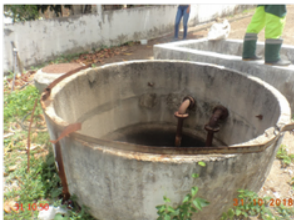
Foto 24 – EEE-01 (Alto São João) (Sede): poço de sucção sem tampa.
