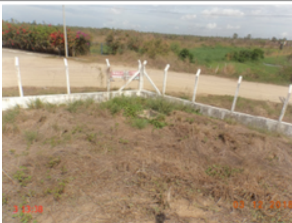
Foto 17 – ETE (Sen. Carlos Jereissati): poço de visita sem tampa.
