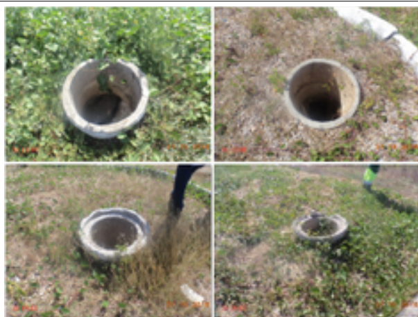
Foto 16 – ETE (Sede): poços de visita sem tampa de inspeção.
