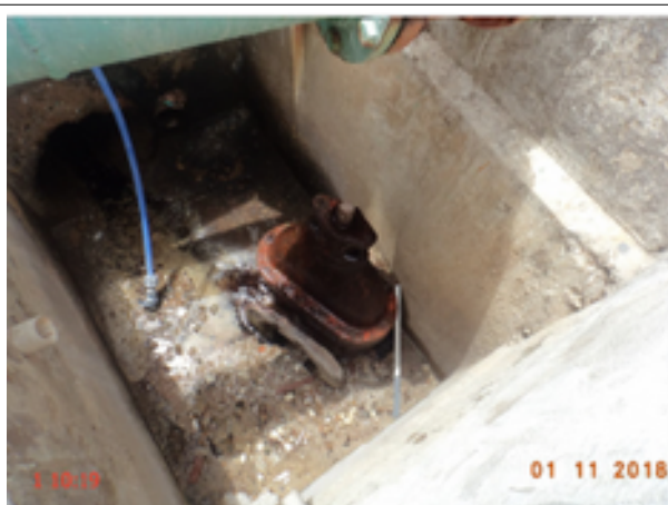
Foto 11 – RAP-01 (Pavuna): registro com vazamento
