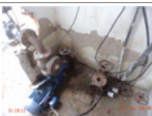
Foto 1 – EEE-01 (Alto São João) (Sede): ausência de gradeamento.
