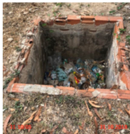
Foto 23 – ETA (Sede): caixa sem tampa ou grade de proteção.
