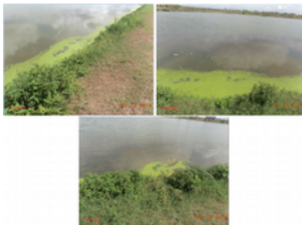
Foto 21 – ETE (Sen. Carlos Jereissati): presença de vegetação e acúmulo de sobre-nadantes na lagoa facultativa.
