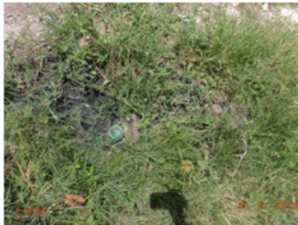
Foto 31 – RDA (Pavuna): registro de descarga soterrado na Rua Senador Pompeu, s/n.
