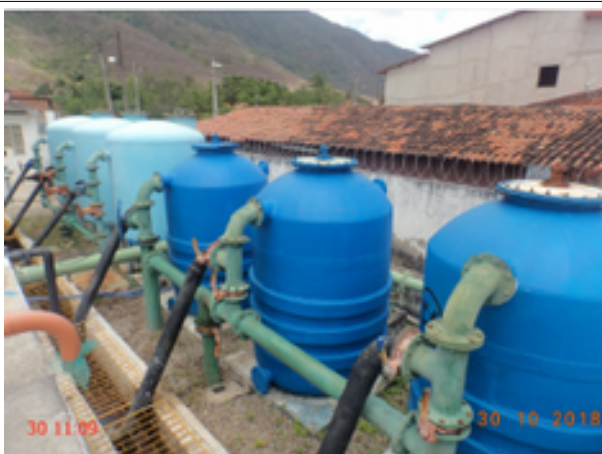
Foto 5 – Filtros (Sede): ausência de escada de acesso.
