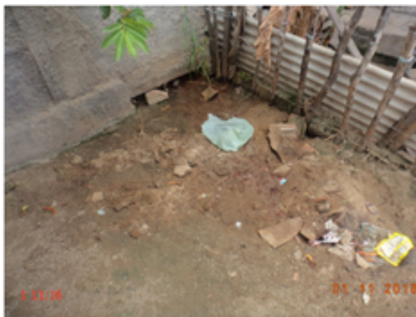
Foto 29 – RDA (Pavuna): registro de descarga soterrado na Rua São José, nº 444.
