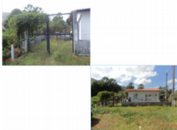
Foto 35 – EERD-02 (São Luís): excesso de vegetação, portão danificado e pintura deteriorada.
