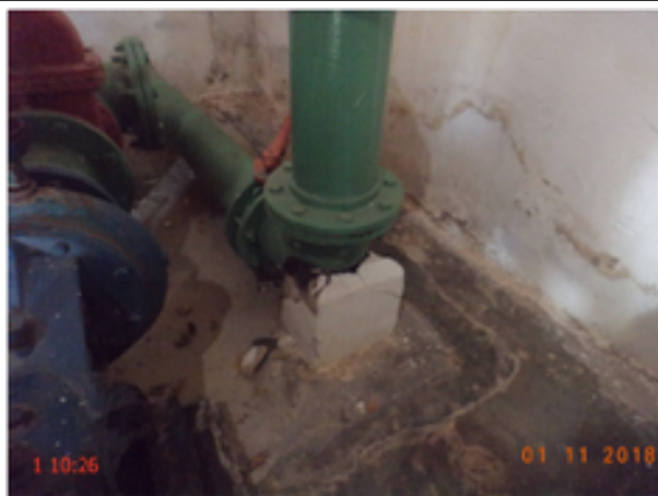
Foto 36 - EELF-01 (Pavuna): estrutura de ancoragem da linha de recalque está deteriorada.
