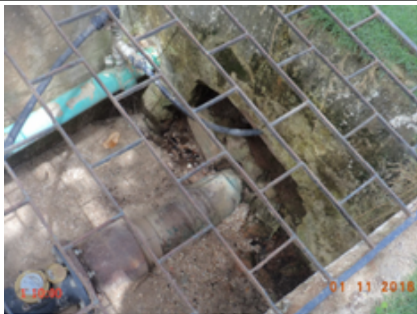
Foto 12 – AAB (Pavuna): caixa danificada.
