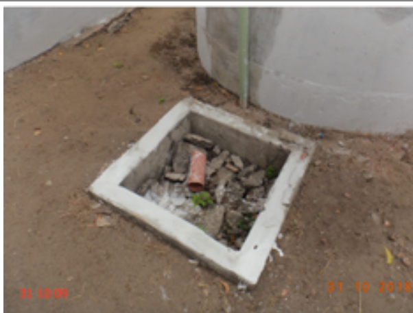
Foto 8 – RAP-01 (Sede): caixa sem tampa ou grade.
