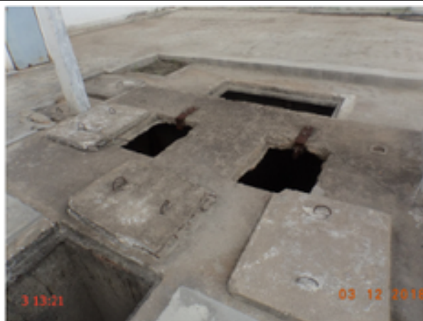
Foto 25 – EEE-01 (Sen. Carlos Jereissati): poço de sucção não está devidamente tampado.
