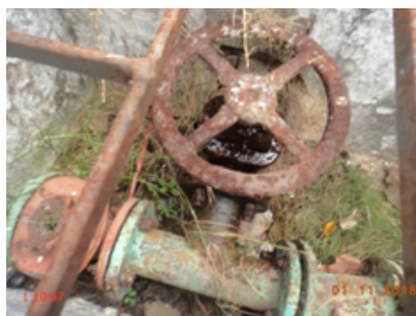
Foto 14 – AAT (Pavuna): registro com vazamento.
