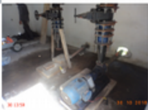
Foto 3 – EERD-01 (Parque Quandú) e EERD-02 (São Luís): ausência de bomba reserva.
