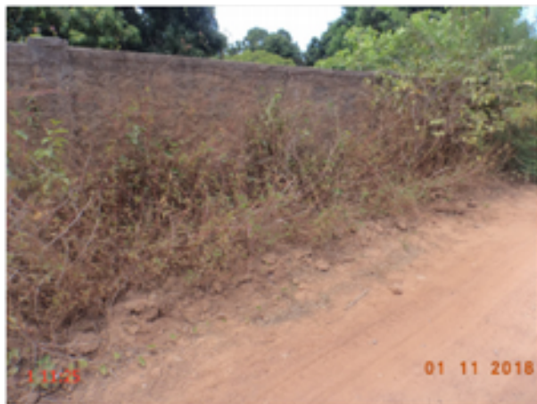
Foto 30 – RDA (Pavuna): registro de descarga soterrado na Rua São João, nº 720.
