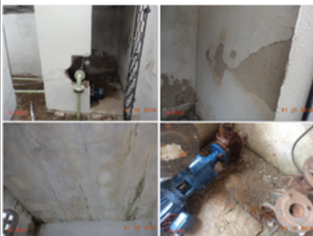
Foto 34 – EERD-01 (Parque Quandú): casa de abrigo com rachaduras, pintura, reboco e piso deteriorados.
