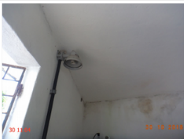
Foto 38 – EEAT-01 (Sede): ausência de iluminação
