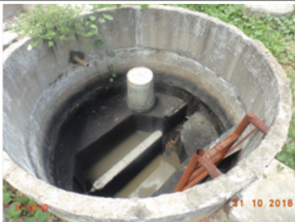
Foto 1 – EEE-01 (Alto São João) (Sede): ausência de gradeamento.
