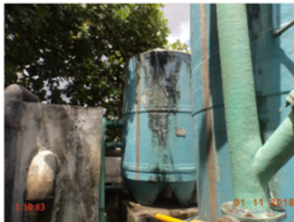
Foto 55 - Filtro F-02 (Pavuna): identificação pouco visível.
