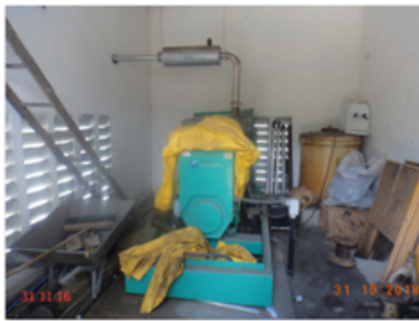
Foto 15 – EEE-02 (Beira Sol) (Sede): grupo gerador sem funcionamento e casa de abrigo servindo para depósito.
