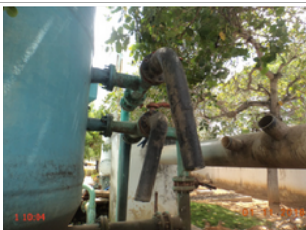
Foto 40 – Filtro F-02 (Pavuna): registro com vazamento.
