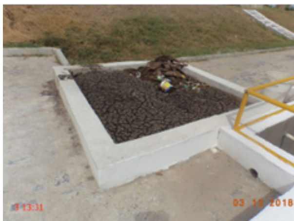
Foto 22 – ETE (Sen. Carlos Jereissati): leito de secagem necessitando de limpeza.
