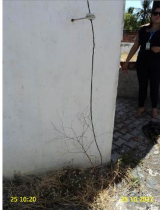
**Foto 43** – REL-01 (Sede): instalações do para-raios inadequadas (sem isolamento).
