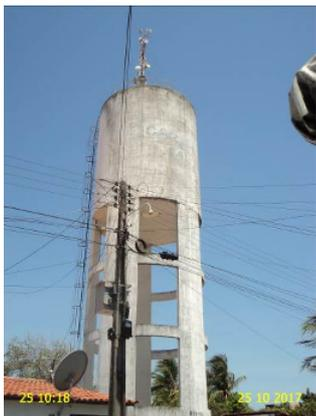
**Foto 41** – REL-01 (Sede): pintura deteriorada e sem identificação.
