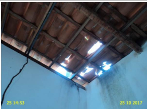
**Foto 33** – PT-01 (Torrões): telhado da casa de abrigo do quadro de comando danificado.
