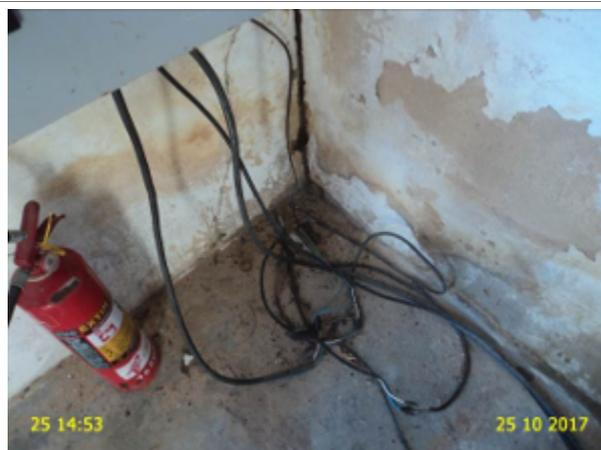
**Foto 34** – PT-01 (Torrões): pintura deteriorada, reboco aparente e instalações elétricas inadequadas na casa de abrigo do quadro de comando.
