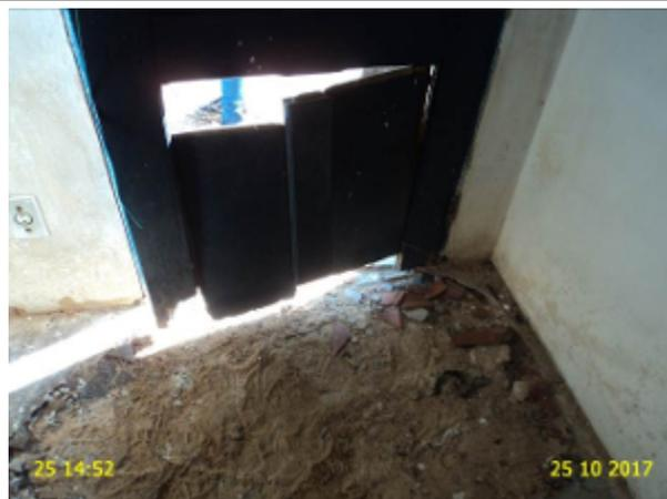
**Foto 32** – PT-01 (Torrões): piso e porta casa de abrigo do quadro de comando danificado.
