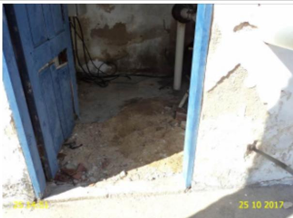
**Foto 31** – PT-01 (Torrões): piso e porta casa de abrigo do quadro de comando danificado
