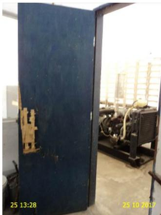
**Foto 47** – EEE-02 (Sede): porta danificada na sala de abrigo do grupo gerador de energia elétrica.
