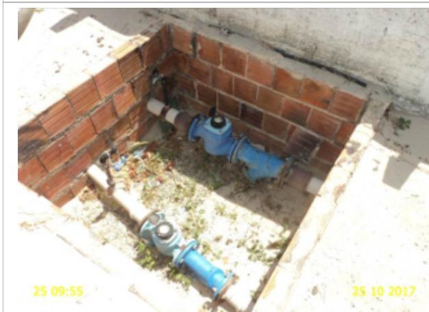
**Foto 23** – AAB: caixa dos macromedidores dos poços PT-02 e PT-03 sem tampa ou grade proteção.
