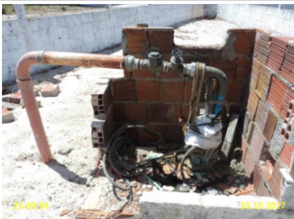
**Foto 8** – PT-02: sem laje de proteção.
