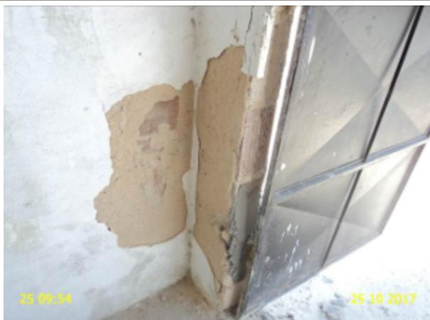
**Foto 29** – PT-02 (Sede): pintura e reboco da parede da casa de abrigo do quadro de comando deteriorado.
