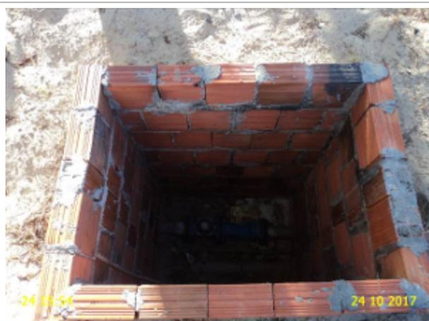
**Foto 24** – REL-01: caixa do macromedidor sem tampa ou caixa de proteção.
