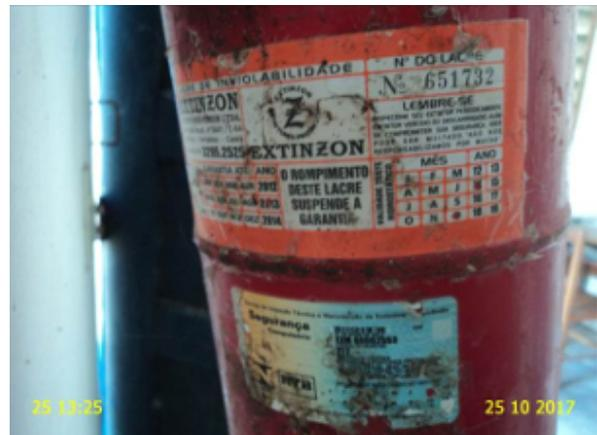
**Foto 46** – EEE-02 (Sede): extintor de incêndio com data de validade da recarga vencida.
