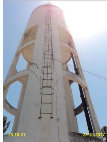
**Foto 38** – REL-01 (Sede): escada de acesso danificada e em processo de corrosão.
