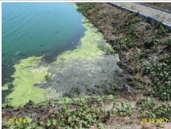
**Foto 28** – ETE: acúmulo de sobrenadante e vegetação excessiva na parede da lagoa facultativa.
