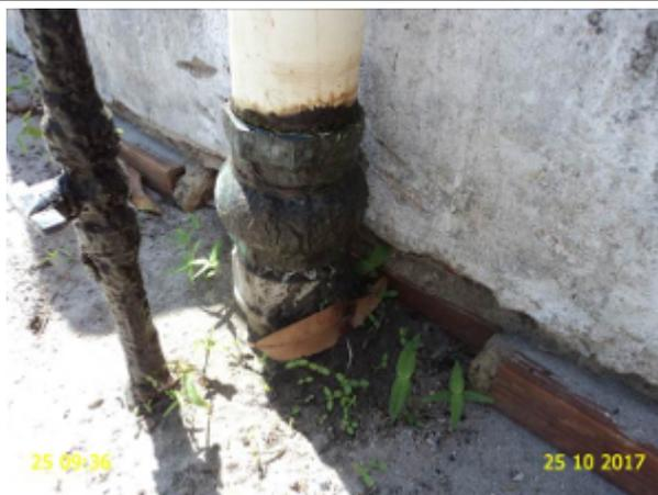
**Foto 30** – PT-06 (Sede): vazamento na tubulação.
