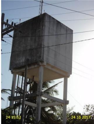
**Foto 10** – REL-01: sem identificação, pintura deteriorada e ausência de guarda-corpo na laje de cobertura.
