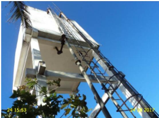
**Foto 39** – REL-01 (Torrões): pintura deteriorada, escada de acesso em processo de corrosão e com guarda-corpo danificado.
