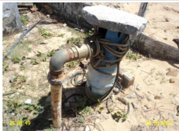
**Foto 9** – PT-03: sem laje de proteção.
