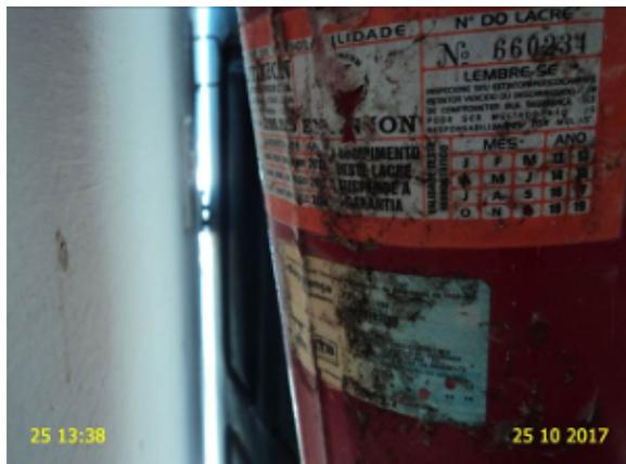
**Foto 45** – EEE-01 (Sede): extintor de incêndio com data de validade da recarga vencida.
