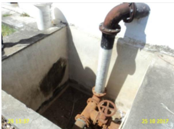
**Foto 13** – EEE-01: caixa dos registros sem tampa ou grade de proteção.
