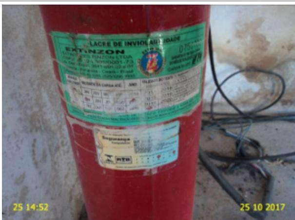
**Foto 35** – PT-01 (Torrões): extintor de incêndio com data de validade da recarga vencida.
