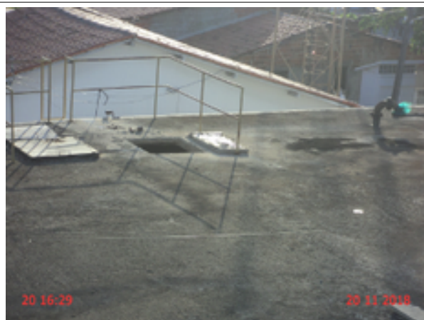
Foto 4 – RAP-02 (Sede): abertura de inspeção sem tampa.
