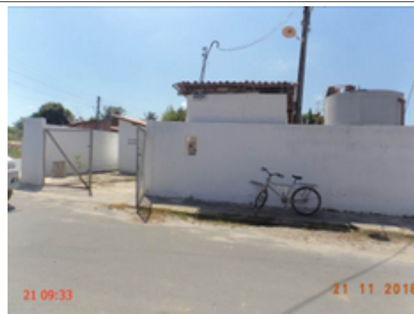
Foto 23 – ETE (Sede): ausência de identificação.
