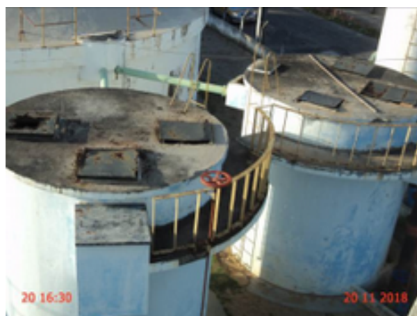
Foto 19 – Filtros F01 e F-02 (Sede): tampas em processo de corrosão.
