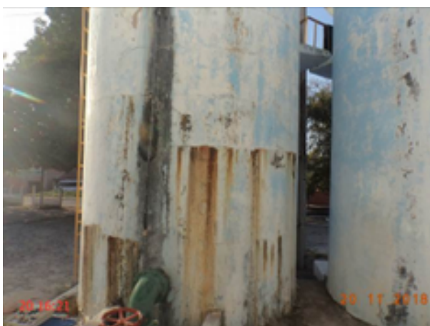
Foto 12 – Filtro F-04 (Sede): sinais de vazamento e pintura deteriorada.
