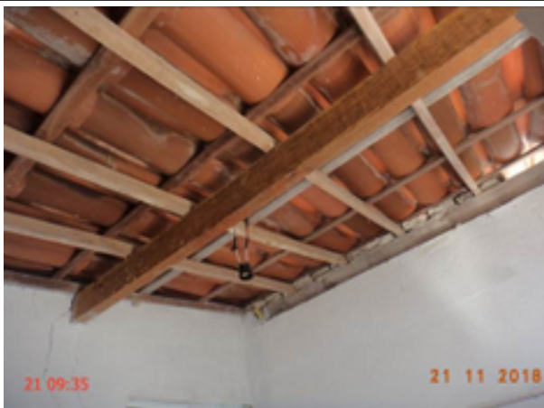
Foto 8 – ETE (Sede): lâmpada do banheiro não acende.
