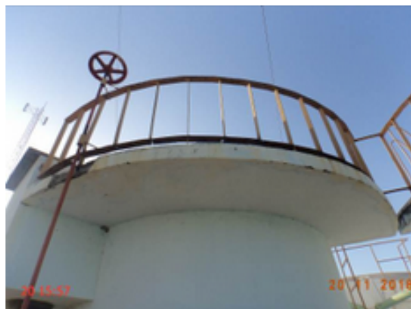
Foto 17 – Filtro F-02: guarda-corpo em processo de corrosão.
