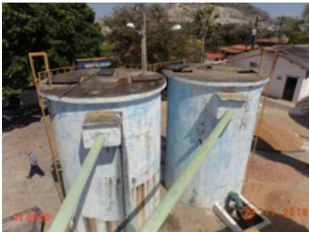
Foto 20 – Filtro F-04 (Sede): tampas em processo de corrosão.
