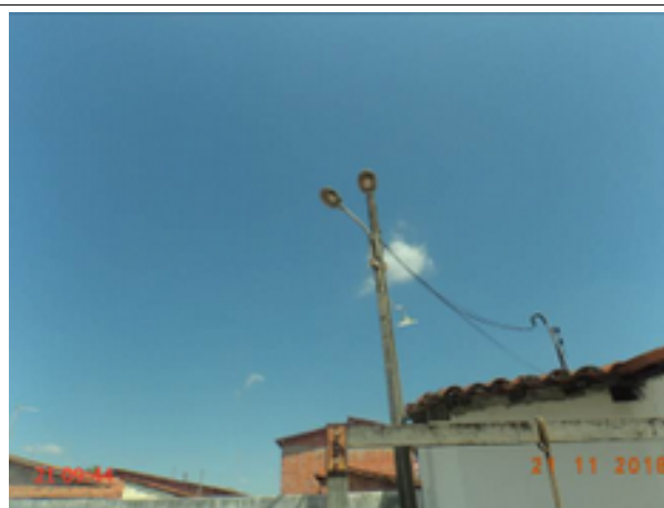
Foto 7 – ETE Angorá (Sede): lâmpadas dos postes não acendem.
