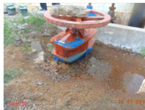
Foto 13 – Filtro F-01 (Sede): vazamento no registro.
