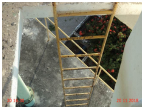
Foto 21 – REL-01 (Sede): escada de acesso em processo de corrosão.
