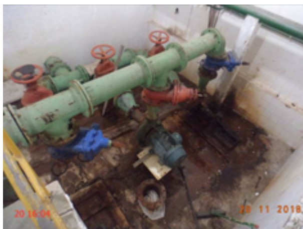
Foto 2 – EEAT-01 (Sede): bomba reserva não instalada.
