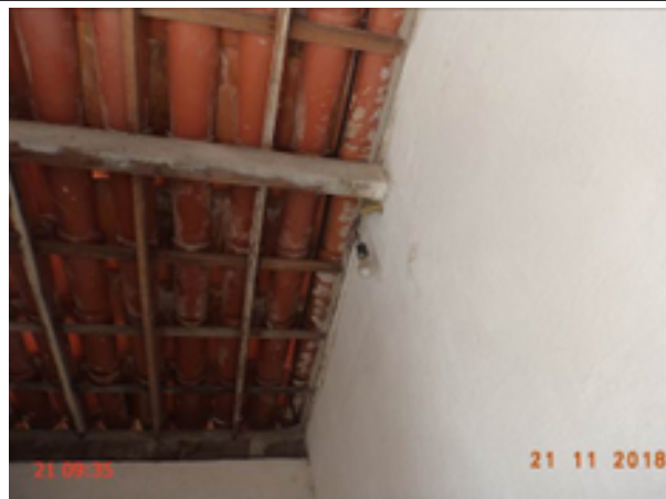
Foto 9 – ETE (Sede): lâmpada da casa de abrigo não acende.
