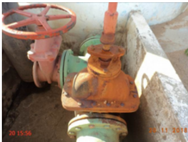
Foto 14 – Filtro F-02 (Sede): vazamento no registro.
