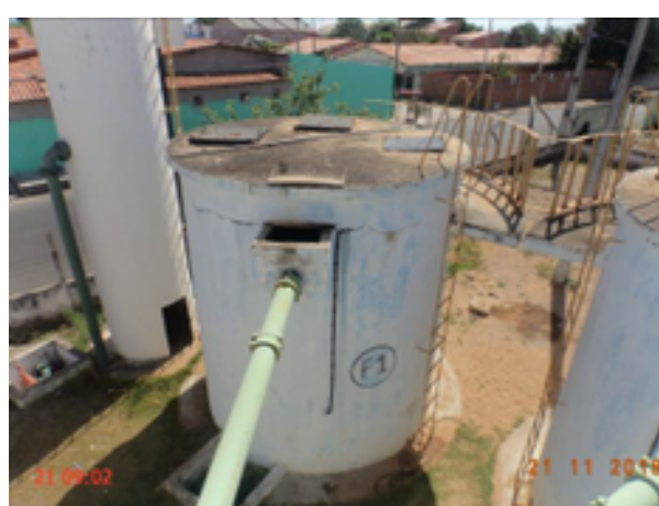
Foto 3 – Filtro F-01 (Sede): ausência de tampa na calha de saída de água.
