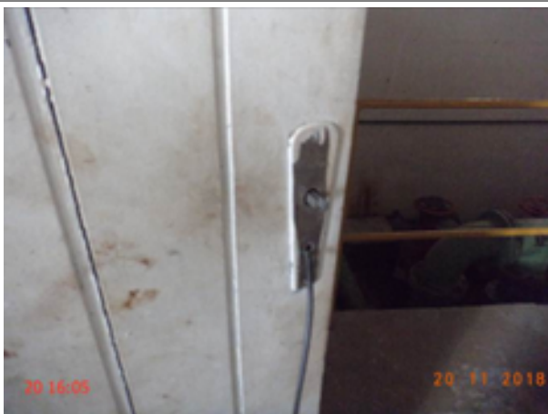
Foto 10 – EEAT-01 (Sede): porta da casa de abrigo está sem maçaneta.
