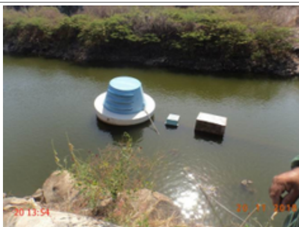
Foto 6 – Captação superficial (Sede): ausência de bomba reserva instalada.
