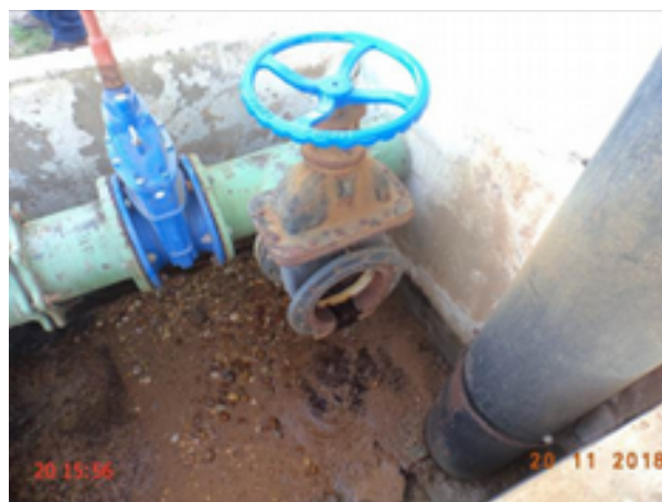
Foto 15 – Filtro F-01 (Sede): registro sem vedação.
