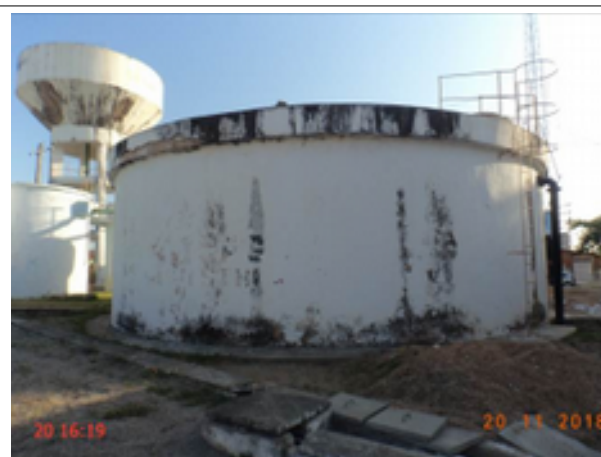
Foto 25 – RAP-01 (Sede): pintura deteriorada.
