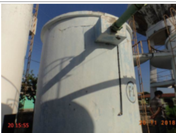
Foto 24 – Filtro F-01 (Sede): rachadura na parede.
