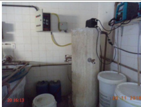
Foto 11 – ETA (Sede): dosador de flúor com defeito.
