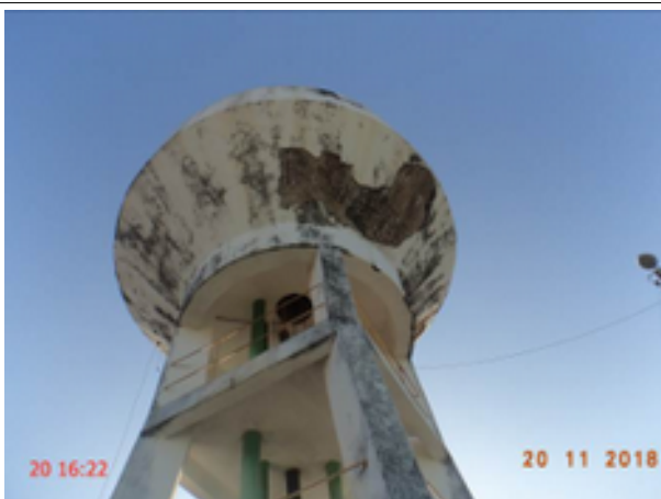
Foto 22 – REL-01 (Sede): pintura deteriorada e armaduras expostas.
