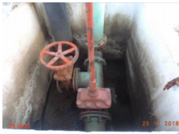
Foto 16 – Filtro F-02 (Sede): registro sem vedação.
