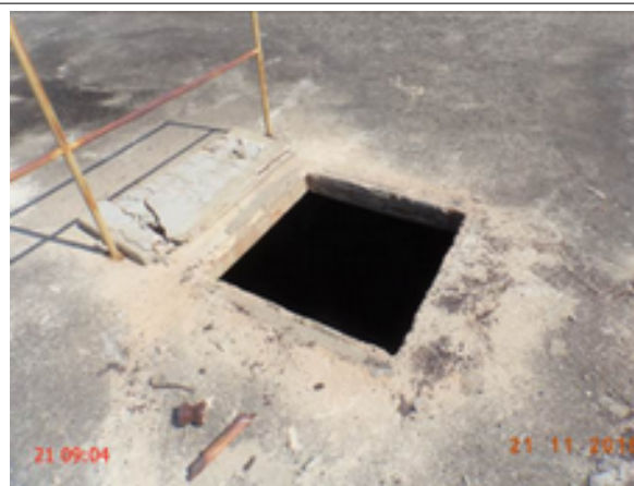
Foto 5 – RAP-01 (Sede): abertura de inspeção sem tampa.
