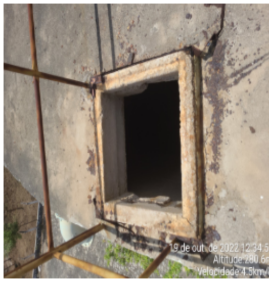
Foto 39 - REL-02 (Sede): reservatório sem tampa.
