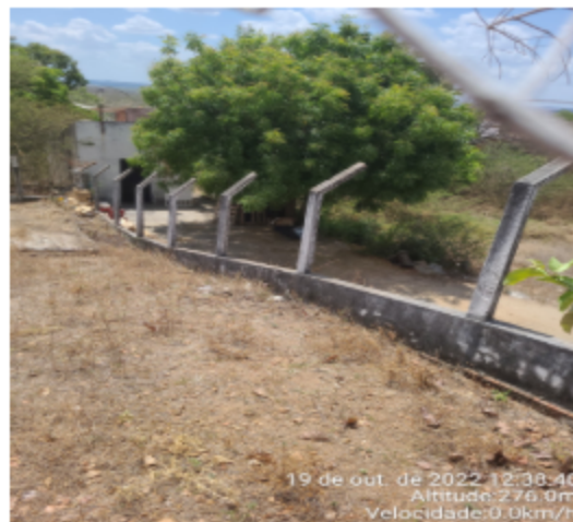
Foto 12 - RAP-01 e REL-02 (Sede): área sem proteção de acesso de pessoas e animais.
