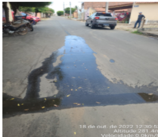
Foto 17 - RDA (Mangabeira): presença de vazamentos.
