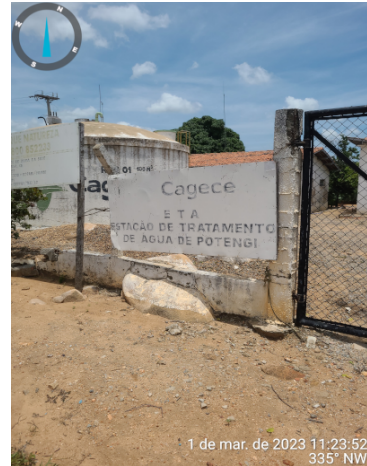
Foto 4 - ETA: Toda infraestrutura está com pintura deteriorada.
