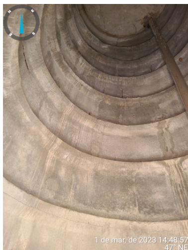
Foto 33 - REL-03: estrutura interna com aço aparente.
