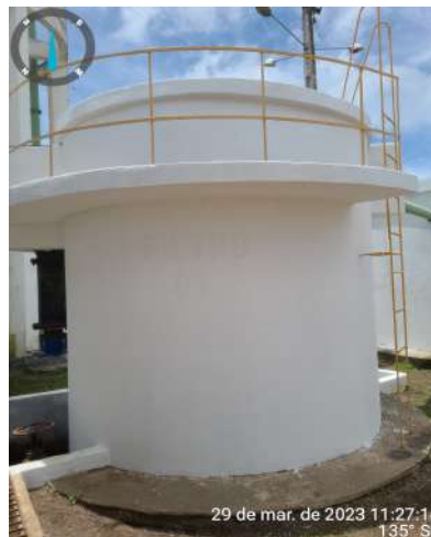
Foto 6 - ETA: filtro F1 sem identificação.
