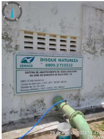
Foto 31 - ETA: Placa Licença de Operação vencida.
