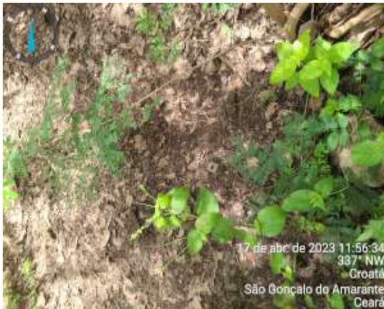
Foto 9 - Foto 10 REL-03 (Violete): registro de saída sem caixa de proteção.
