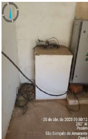
Foto 154 - EEE-03 (Pecém): instalações elétricas inadequadas.
