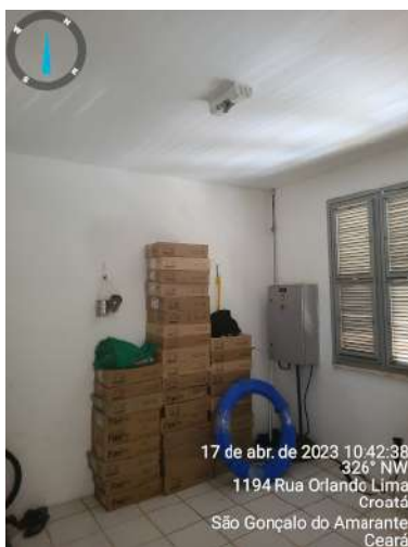
Foto 52 - Escritório (Croatá): ausência de lâmpada no almoxarifado.
