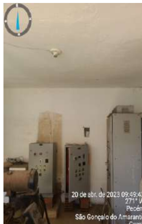
Foto 155 - EEE-03 (Pecém): parede apresentando fissuras e área do gerador sem lâmpada.
