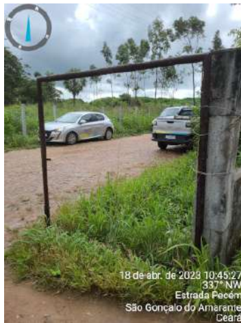
Foto 130 - ETE (Sede): portão sem grade/malha de segurança.
