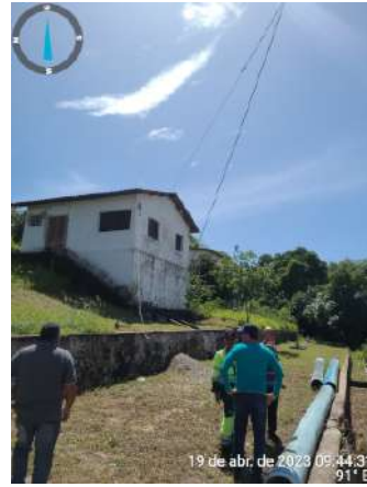
Foto 87 - ETA (Siupé): fio elétrico energizado em nível baixo.
