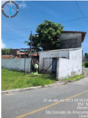
Foto 158 - EEE-04 (Pecém): pintura desgastada.
