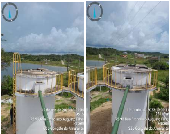
Foto 70 - F-02 e F-03 (Pecém): tampas deslocadas.
