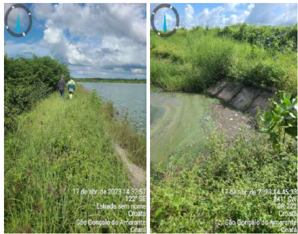
Foto 145 - ETE (Croatá): talude com excesso de vegetação e presença de sobrenadantes na LF.
