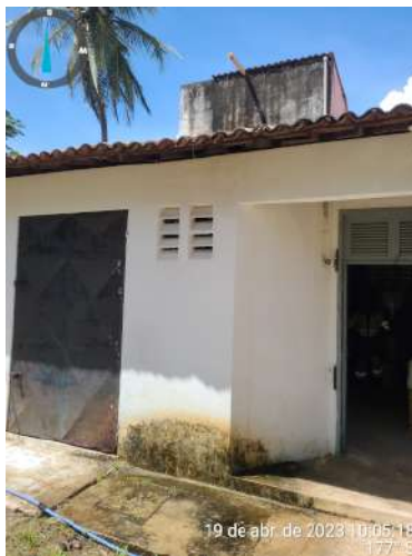
Foto 88 - ETA (Siupé): caixa d'água da casa do operador sem bóia (extravasando).
