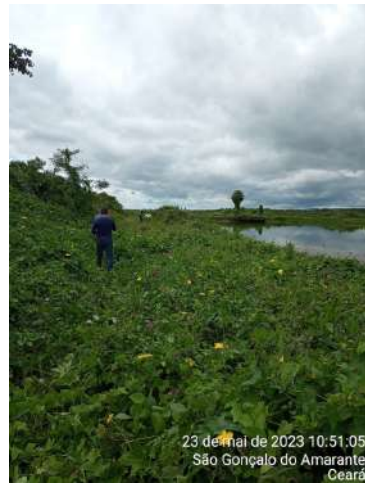
Foto 129 - ETE (Sede): excesso de vegetação nos taludes e dentro da lagoa.
