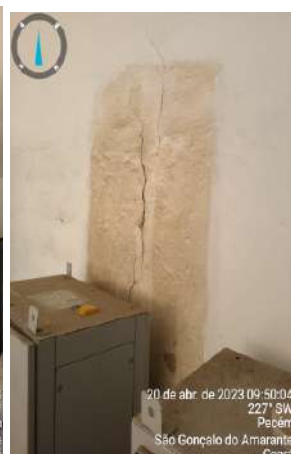
Foto 155 - EEE-03 (Pecém): parede apresentando fissuras e área do gerador sem lâmpada.
