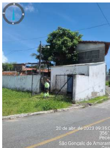
Foto 34 - EEE-04: sem identificação.
