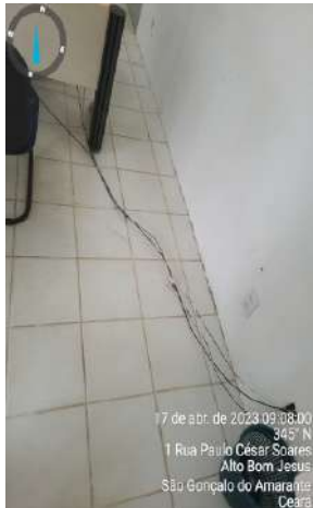
Foto 38 - Escritório (Sede): instalações elétricas inadequadas, pintura desgastada.
