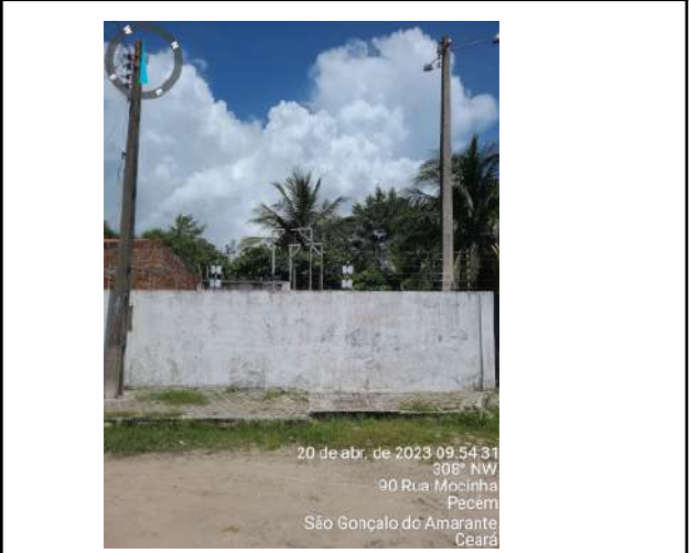
Foto 30 - EEE-02 (Pecém): sem identificação.
