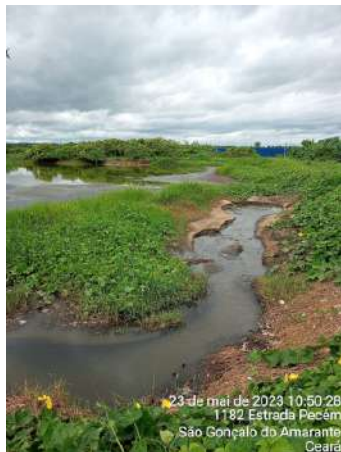
Foto 132 - ETE (Sede): excesso de vegetação dentro da lagoa e assoreamento da Lagoa Facultativa.
