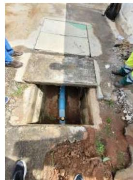
**Foto 45** - PT-05: caixa de proteção sem tampa.
