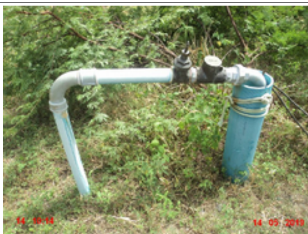
Foto 27 - Captação: O poço PT-14 não é dotado de tampa de proteção.
