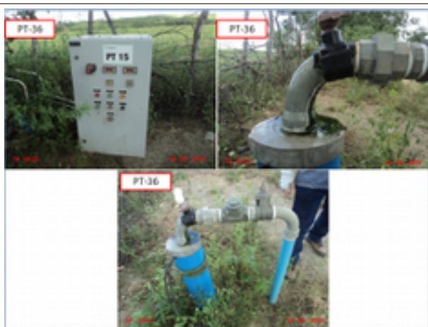
Foto 25 - O poço PT-36 está com a identificação incorreta, vazamento no colar e não é dotado de laje.
