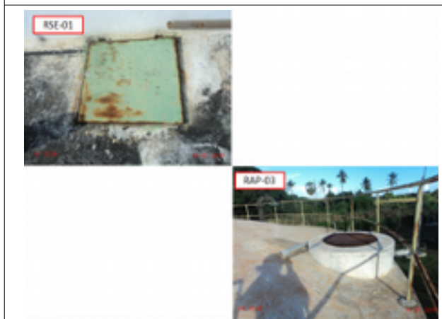
Foto 31 - Reservatórios: As tampas de inspeção do RSE-01 e RAP-03 estão em processo de corrosão.
