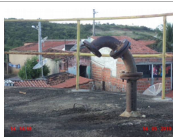
Foto 16 - Reservatório RAP-02 não é dotado de tela de proteção na tubulação de ventilação.
