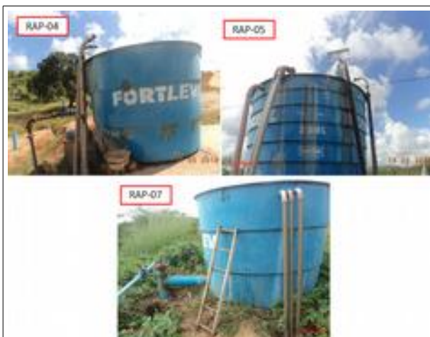
Foto 2 – Reservatórios: RAP-04, RAP-05 e RAP-07 estão sem tampa e sem identificação.
