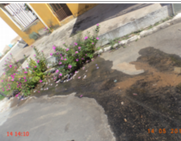
Foto 28 - RDA: Ocorre vazamento na rede de distribuição localizado na rua João Alencar, nº 85.
