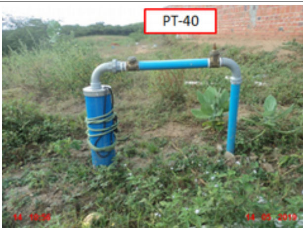
Foto 13 - Captação: O poço PT-40 não é dotado de laje de proteção e não está identificado.
