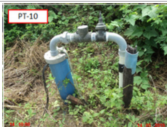
Foto 7 – Captação: O poço PT-10 não é dotado de tampa e laje de proteção.
