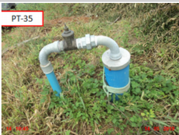
Foto 11 - Captação: O poço PT-35 não é dotado de laje de proteção e apresenta vegetação excessiva.
