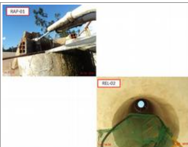
Foto 3 – Reservatórios: RAP-01 e REL-02 estão sem tampa de inspeção.
