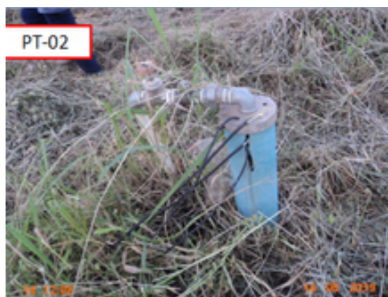
Foto 6 – Captação: O poço PT-02 não é dotado de tampa e laje de proteção.
