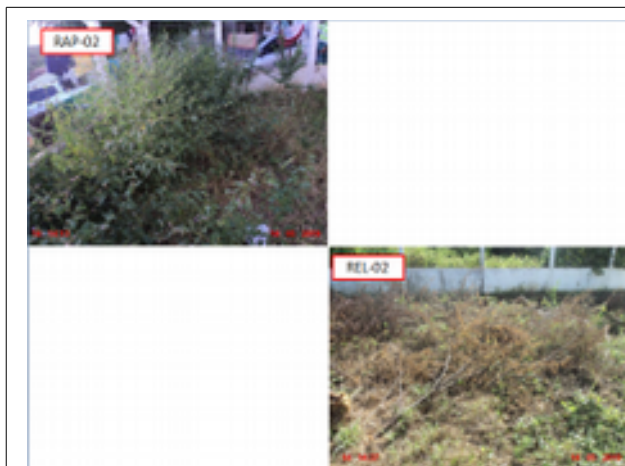
Foto 29 - Reservatório: A área do RAP-02 e REL-02 apresentam vegetação excessiva.
