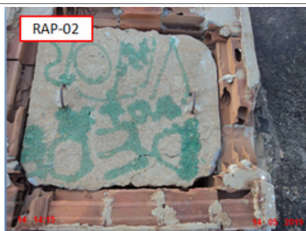
Foto 30 - Reservatório: RAP-02 A tampa de inspeção não garante vedação.
