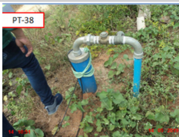
Foto 12 - Captação: O poço PT-38 não é dotado de laje de proteção e não está identificado.
