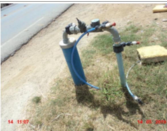
Foto 26 - Captação: O poço PT-22 apresenta problemas e está fora de operação.
