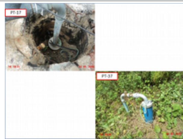
Foto 14 - Captação: Os poços PT-17 e PT-37 não estão identificados e o PT-37 apresenta vegetação excessiva.
