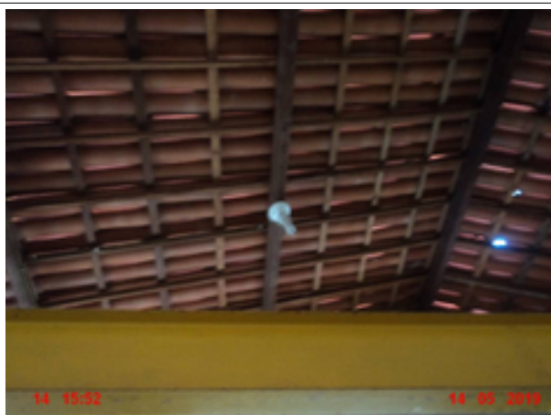
Foto 23 - Elevatória: Não existe iluminação na elevatória EEAT-01.
