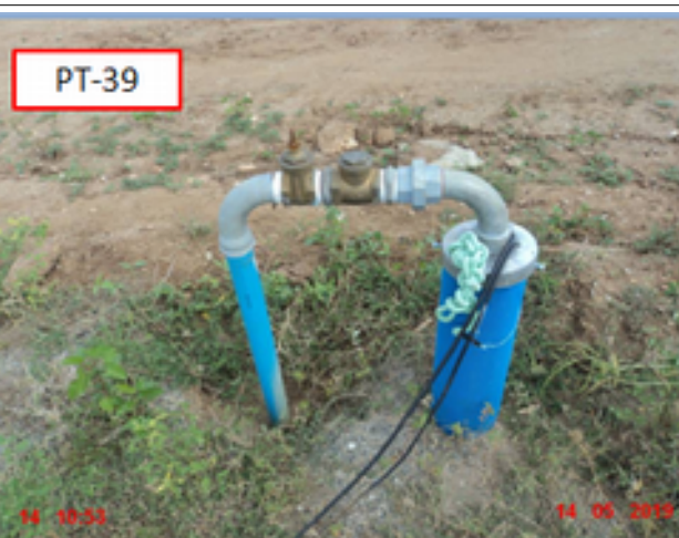
Foto 15 - Captação: O poço PT-39 não está identificado.
