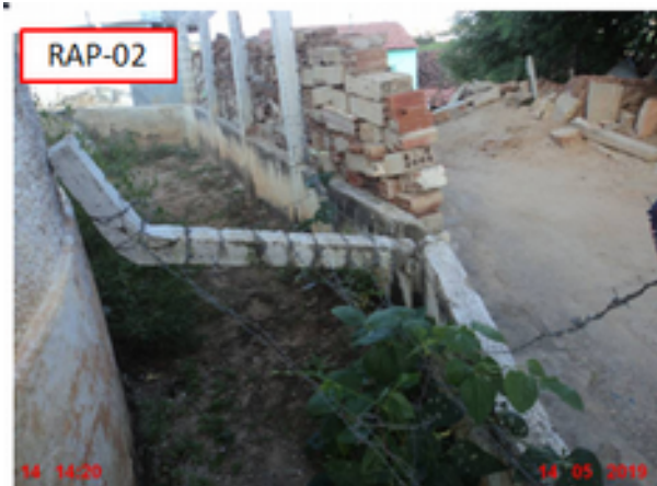
Foto 22 - Reservatório: RAP-02 a cerca encontra-se deteriorada.
