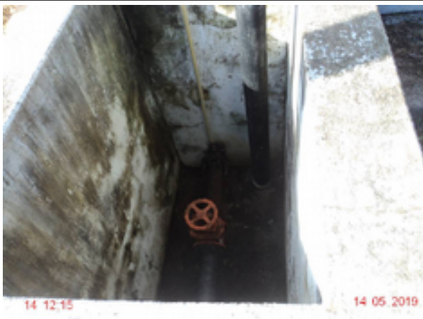
Foto 17 - RSE-01: Caixa sem tampa ou grade de proteção.
