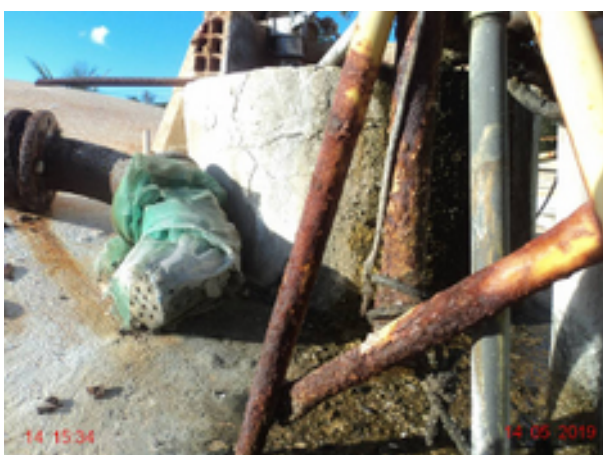
Foto 19 - RAP-01: Escada em processo de corrosão e com a tubulação de ventilação desconectada.
