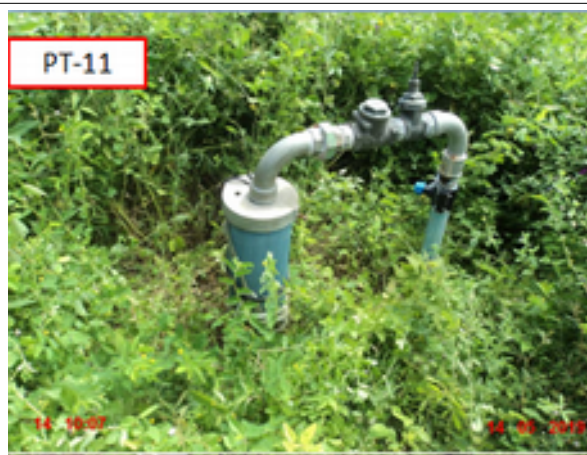
Foto 24 - Captação: O poço PT-11 apresenta vegetação excessiva.
