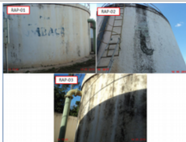
Foto 20 - Reservatórios: RAP-01, RAP-02 e RAP-03 estão com a pintura deteriorada e sem identificação.
