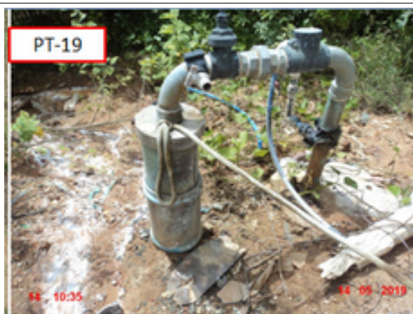
Foto 8 - Captação: O poço PT-19 não é dotado de tampa e laje de proteção.
