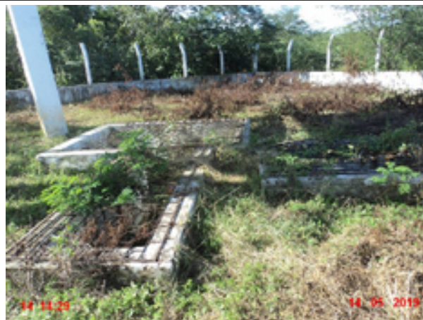
Foto 18 - REL-02: Caixa do medidor com a grade curta.
