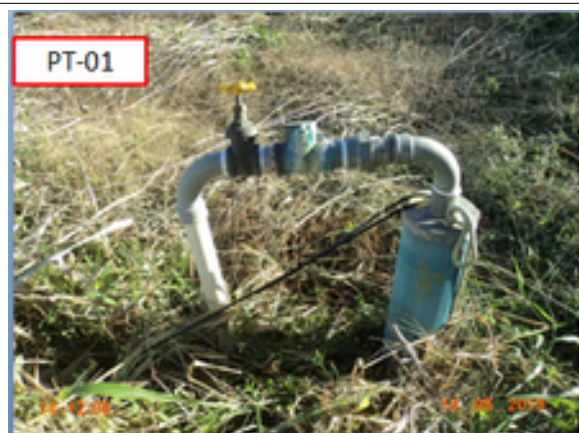
Foto 5 – Captação: O poço PT-01 não é dotado de tampa e laje de proteção.
