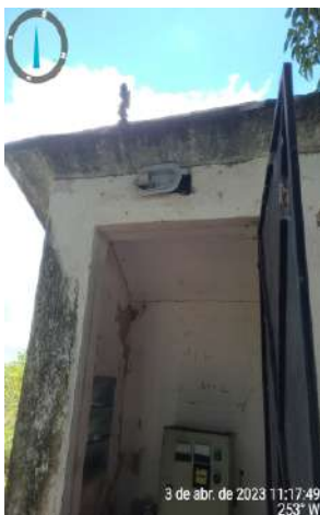
Foto 31 - PT-06 (Capuan): pintura desgastada, reboco danificado e ausência de iluminação interna e externa.
