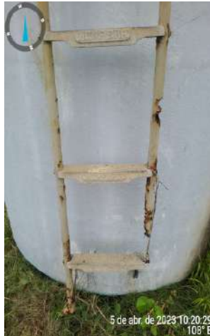
Foto 77 - F-02 (Primavera): escada corroída e identificação ilegível.
