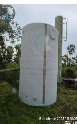
Foto 75 - F-01 (Primavera): escada corroída com gaiola danificada, presença de extravasamento e identificação ilegível.
