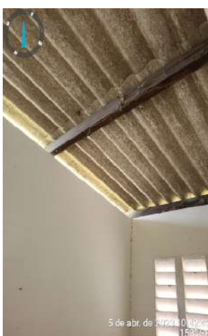
Foto 73 - Casa de química (Primavera): teto com telhado quebrado e ausência de lâmpada na divisória ao lado.
