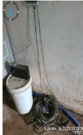
Foto 78 - Estação elevatória (EELF / EEAT) (Primavera): instalações elétricas inadequadas (fiação solta), paredes com infiltrações e pinturas deterioradas.
