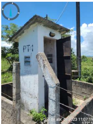
Foto 25 - PT-01 (Capuan): pintura desgastada e ausência de iluminação interna e externa.
