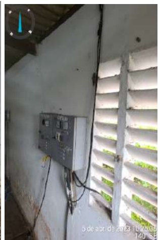
Foto 78 - Estação elevatória (EELF / EEAT) (Primavera): instalações elétricas inadequadas (fiação solta), paredes com infiltrações e pinturas deterioradas.
