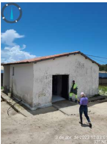
Foto 11 - Casa de Química (Capuan): sem identificação.
