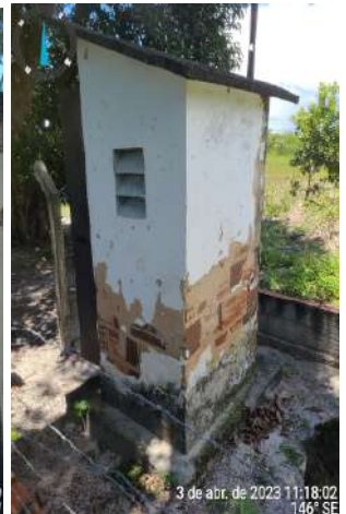
Foto 31 - PT-06 (Capuan): pintura desgastada, reboco danificado e ausência de iluminação interna e externa.
