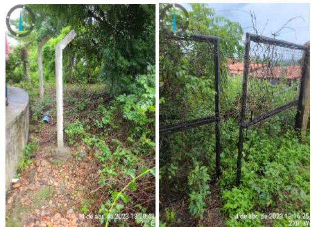
Foto 98 - REL-01/ REL-02 e REL-03 (Sítios Novos): portão e cerca danificados.
