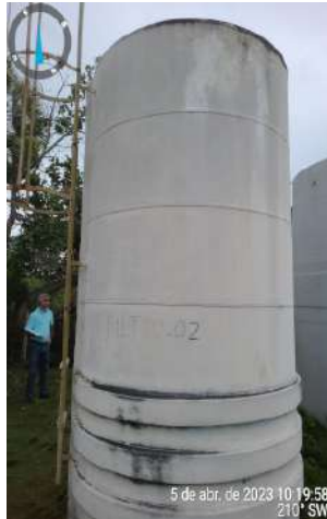
Foto 77 - F-02 (Primavera): escada corroída e identificação ilegível.
