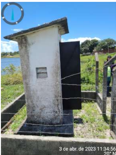
Foto 7 - PT-03 (Capuan): sem identificação e ausência de portão na área do poço.
