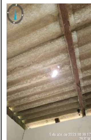
Foto 73 - Casa de química (Primavera): teto com telhado quebrado e ausência de lâmpada na divisória ao lado.
