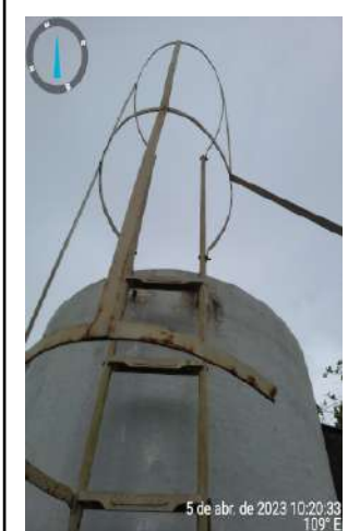
Foto 75 - F-01 (Primavera): escada corroída com gaiola danificada, presença de extravasamento e identificação ilegível.
