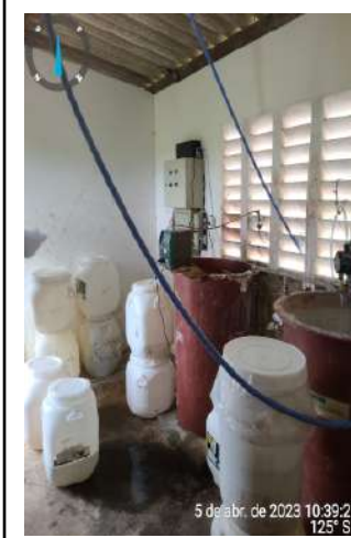
Foto 74 - Casa de química (Primavera): instalações elétricas inadequadas, espaço sem organização, equipamento de dosagem sem apoio adequado.
