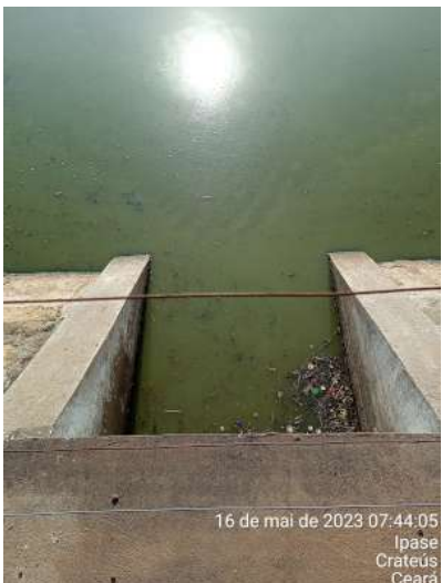
Foto 33 - ETE Maratoan: desnívelamento na caixa de saída da lagoa facultativa.
