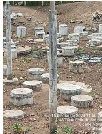
Foto 20 - ETE 05: extravasamento de esgoto.
