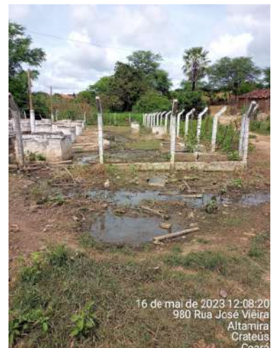
Foto 22 - ETE 13: extravasamento de esgoto.
