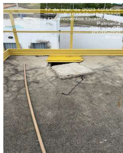
Foto 12 - ETA: EEAT e RAP-02 (Dom Frágoso): reservatório com tampa semiabertas.
