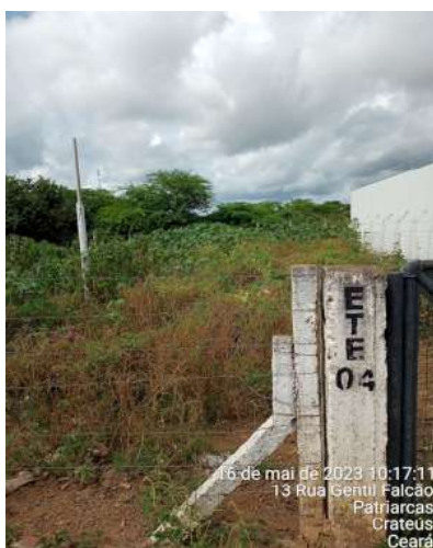
Foto 17 - ETE 04: péssimo estado de conservação
