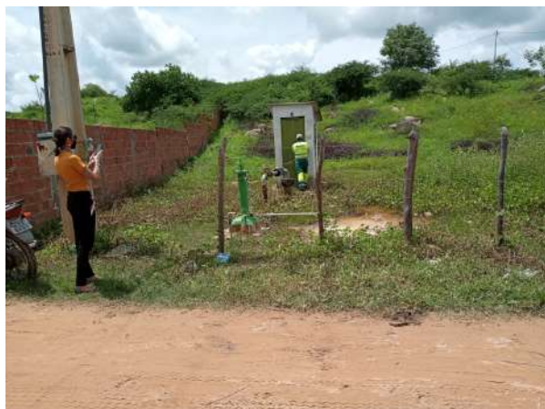
Foto 1 - PT-06 (Sede): Área sem isolamento e com alargamento e poço sem laje de proteção.
