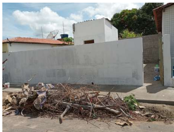
Foto 7 - PT (Rosário): Infraestruturas operando de forma precária, obras em reforma ou recuperação em andamento.
