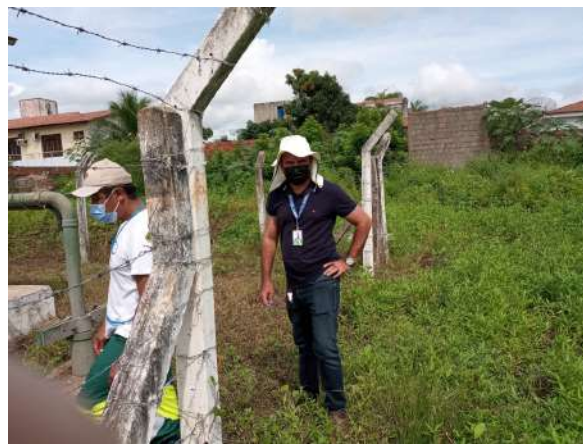
Foto 21 - PT-01 (Sede): Falta manutenção / recuperação do isolamento da área.
