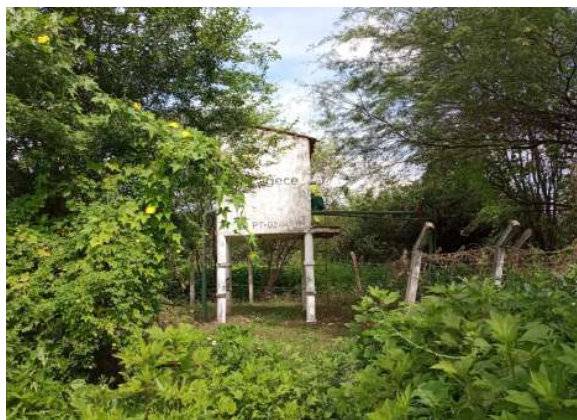
Foto 22 - PT-02 (Sede): Falta manutenção / recuperação do isolamento da área.
