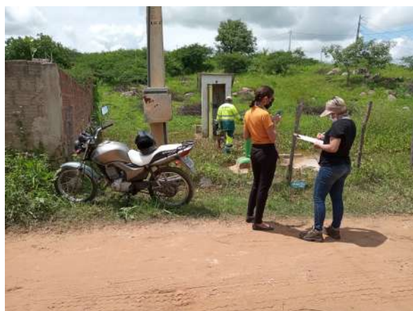
Foto 4 - PT-06 (Sede): Ausência de identificação.
