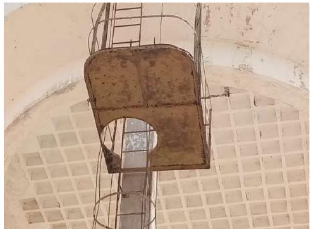
**Foto 16** - REL-02: escada em processo de corrosão.
