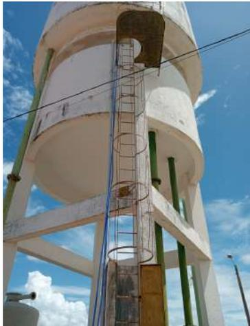
**Foto 13** - REL-01: escada em processo de corrosão.
