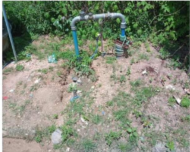
**Foto 8** - PT-02: instalações elétricas inadequadas.
