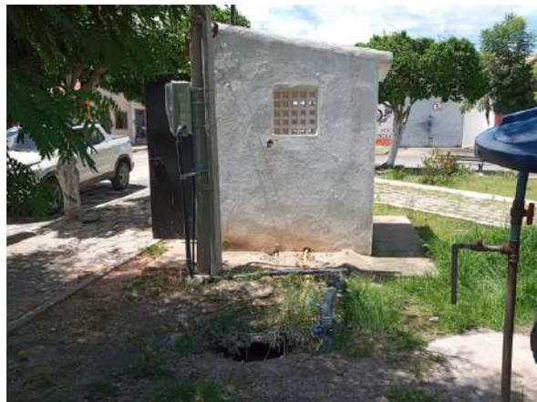
**Foto 2** -PT-03: ausência de identificação e iluminação e não há isolamento da área.
