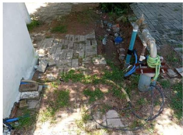
**Foto 6** - PT-01: instalações elétricas inadequadas.
