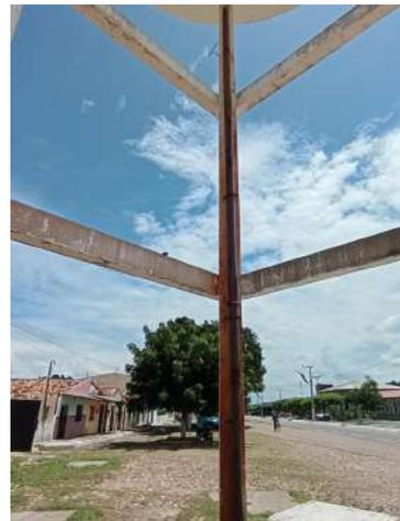
**Foto 18** - REL-02: tubulação em processo de corrosão.
