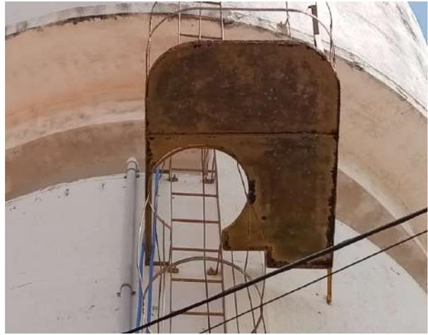
**Foto 14** - REL-01: escada em processo de corrosão.
