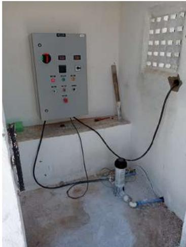
**Foto 7** - PT-01: instalações elétricas inadequadas.
