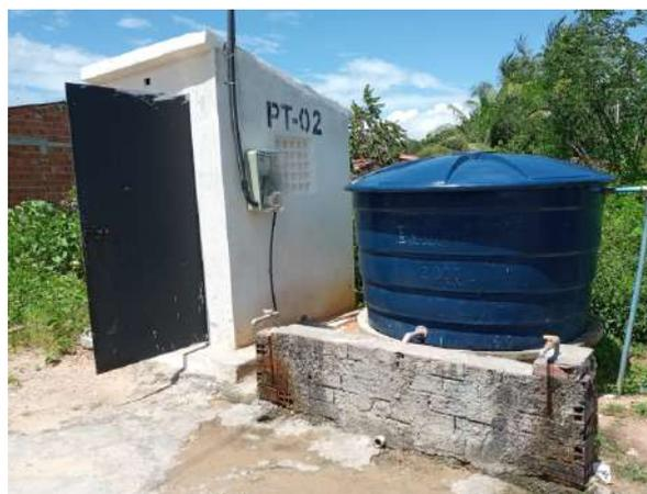
**Foto 4** - PT-02: não há isolamento da área e ausência de iluminação.
