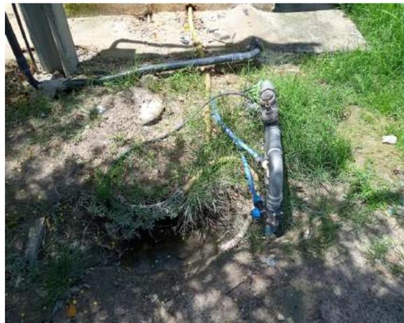
**Foto 10** - PT-03: instalações elétricas inadequadas.
