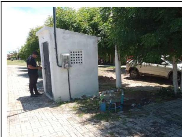
**Foto 1** - PT-01: ausência de identificação e iluminação e não há isolamento da área.
