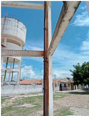
**Foto 17** - REL-02: tubulação em processo de corrosão.
