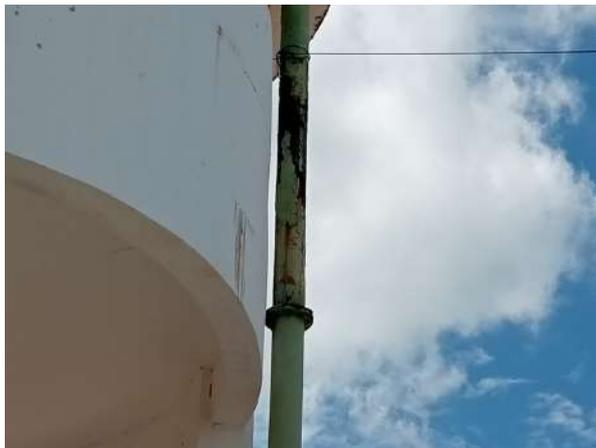
**Foto 15** - REL-01: tubulação em processo de corrosão.
