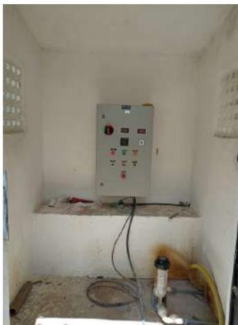
**Foto 11** - PT-03: instalações elétricas inadequadas.
