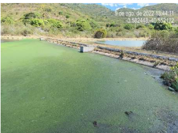
Foto 11 - ETE: LF-01 apresenta curto circuito no fluxo dos esgotos.
