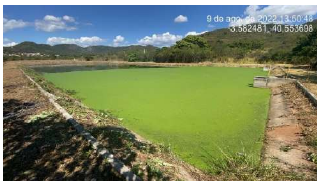
Foto 10 - ETE: LM-02 apresenta restos da limpeza nas bordas das lagoas, bem como há uma crosta de algas.
