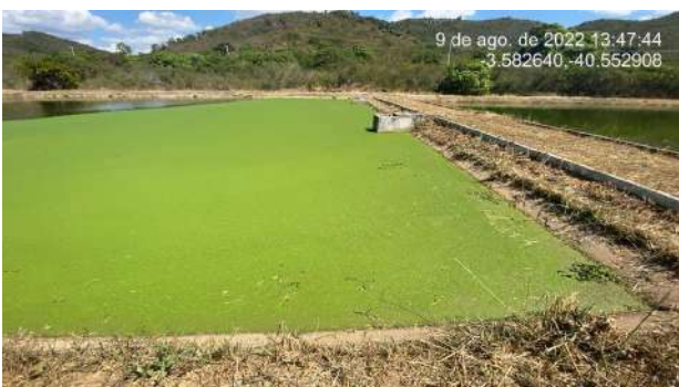
Foto 9 - ETE: LM-01 apresenta restos da limpeza nas bordas das lagoas, bem como há uma crosta de algas.
