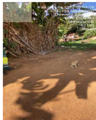
Foto 2 - Registro de descarga soterrado.
