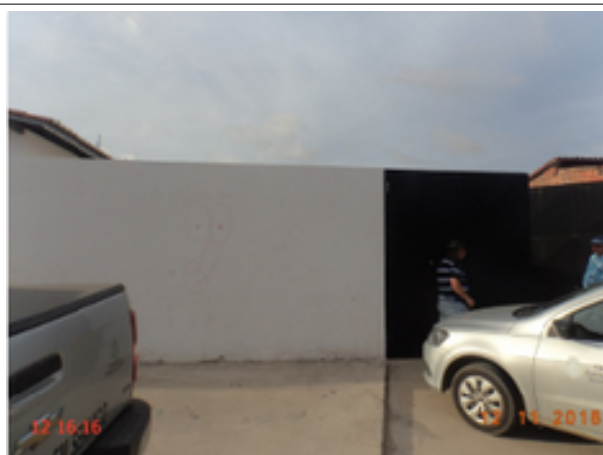
Foto 11 – Elevatória (Sede): EEE-01 sem identificação.
