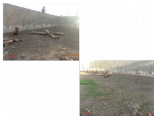
Foto 44 – ETE: área com esgoto necessitando de limpeza.
