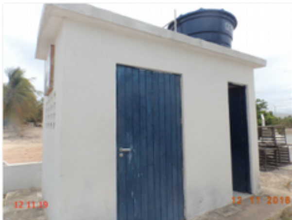
Foto 48 – Elevatória (Sede): a EECS-01 não possui identificação.
