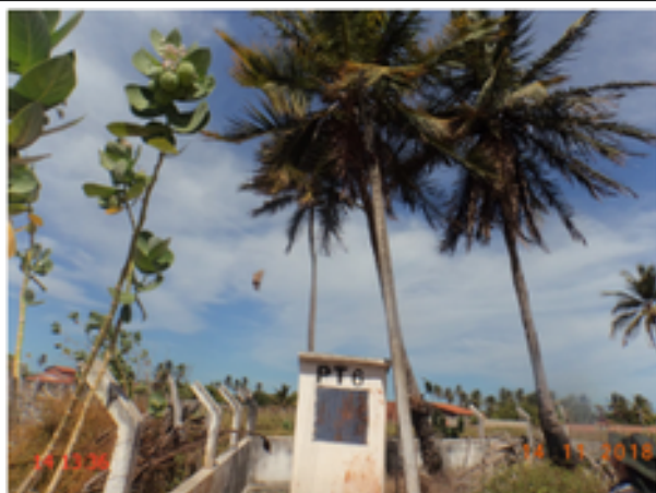
Foto 5 – Captação (Caponga): PT-06 ausência de iluminação.
