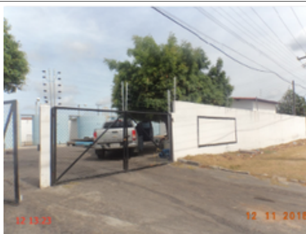
Foto 54 – ETA (Sede): ausência de identificação.
