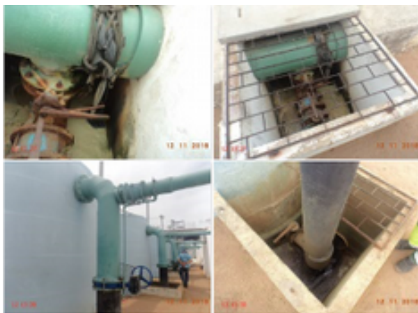
Foto 39 – ETA (Sede): no Filtro F-05 a tubulação está com vazamento e o registro sem vedação.
