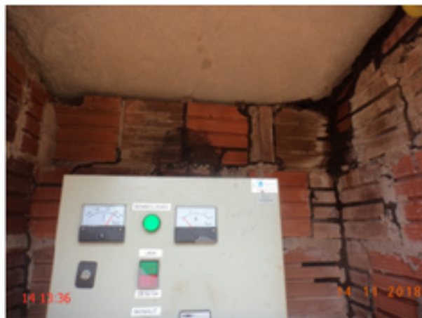
Foto 36 – Captação (Caponga): no PT-06 existe a presença de cupins.
