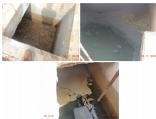
Foto 39 – ETA (Sede): no Filtro F-05 a tubulação está com vazamento e o registro sem vedação.
