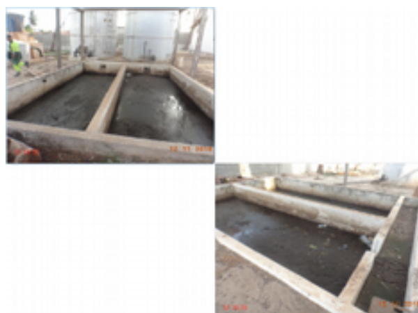
Foto 40 – ETE: leitos de secagem necessitando de limpeza.
