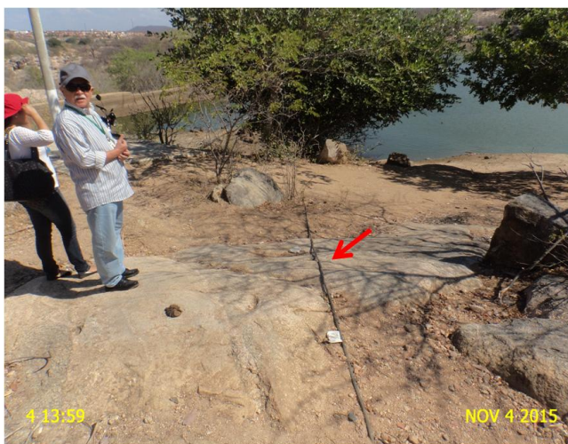
Foto 2 – EECS-01: Cabo elétrico exposto na área da captação.
