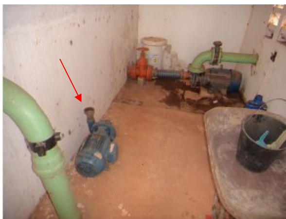
Foto 2 – EEAT-01: bomba reserva.
