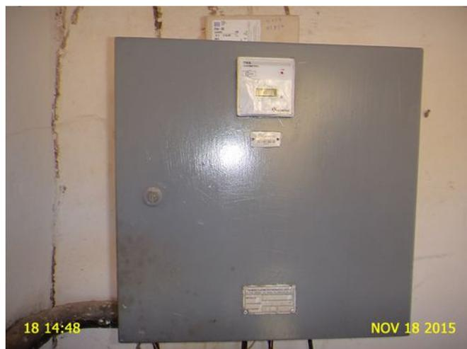
**Foto 5** - EEPR-01: Quadro de Comando com horímetro instalado.
