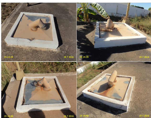
Foto 15 – RAP-02: Tubulações de ventilação inadequadas.
