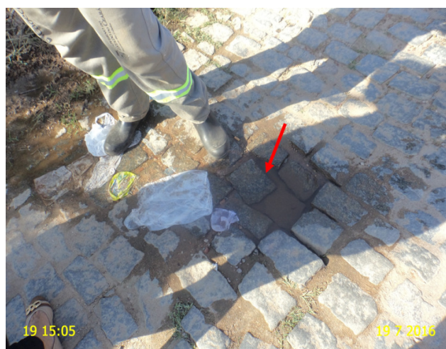
Foto 16 – RDA: Vazamento na Rua Osvaldo Cruz.
