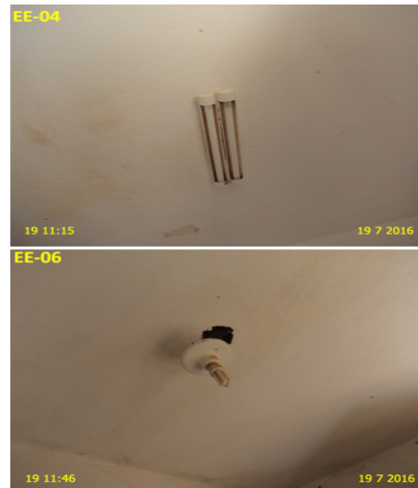
Foto 8 – EE-04/EE-06: As lâmpadas não ascendem.
