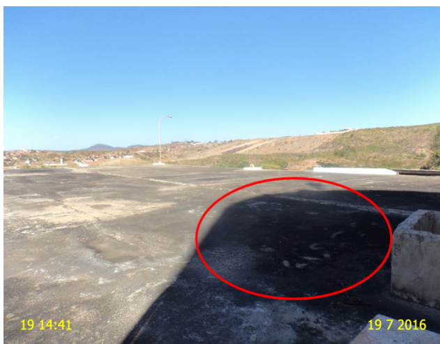
Foto 6 – RAP-02: Sinais de acúmulo de águas pluviais na laje de cobertura.
