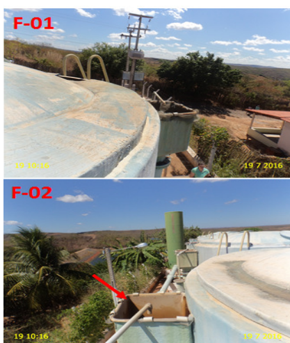
Foto 4 – Filtros F-01 e F-02: Ausência de tela ou tampa de inspeção.
