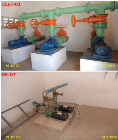
Foto 7 – EELF-01/EE-07: Ausência de identificação.
