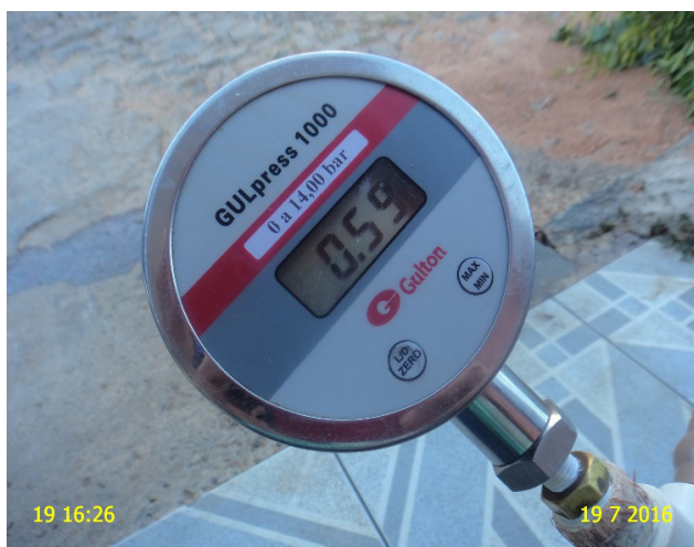
Foto 1 – RDA: Constatação de medição instantânea de pressão abaixo da faixa de 10 mca na Rua Eneias Moisés, nº 66 – Alto do Tenente.
