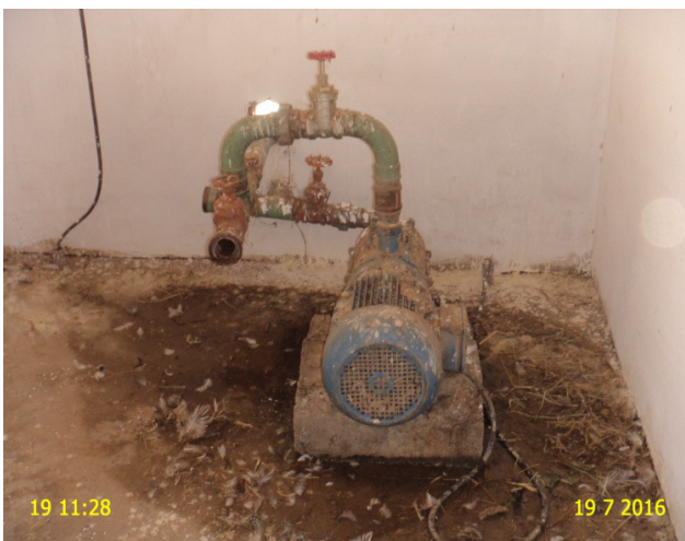
Foto 2 – EE-05: Ausência de bomba reserva.
