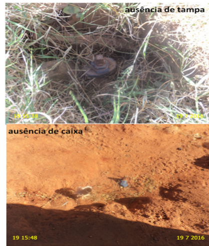
Foto 10 – RDA: Ausência de tampa no registro da Rua João dos Grossos e de caixa na Rua João Guedes.
