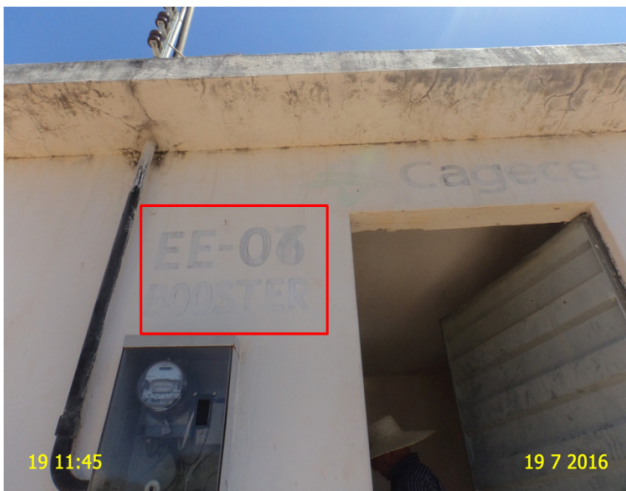
Foto 19 – EE-06: identificação pouco visível.
