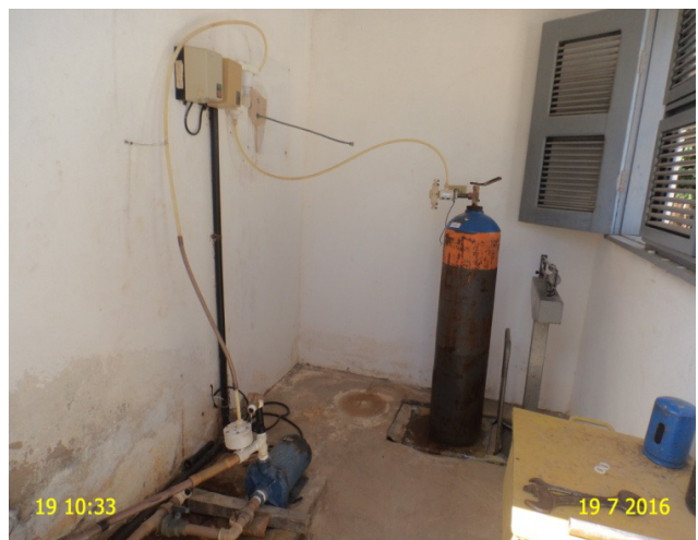
Foto 3 – Casa de Química: Bomba dosadora na mesma área do cilindro de cloro gasoso.
