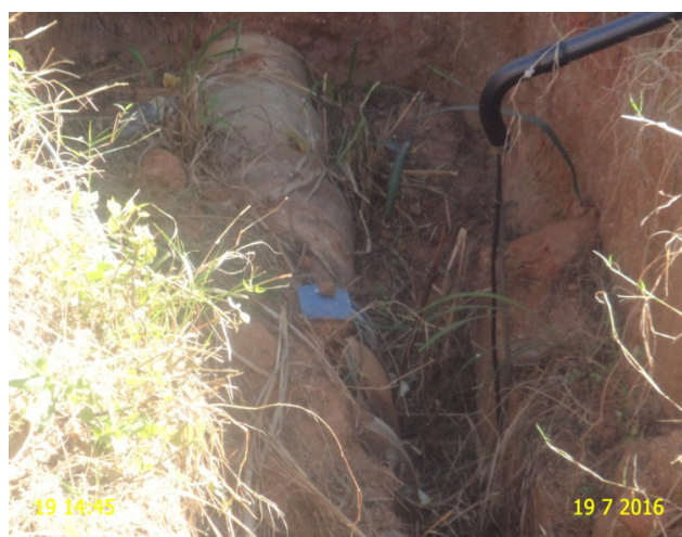
Foto 18 – AAT: Ausência de caixa no macromedidor na área do REL-01.
