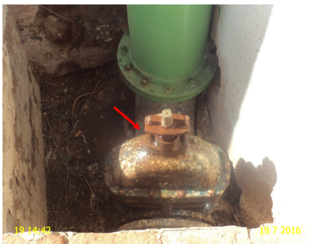
Foto 13 – REL-01: Registro com vazamento.
