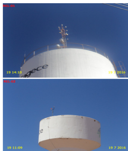
Foto 14 – REL-01/REL-02: Lâmpada de obstáculos sem ascender.
