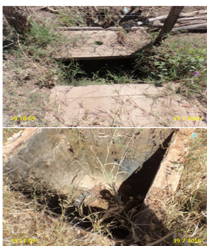
Foto 17 – AAT: Ausência de tampas nas caixas dos registros de descarga de AAT.
