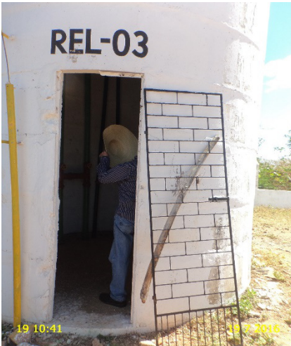
Foto 9 – REL-03: Portão de acesso sem fixação.
