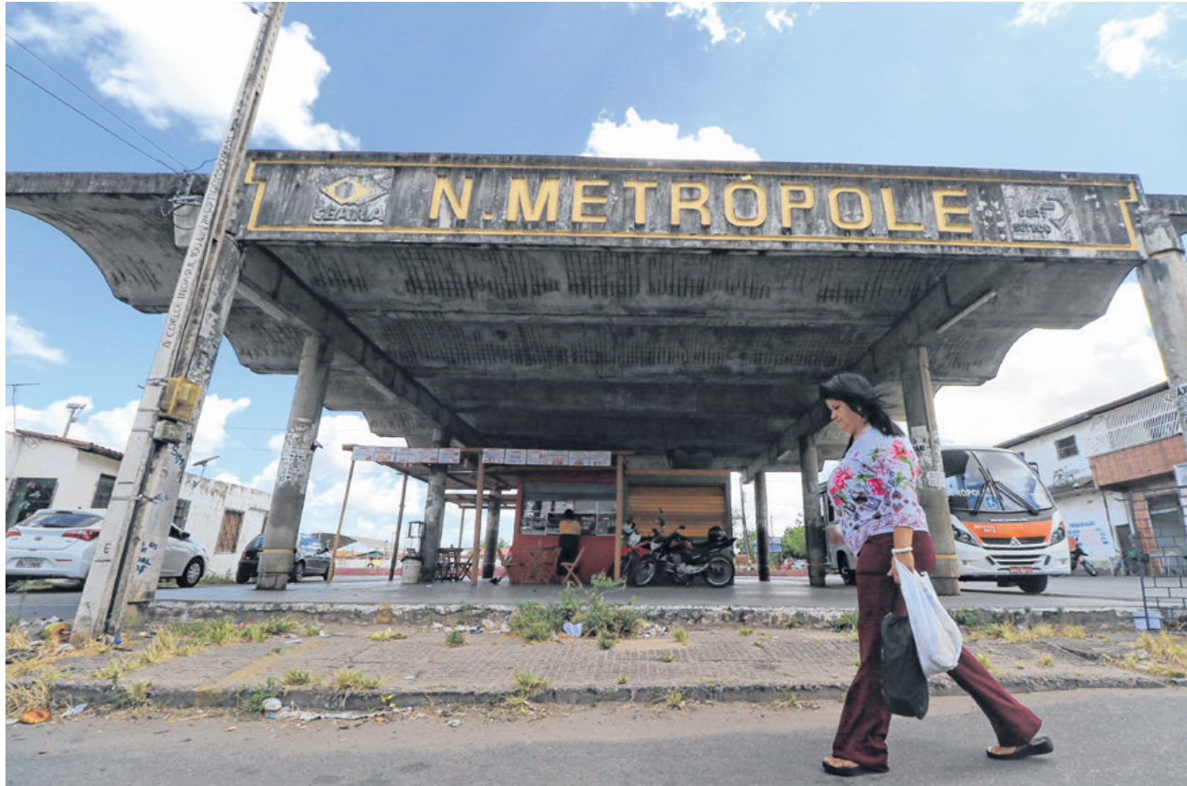
PRAZO PARA INÍCIO da reforma no terminal Nova Metrópole, em Caucaia, é indeterminado e orçamento sequer foi entregue
