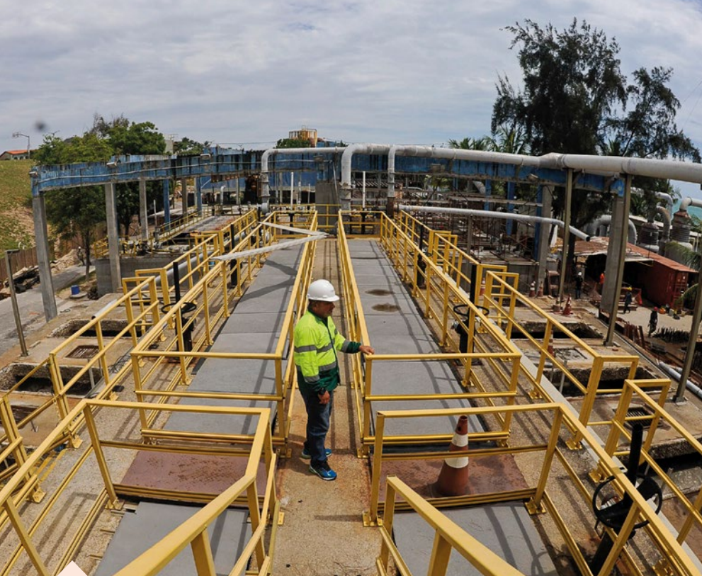
Garantindo melhorias para um dos mais importantes equipamentos da capital, a Estação de Pré-Condicionamento de Esgoto (EPC), a Cagece, em parceria com Banco do Nordeste, assegurou R$ 140 milhões em recuperações, remanejamentos, substituições de estruturas e outros serviços na estação
