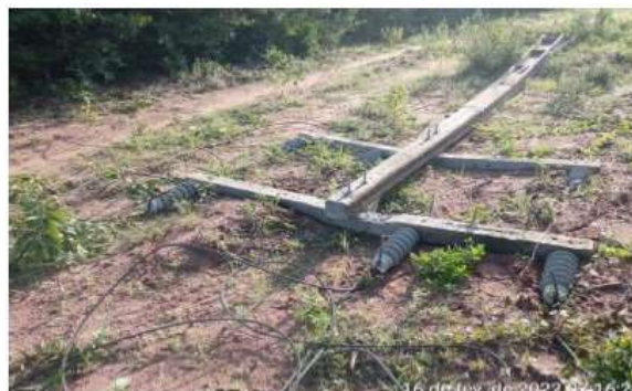
Imagem 4 – Visão da Usina Embuaca e detalhes de postes derrubados para roubo de cabo
