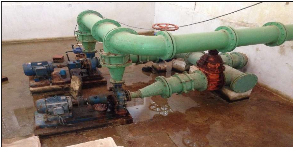
Figura 53 – Bombas da EEAT-01 e EELF-01 da ETA Itapebussu.
