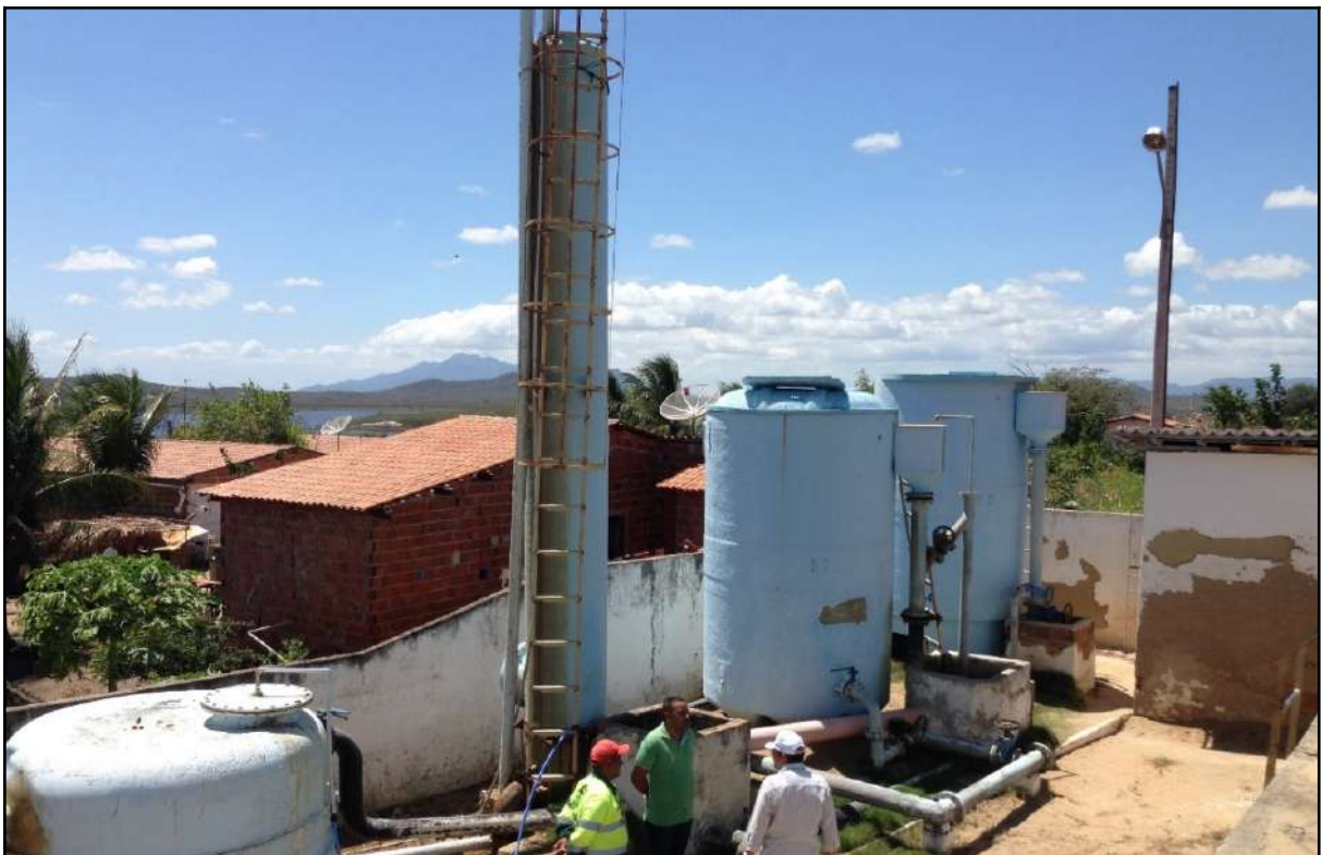
Figura 59 – Torre de Nível da ETA Amanari.
