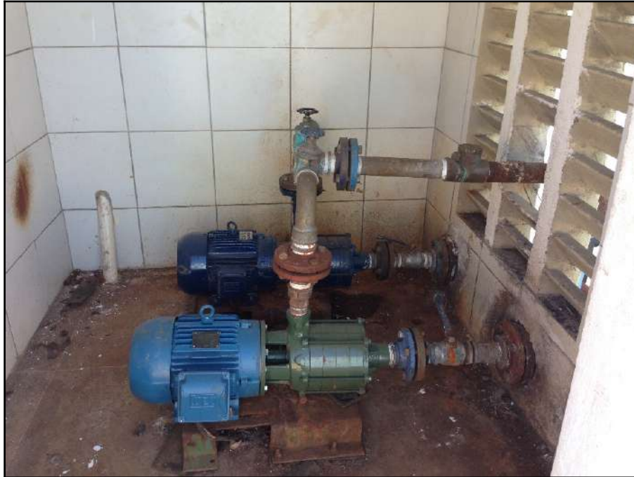
Figura 30 – Bombas Estação Elevatória – EERD-03 (Booster) da ETA Maranguape.
