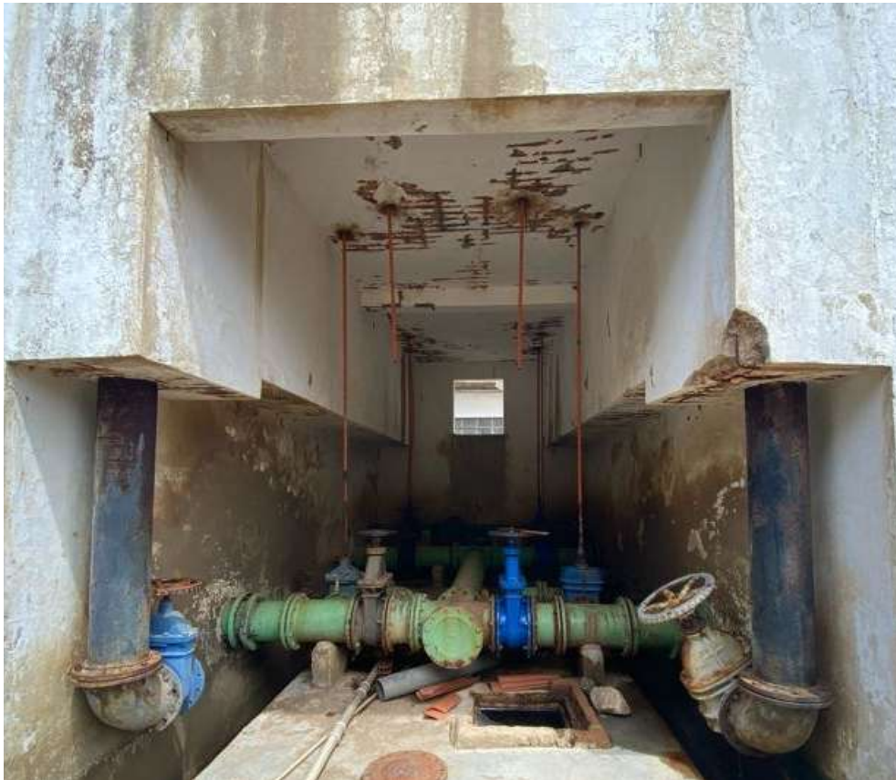
Figura 40 – Vista da parte inferior da laje de operação da ETA de Sapupara – Notar a ferrugem toda exposta.
