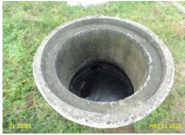
ETE: Poço de Visita
