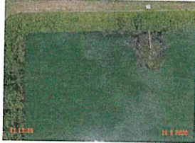
Foto 28 - ETE: entrada da LF-02 assoreada e obstruída.
