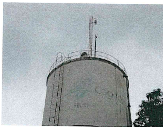
Foto 35 – REL-01: escada de acesso em processo de corrosão.
