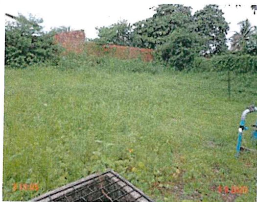
Foto 26 - Área de tratamento: excesso de vegetação.
