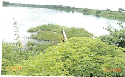
Foto 11 - ETE: saída da LF-01 obstruída.
