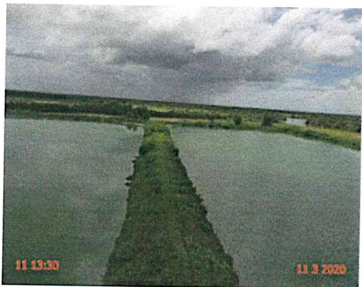
Foto 14 - ETE: excesso de vegetação nos diques das lagoas.
