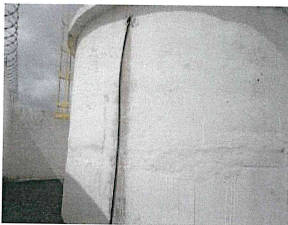
Foto 3 – RAP-03: ausência de medidor de nível.
