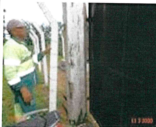
Foto 27 - EEE-01: cerca danificada
