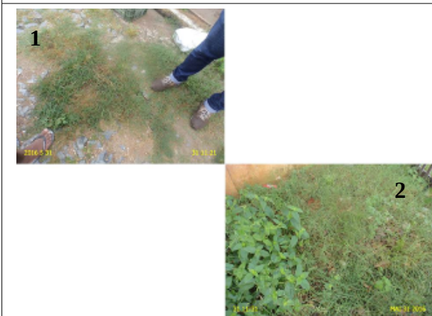
Foto 17 - RDA: registros de descarga soterrados: Rua Gilberto Bernardo (1) e Rua Raimundo Antero (2).
