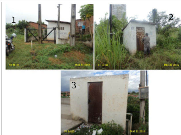
Foto 03 - EAT: elevatórias de água sem identificação – EAT-05 (1), Booster São Francisco (2) e Booster Tamanduá (3).
