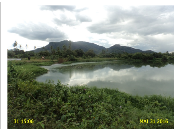
Foto 15 – RAP-09 e RAP-10: vegetação excessiva na área do reservatório.
