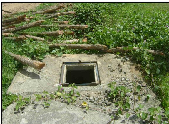
**Foto 12**– Medidor proporcional desativado sem tampa de proteção.
