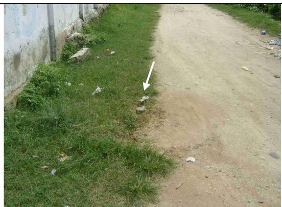
**Foto 18** – Registro de descarga com tampa de proteção improvisada localizado na Rua Godofredo Correia.
