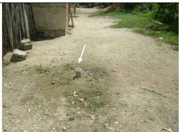
**Foto 20** – Registro de descarga com tampa de proteção improvisada localizado na Rua Pedro Gerônimo da Silva.
