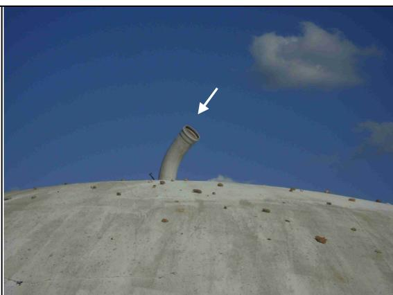
**Foto 8** – Tubulação de ventilação inadequada - RAP-09.
