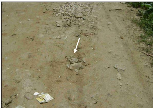
**Foto 17** – Registro de descarga com tampa de proteção improvisada localizado na Rua Chico Pedro.
