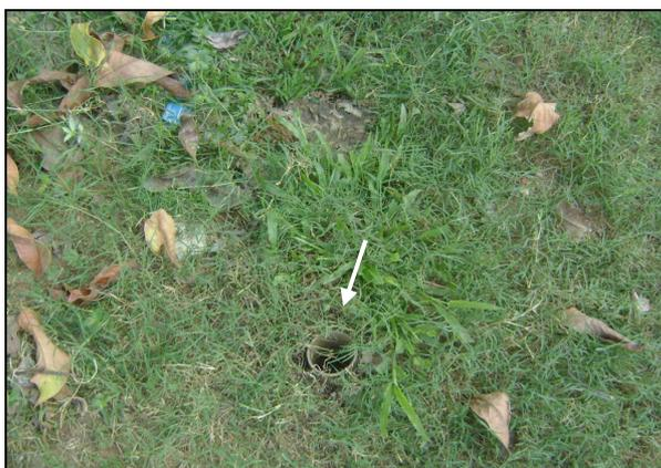
**Foto 21** – Registro de descarga sem tampa de proteção localizado na Rua Raimundo Antero.
