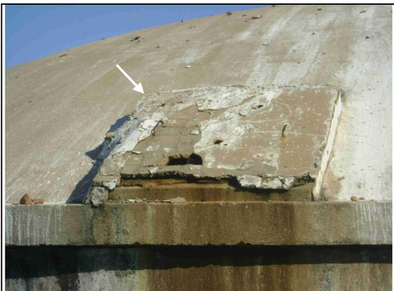
**Foto 7** – Tapa de inspeção danificada – RAP 09.
