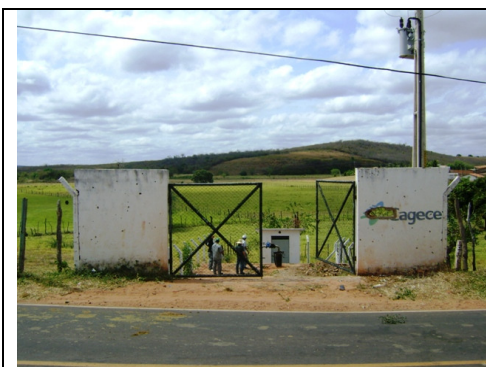
Foto 3 – Vista da entrada da área da captação
