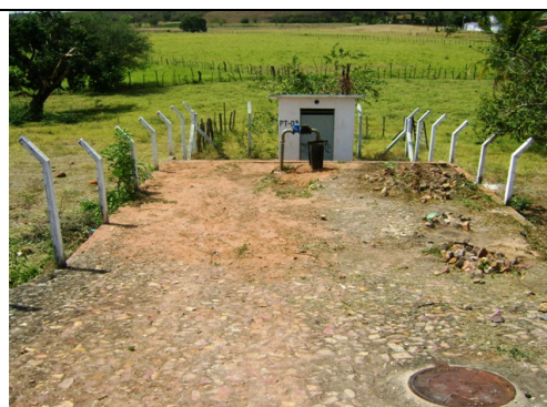
Foto 4 – Vista interna da área da captação
