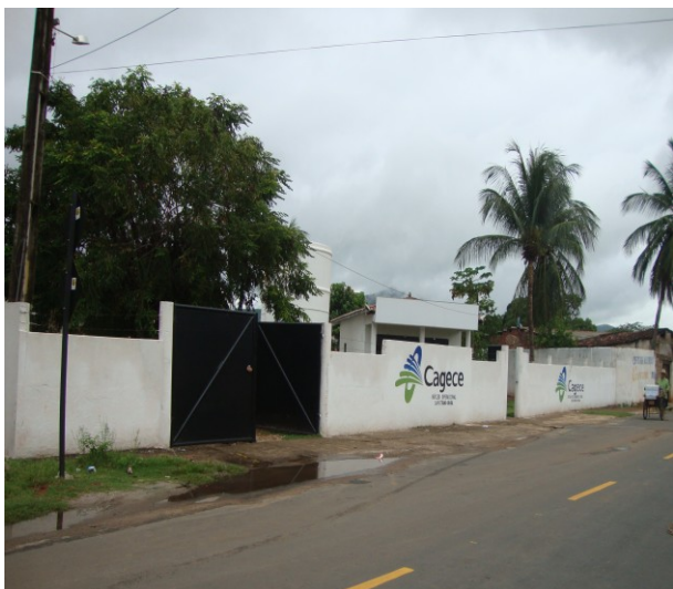
Foto 7 – Vista externa da ETA.
