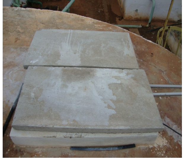
Foto 43 – RSE-01: Instalação adequada das tubulações de produtos químicos.
