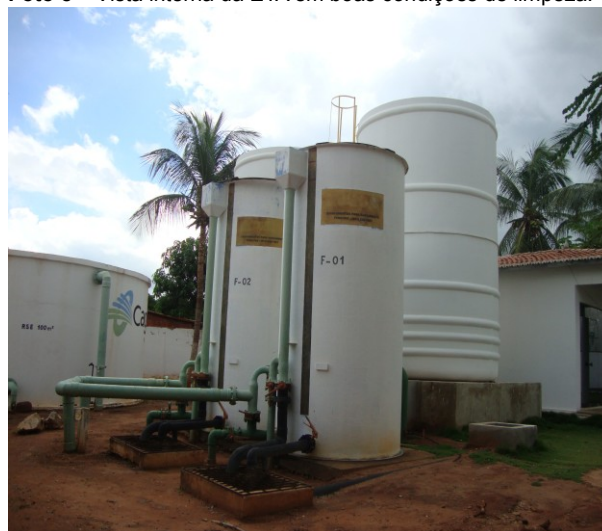
Foto 10 – ETA: Filtros identificados e apresentando bom estado de conservação e limpeza.
