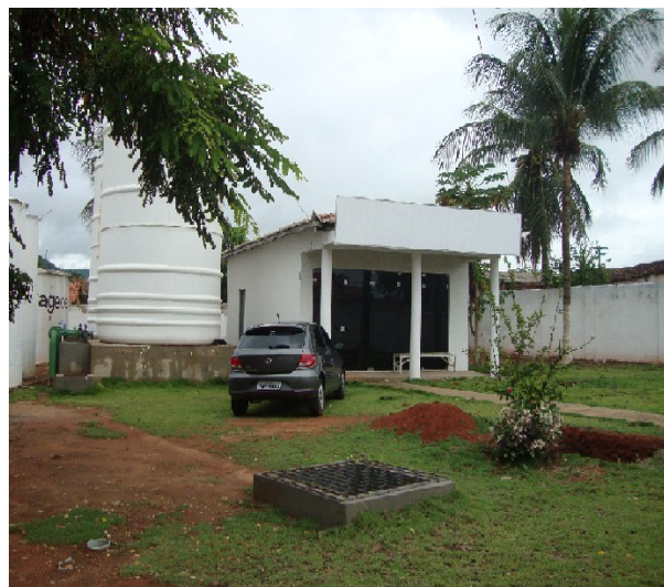
Foto 8 – Vista interna da ETA em boas condições de limpeza.
