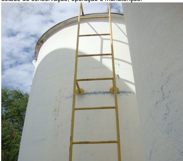
Foto 11 – ETA: Escada de acesso para os filtros.
