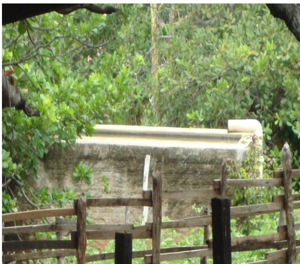
Foto 13 – Tanque de recepção das águas de lavagem dos filtros, localizado no terreno vizinho à ETA.
