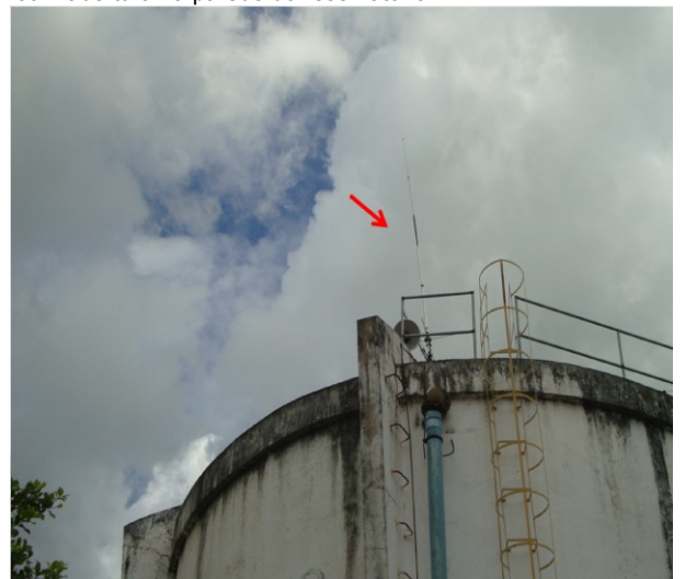
Foto 47 – REL-01: Desativado com existência de para-raios e sinalizador noturno.
