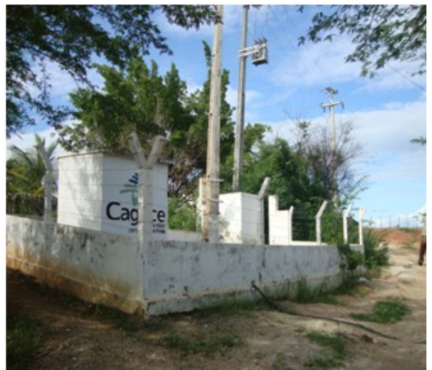
Foto 4 – Vista da EECS-01.
