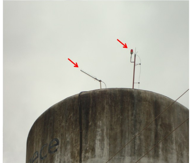
Foto 49 – REL-02: Com existência de para-raios e sinalizador noturno.
