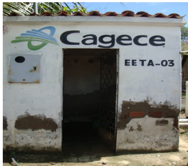
Foto 37 – Casa do quadro de comando do conjunto moto-bomba com reserva da EECS-03.
