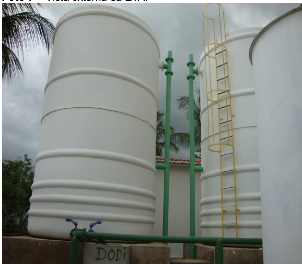
Foto 9 – ETA: Decantadores de manta de lodo ativado em bom estado de conservação, operação e manutenção.
