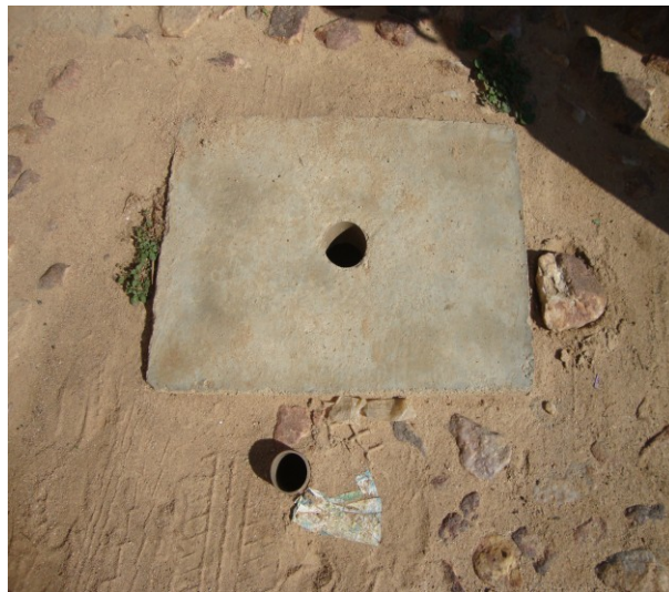
Foto 55 – Registro de descarga localizado na Rua Dona Videlina.
