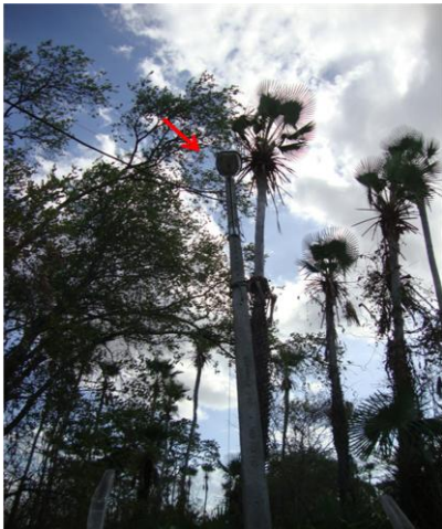
Foto 9 – PT-06: iluminação externa.
