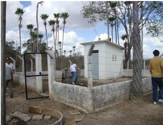
Foto 1 – PT-05: vista geral.
