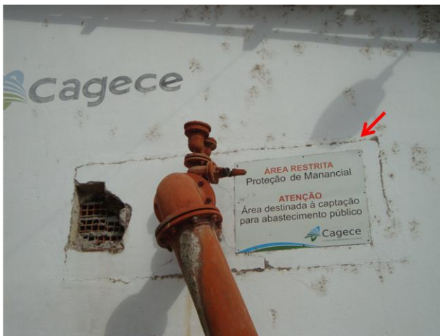
Foto 50 – Sinalização da captação.
