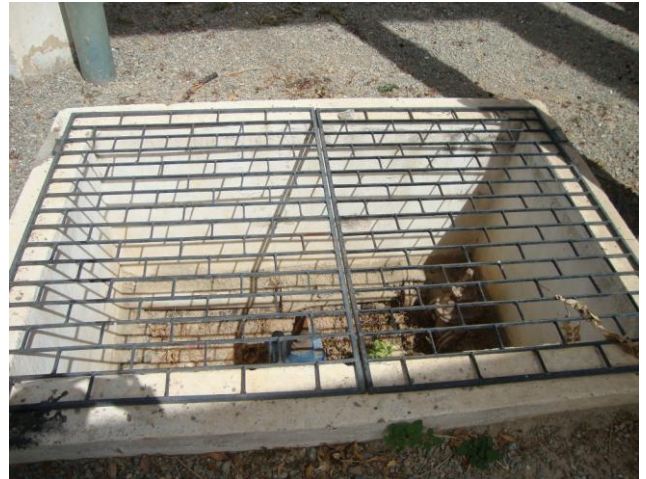
Foto 44 – Registro instalado na adutora de água tratada na área da ETA.
