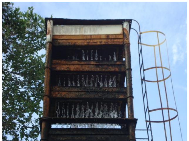
Foto 18 – Aerador com escada de acesso.
