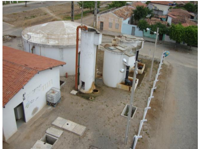
Foto 14 – Vista superior da ETA.
