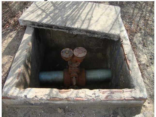
Foto 40 – Ventosa instalada na adutora de água bruta.
