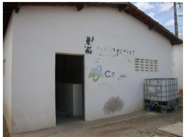
Foto 24 – Vista da casa de química.
