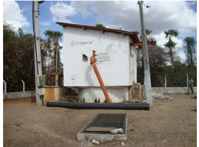
Foto 49 – Prédio de abrigo da EEAB-01.
