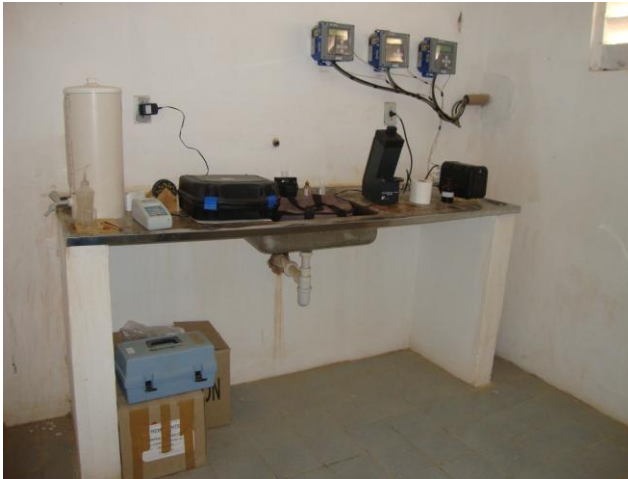
Foto 31 – Vista do laboratório da ETA.
