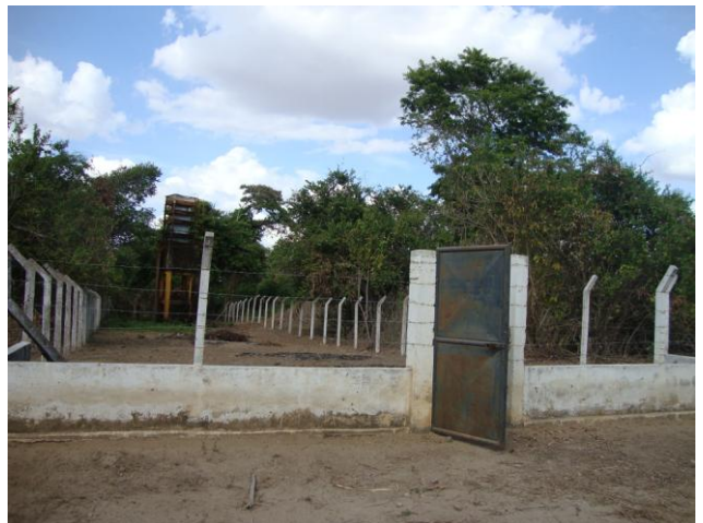
Foto 16 – Vista externa do aerador.
