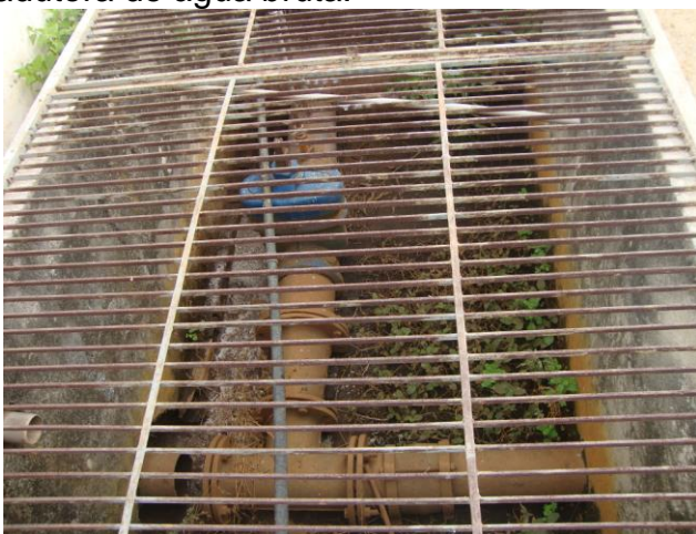
Foto 41 – Registro instalado na adutora de água bruta na área da ETA.
