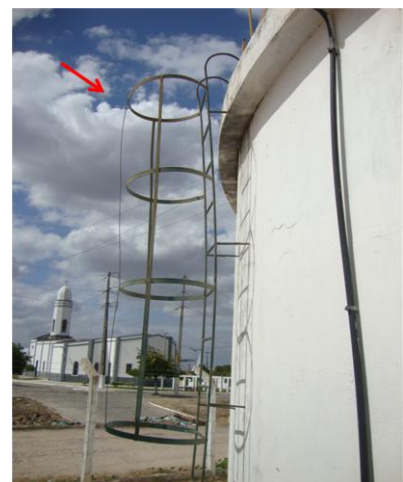
Foto 59 – RAP-01: com guarda-corpos na escada de acesso.
