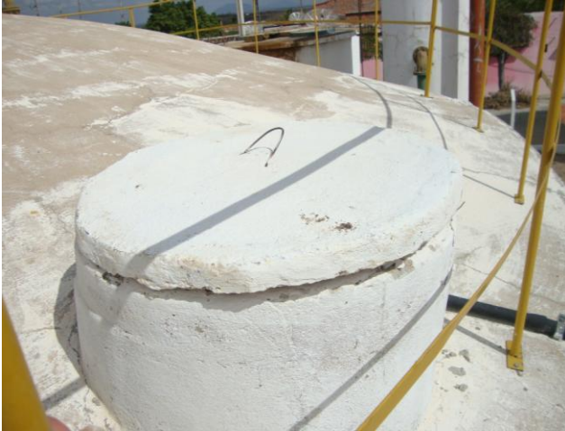
Foto 60 – RAP-01: com tampa de inspeção.
