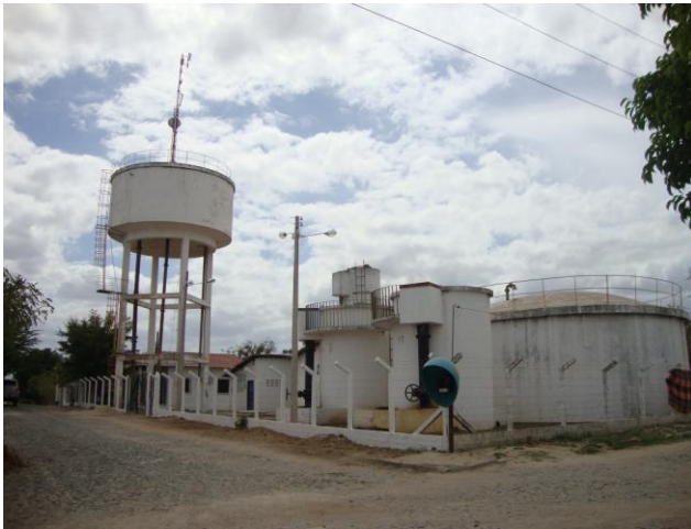
Foto 13 – Vista externa da ETA.
