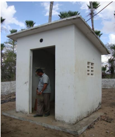
Foto 11 – PT-06: casa de abrigo do quadro de comando.
