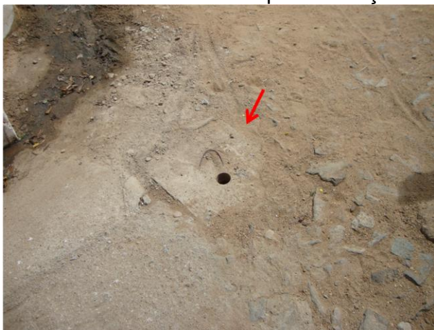
Foto 85 – Registro de descarga na Rua Sebastião Miranda – Bairro Japão.
