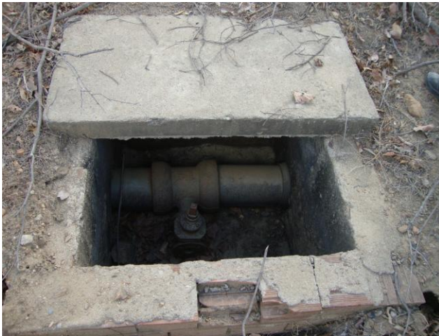
Foto 37 – Registro instalado na adutora de água bruta.
