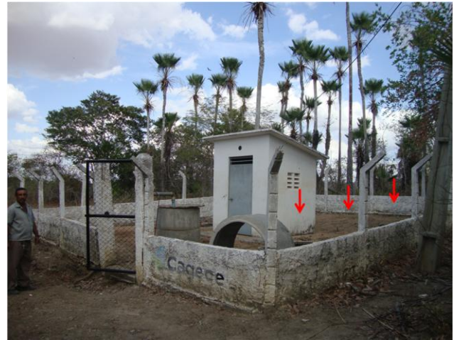
Foto 8 – PT-06: vista geral.
