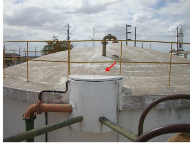
Foto 61 – RAP-01: caixa coletora com tampa de inspeção.
