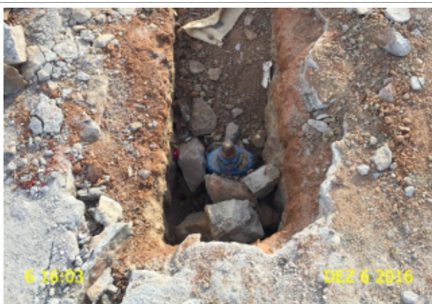
Foto 6 – RDA: registro de descarga sem caixa na Rua José Linard de Lima.
