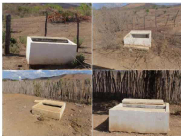
Foto 4 – AAB: caixas sem tampa ou grade de proteção.
