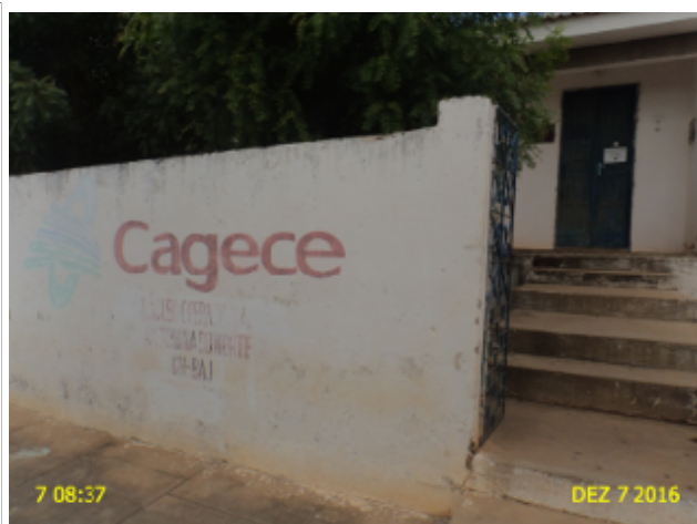
Foto 13 – Escritório: identificação apagada.
