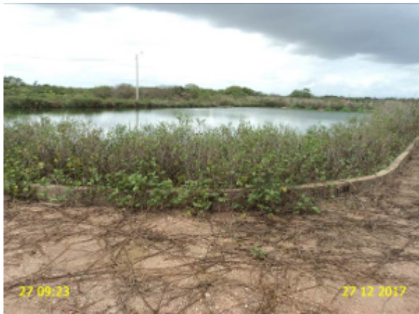
Foto 29 – ETE (Sede): vegetação excessiva na Lagoa de Maturação LM (2).
