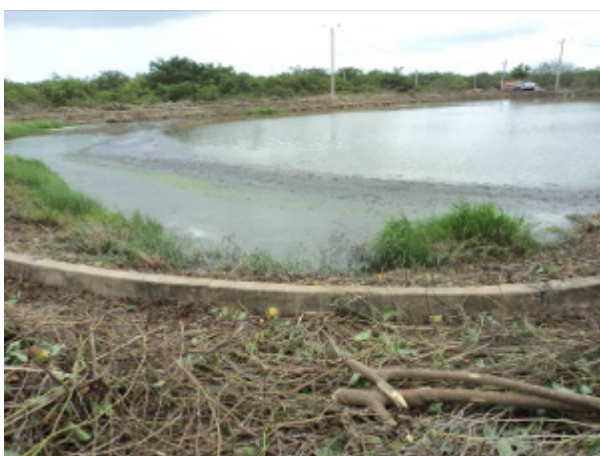
Foto 29 – ETE (Sede): vegetação excessiva na Lagoa de Maturação LM (2).
