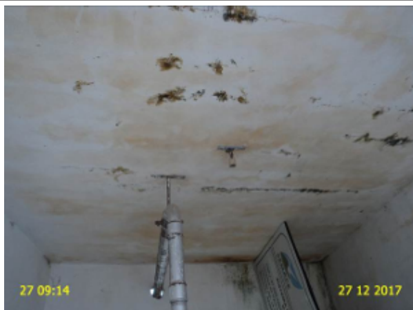
Foto 36 – EEE-02 (Sede): ausência de lâmpada na casa de abrigo do grupo gerador de energia.
