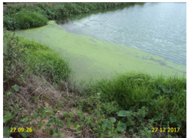
Foto 30 – ETE (Sede): acúmulo de sobrenadantes na Lagoa de Maturação LM (1).
