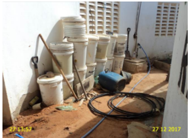
Foto 46 – ETA (Jericoacoara): acúmulo de materiais no pátio externo.
