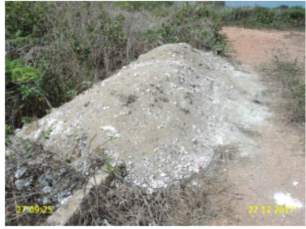
Foto 32 – ETE (Sede): material disposto fora do leito de secagem.
