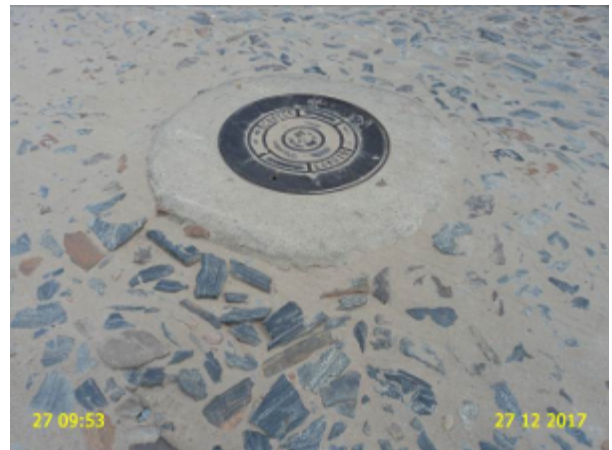
Foto 50 – RCE (Sede): PV localizado na Rua Minas Gerais, em frente à Churrascaria Tradição Gaúcha, acima do nível do calçamento.
