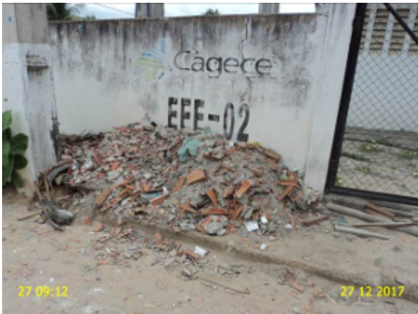
Foto 40 – EEE-02 (Sede): acúmulo de resíduos na entrada da elevatória.
