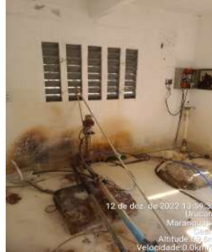
Foto 16 - PA-01: área interna em mau estado de conservação, presença de vazamento e área alagada, em contato com tubulação elétrica.
