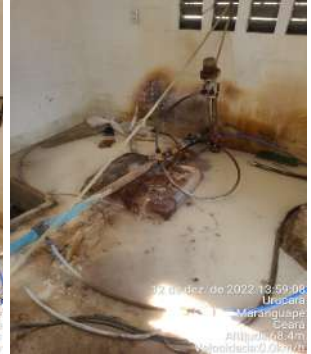
Foto 16 - PA-01: área interna em mau estado de conservação, presença de vazamento e área alagada, em contato com tubulação elétrica.
