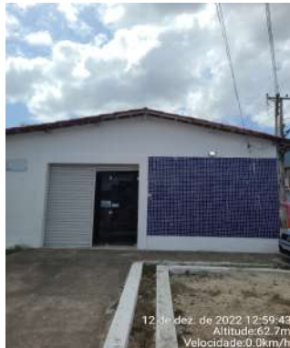
Foto 1 - Escritório CAGECE: ausência de identificação.
