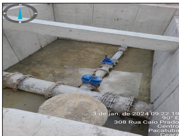
Foto 4 Ramificação da adutora.
