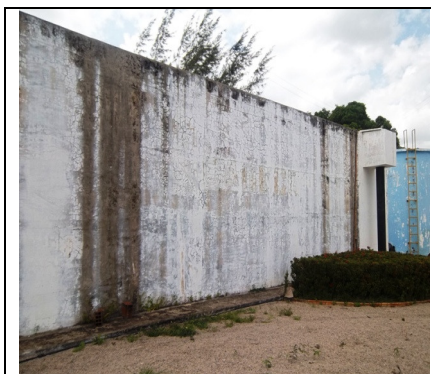
Foto 30 – Vista lateral do RAP-02
