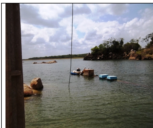
Foto 1 – Detalhe do flutuante
