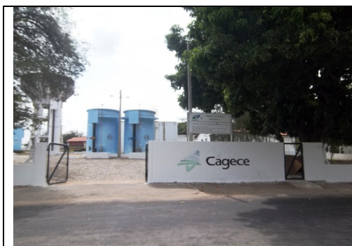
Foto 5 – Vista da entrada da ETA do SAA de Itaitinga
