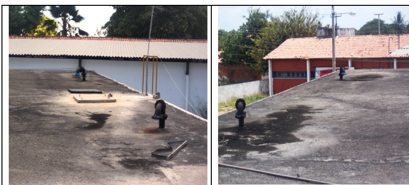
Fotos 31 e 32 – Vistas superiores do RAP-02
