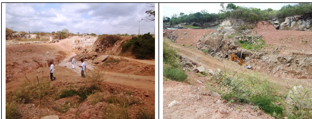
Fotos 3 e 4 – Vista das obras do segundo canal
