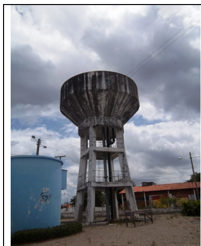
Foto 33 – Vista do REL-01
