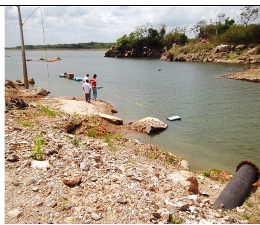
Foto 2 – Vista da área de captação
