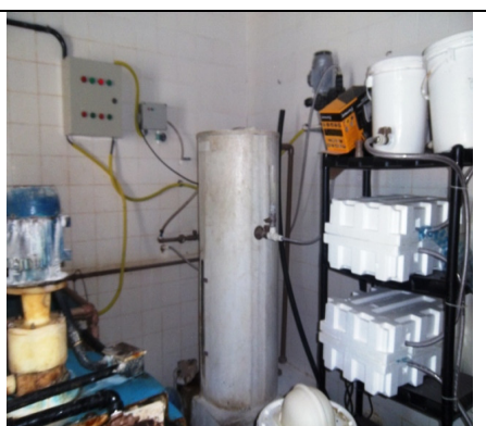
Foto 15 – Sistema de fluoretação
