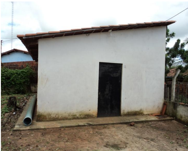
Foto 39 – Vista externa do almoxarifado.
