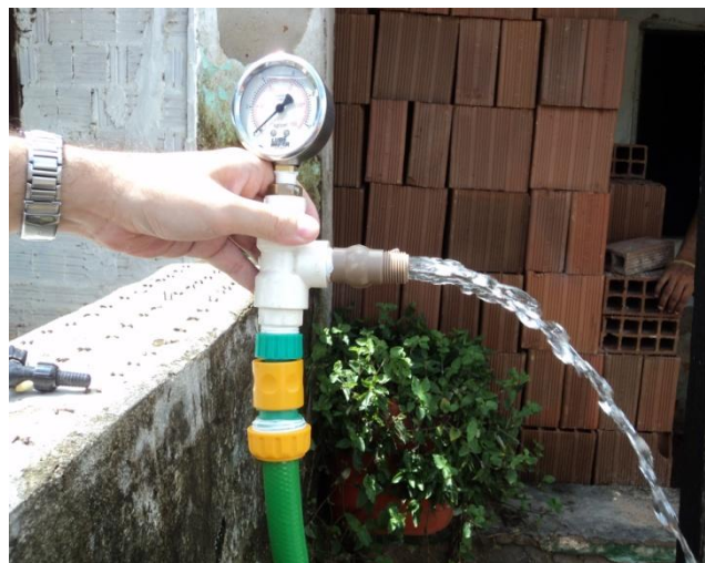
Foto 32 – Medição instantânea de pressão na Rua Sabino Moreira, nº 37 – Centro.
