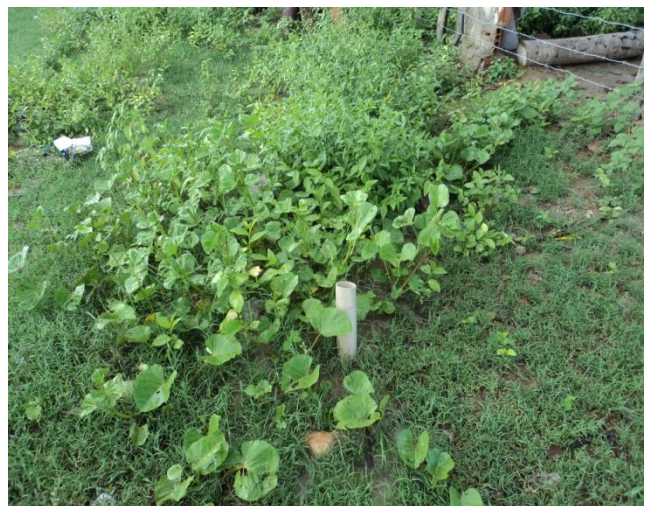
Foto 30 – Rede de Distribuição: registro de descarga na Rua Francisco Sabino de Jesus.
