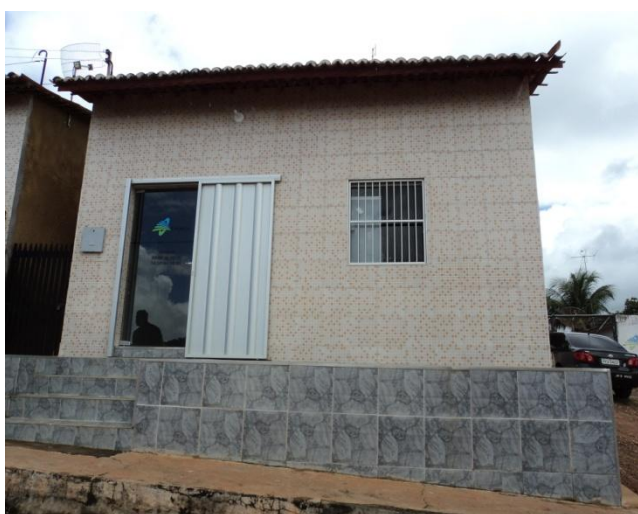
Foto 33 – Vista externa do escritório/loja de atendimento/almojarifado.
