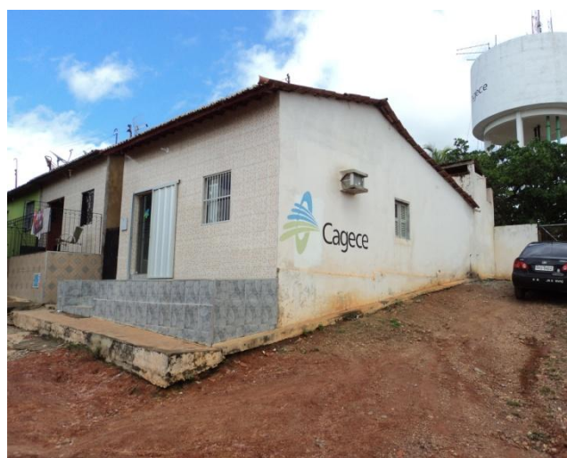
Foto 34 – Vista externa do escritório/loja de atendimento/almojarifado.
