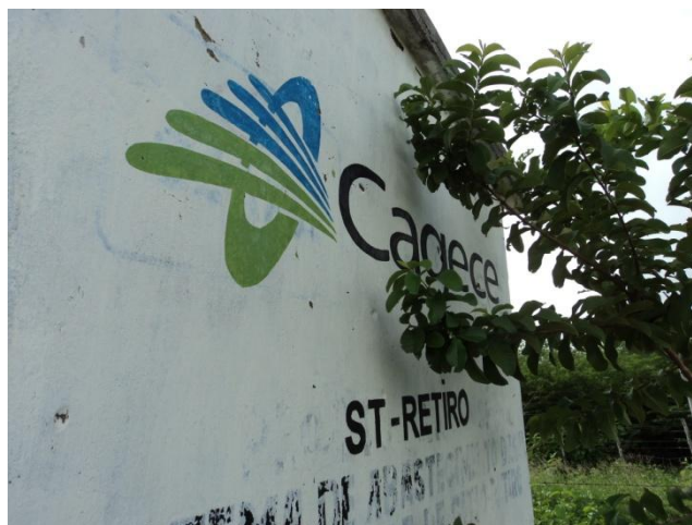
Foto 4 – Identificação do booster Sítio Retiro.
