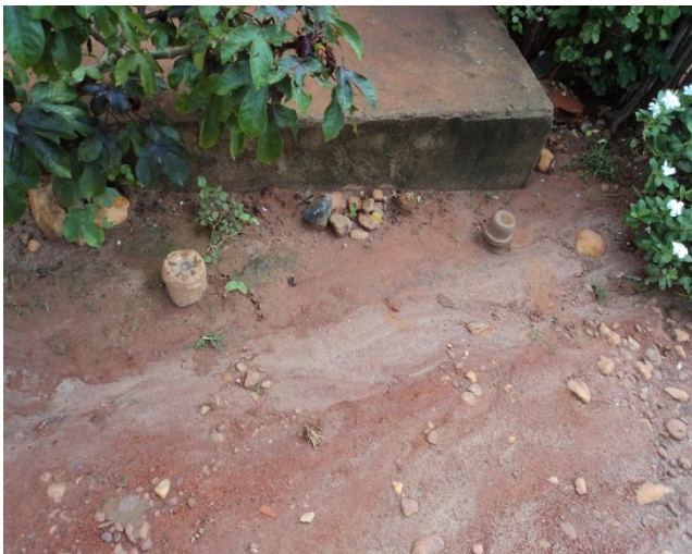
Foto 27 – Rede de Distribuição: registro de descarga na Rua Jerônimo de Carvalho.
