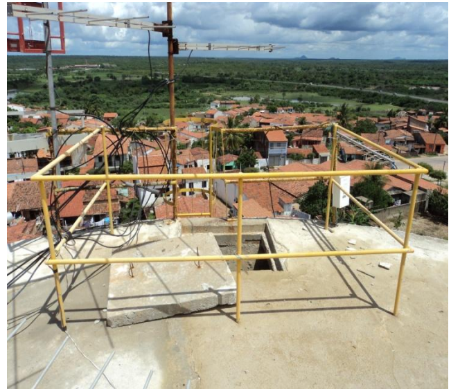
Foto 14 – REL-04: existência de guarda-corpo na laje de cobertura em adequadas condições de uso.
