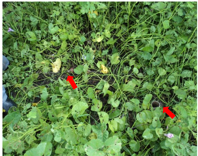
Foto 28 – Rede de Distribuição: registro de descarga na Rua Sem Denominação nº24.
