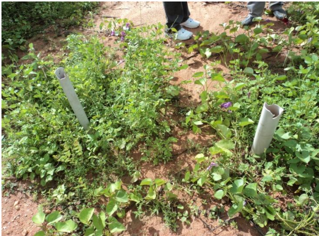
Foto 25 – Rede de Distribuição: registro de descarga na Rua Sem Denominação nº 20.
