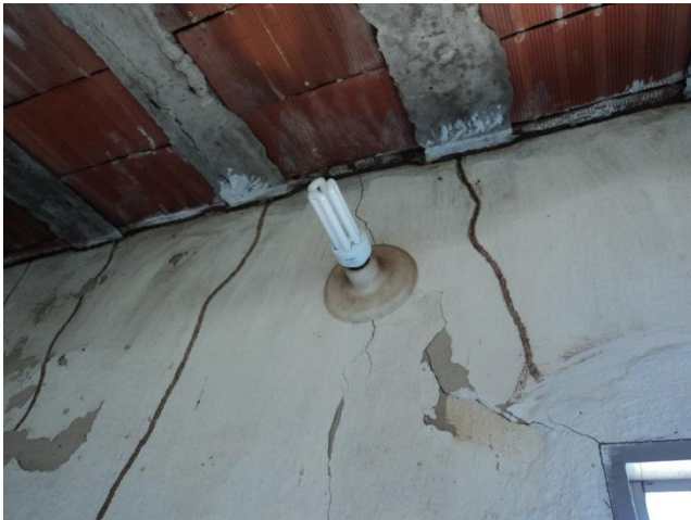
Foto 7 – Condições de iluminação do booster Sítio Retiro.
